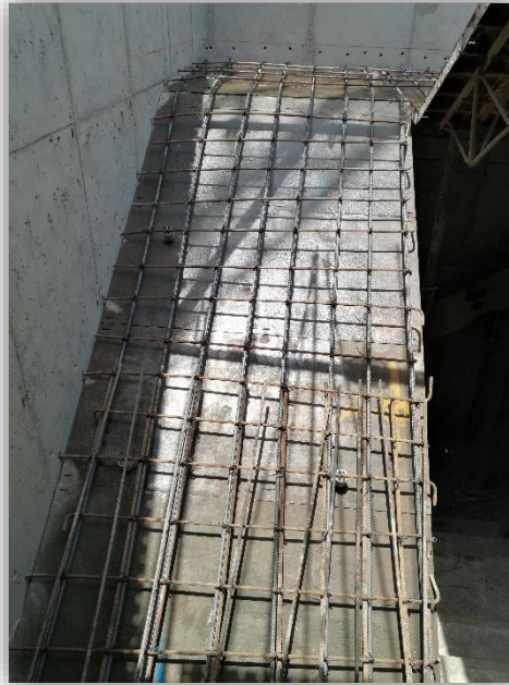
Ilustración 22: Armado de Acero para escaleras
