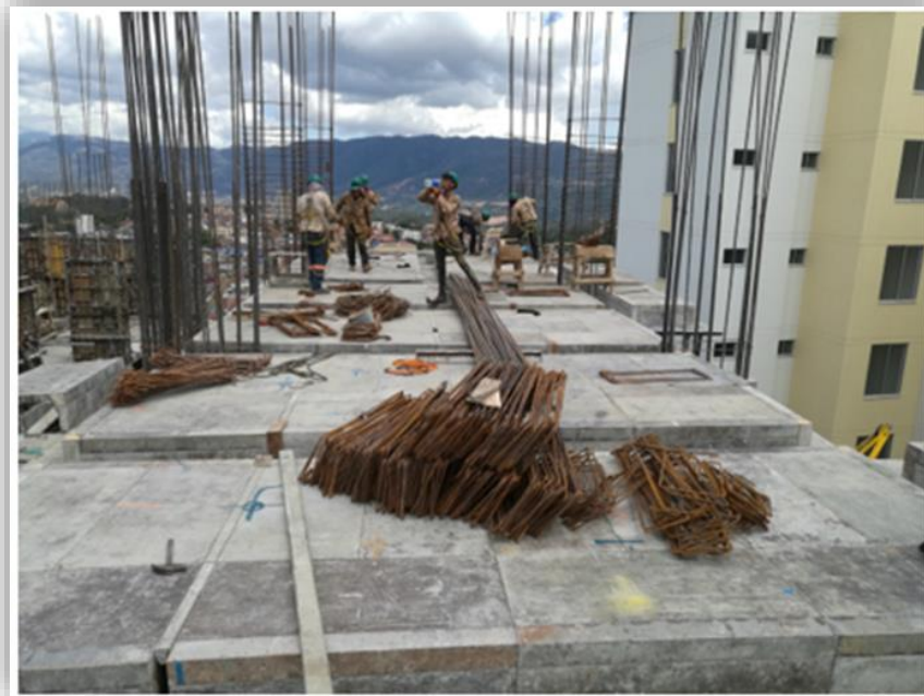
Ilustración 18: Acero de Vigas
