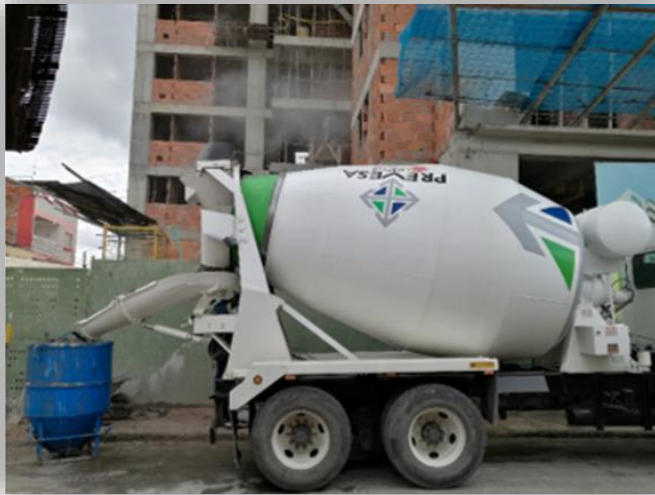
Ilustración 13: Llegada del concreto
