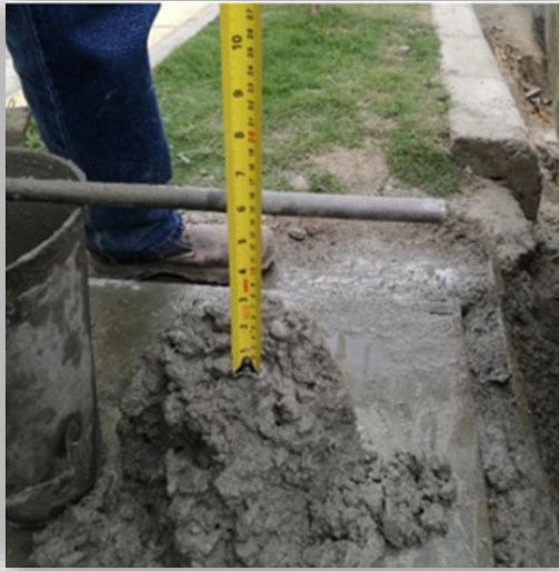
Ilustración 14: Toma de asentamiento
