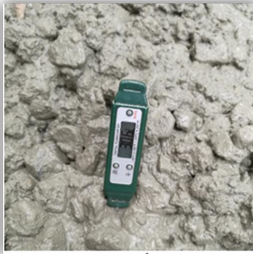
Ilustración 15: Toma de temperatura
