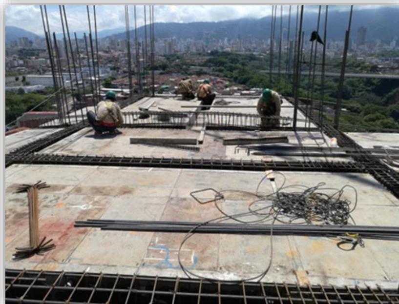
Ilustración 19: Armado de Vigas
