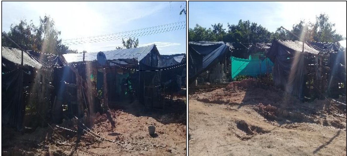
IMAGEN 39 Campamento de almacenamiento de material – Proyecto DICAR Fuente: Propia
