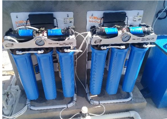
IMAGEN 26 Control de presiones PTAP – Proyecto DICAR Fuente: Propia
