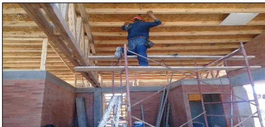
IMAGEN 40 EPP para acabados, en andamio – Proyecto DICAR Fuente: Propia
