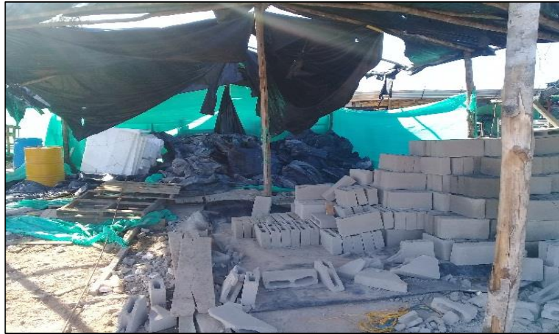
IMAGEN 38 Almacenamiento de bloques en concreto – Proyecto DICAR Fuente: Propia
