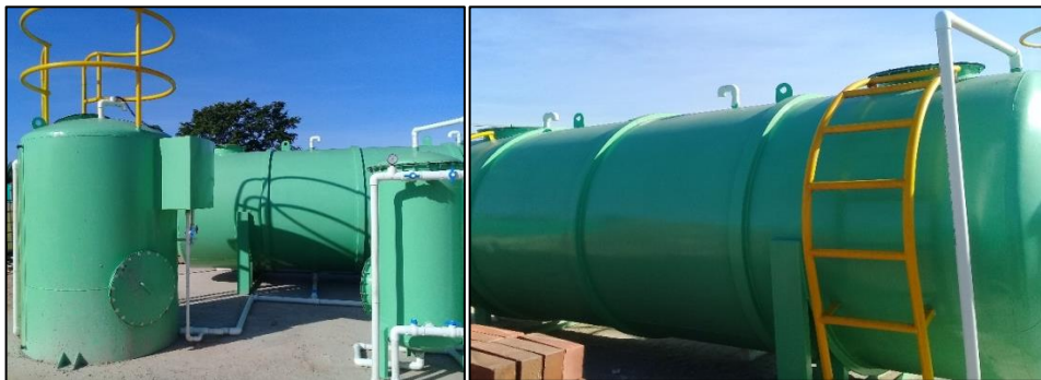
IMAGEN 31 Accesos para el mantenimiento de PTAR – Proyecto DICAR Fuente: Propia
