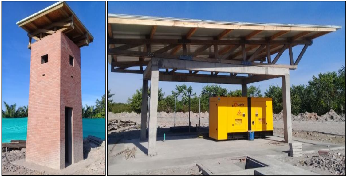
IMAGEN 35 Garita de Seguridad y Planta eléctrica – Proyecto DICAR Fuente: Propia
