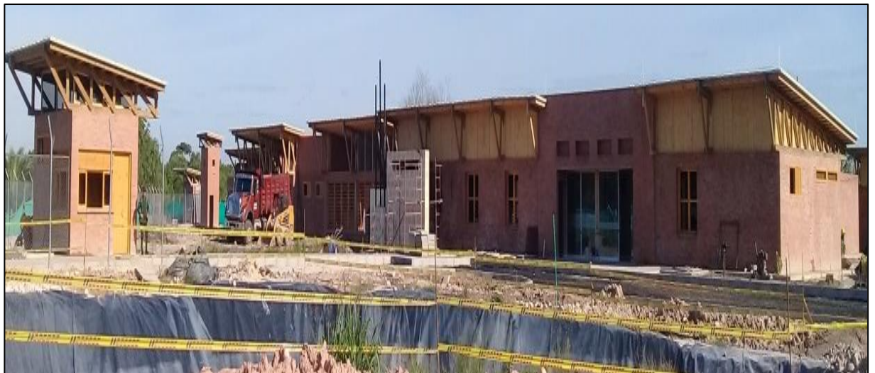
IMAGEN 34 Vista frontal de entrada y Casino – Proyecto DICAR Fuente: Propia
