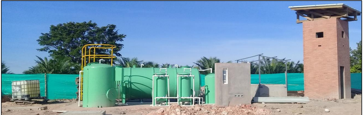
IMAGEN 30 Vista lateral de la PTAR – Proyecto DICAR Fuente: Propia
