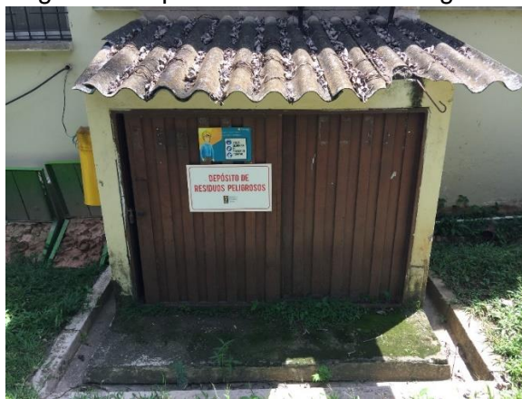
Figura 3. Depósito de Residuos Peligrosos
