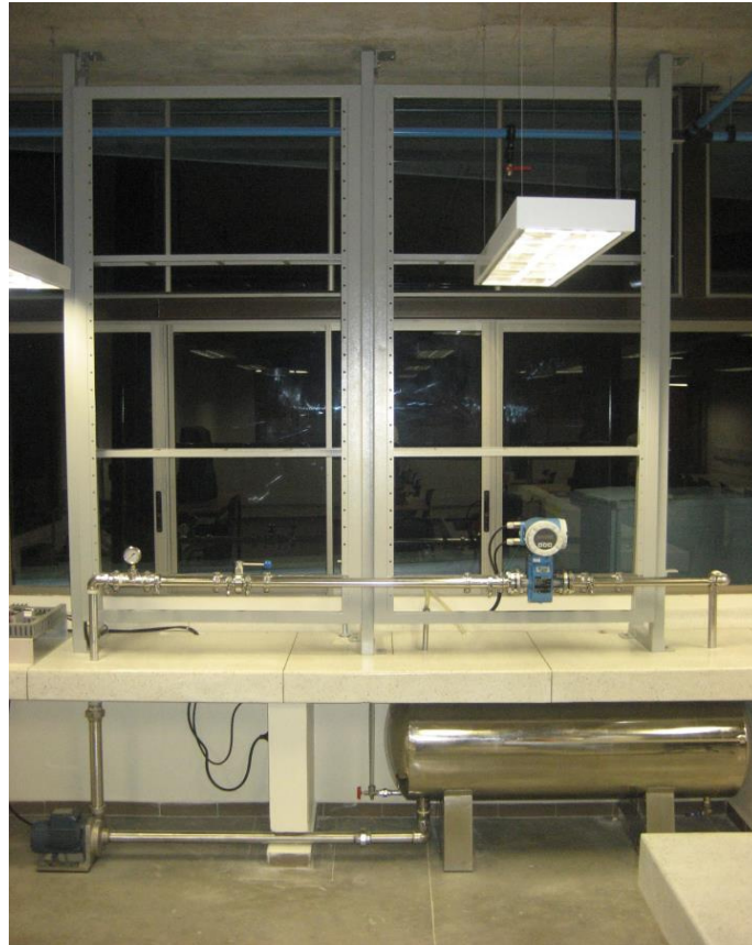
Figura 9. Banco de ensayos y calibración Fase 2 espacio real. 18
