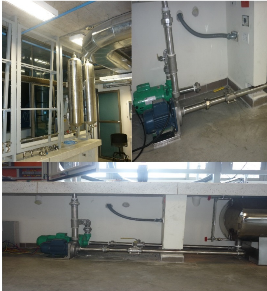
Figura 22. Instalación del Frame, bombas y Tanques.
