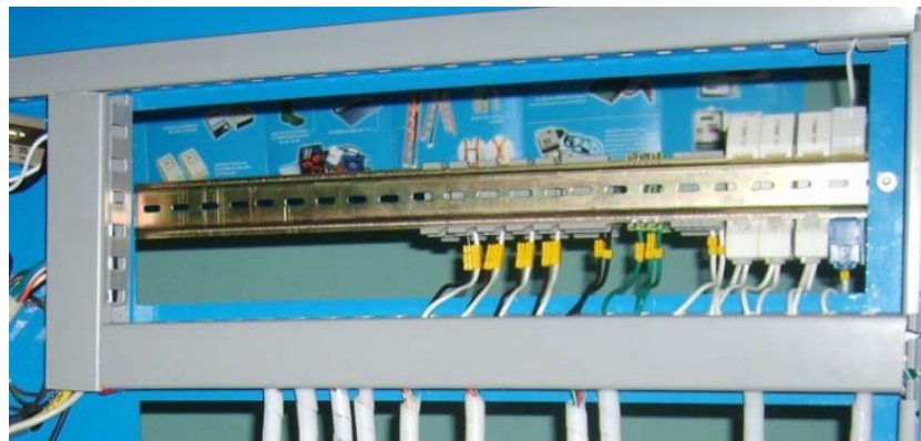
Figura 32. Canaleta ranurada y riel omega instalados en el rack.
