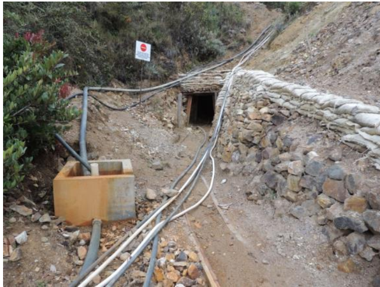
FOTOGRAFÍA No: 05 LUGAR: La Botella 1 OBSERVACIONES: Captación y conducción de aguas de mina
