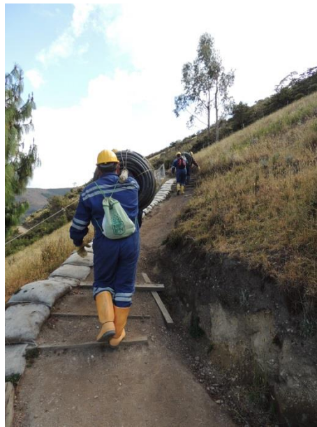
FOTOGRAFÍA No: 27 LUGAR: RM OBSERVACIONES: Instalación de líneas de conducción
