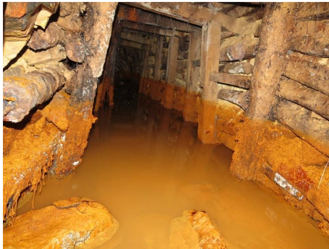
FOTOGRAFÍA No: 08 LUGAR: Santa Isabel II OBSERVACIONES: Aspecto interior de túnel minero en proceso de manejo, recuperación y sostenimiento.
