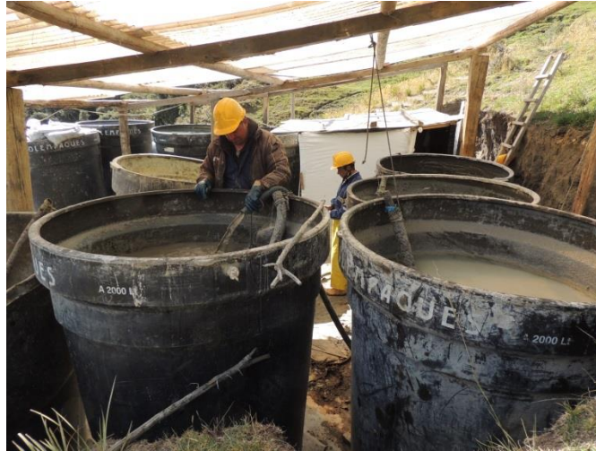
FOTOGRAFÍA No: 17 LUGAR: ED - 04 OBSERVACIONES: Manejo y tratamiento de lodos de perforación
