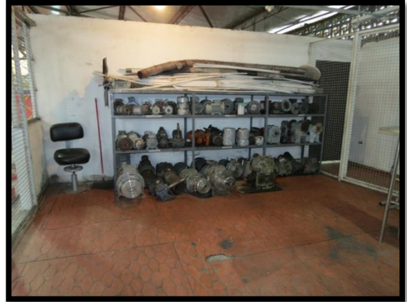
b. Estado final del área de Motores
