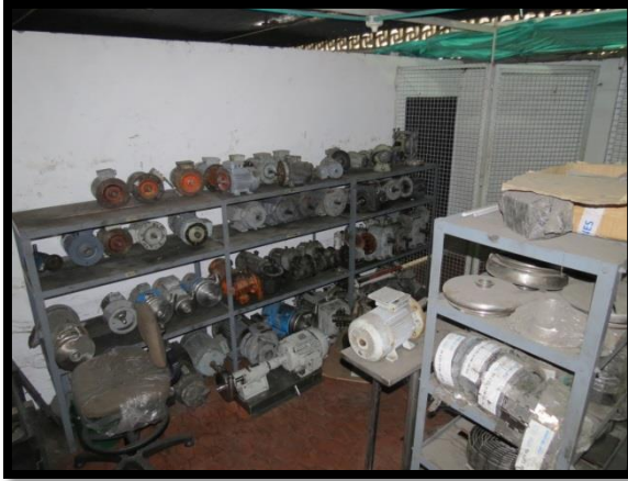
a. Estado inicial del área de motores
