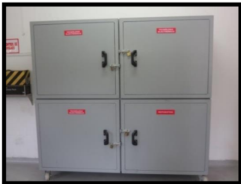
a. Locker de Electronicos Demarcado
