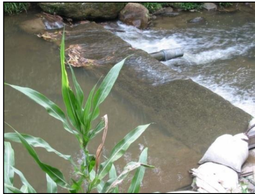
Imagen 17. Punto de captación Quebrada Aranzoque
