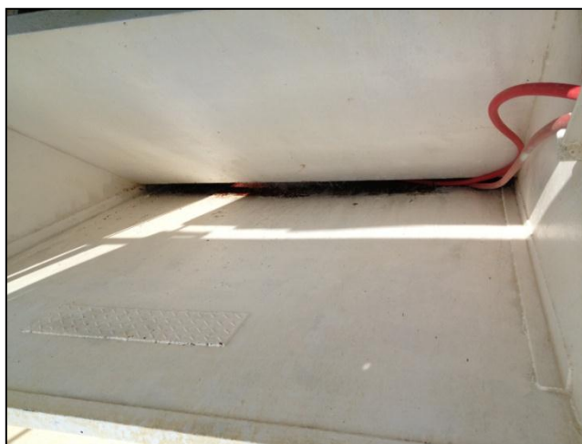
Imagen 21. Sistema de Floculación
