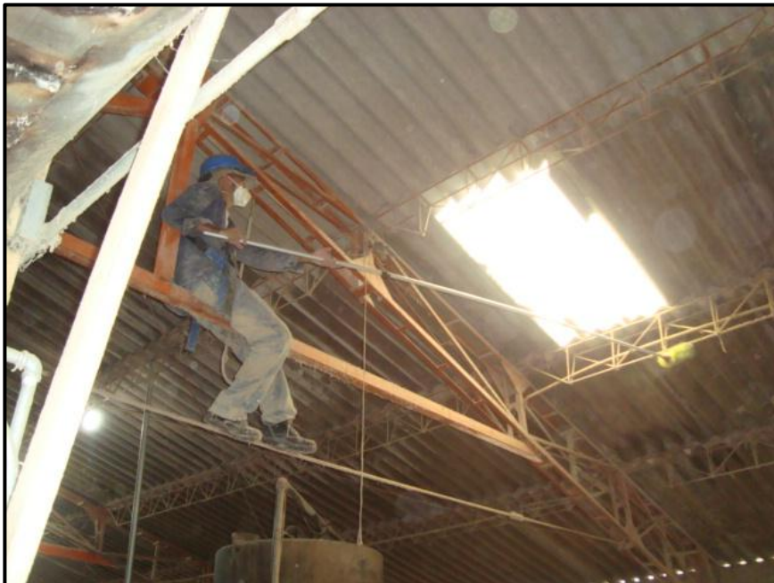
Figura 14. Limpieza interna de techos.
