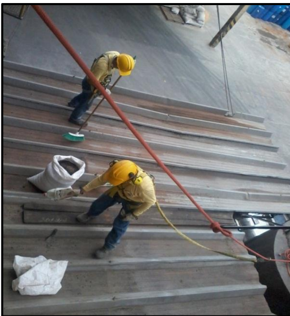
Figura 12. Limpieza externa de techos.
