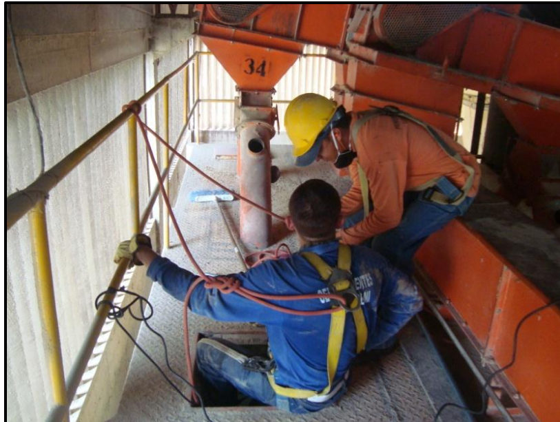
Figura 15. Limpieza interna de tolvas.
