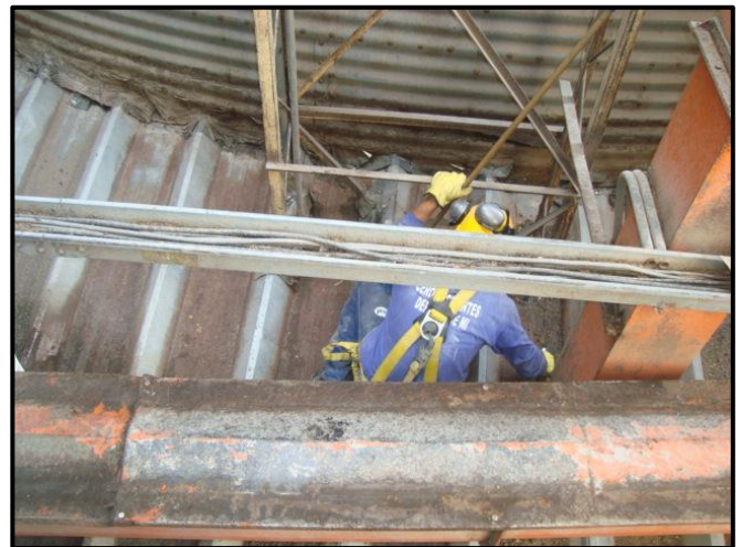
Figura 11. Reparación de fugas.
