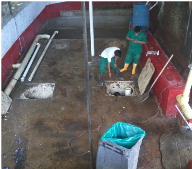
Fotografía 9. Tanque de Homogenización
