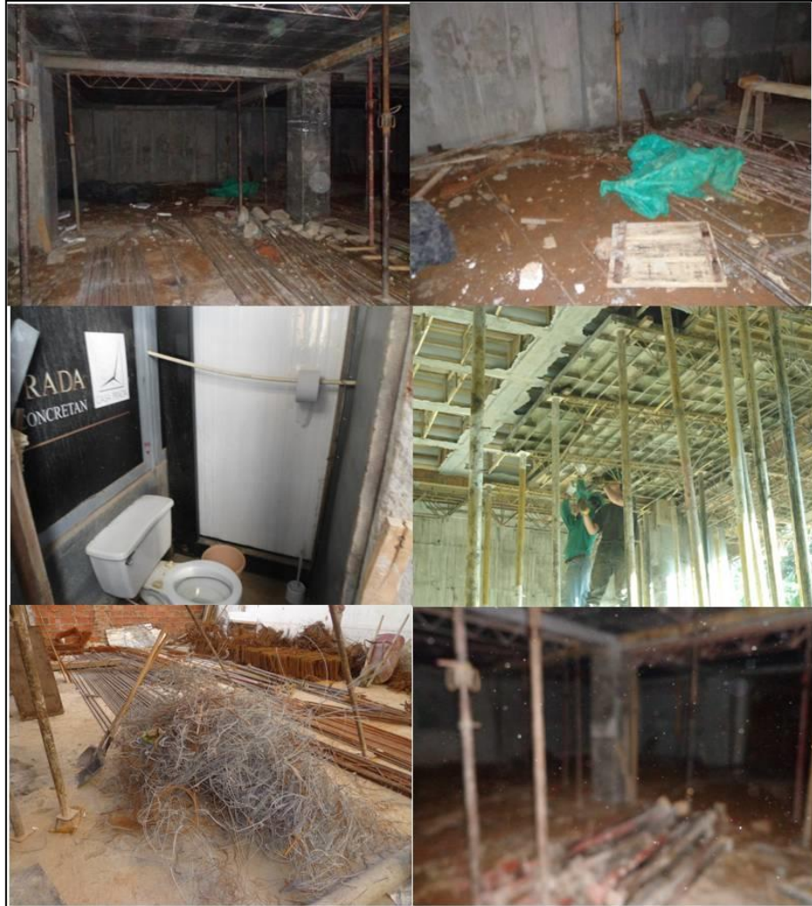
Fotos Inspección Obra 34
