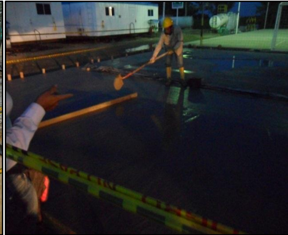
Imagen 15. Fundida concreto RH1
