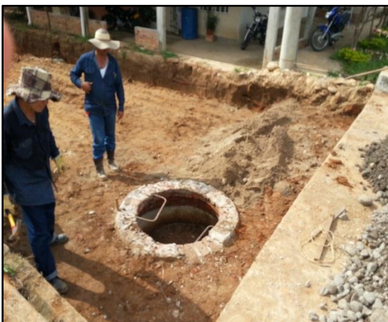
Imagen 77. Nivelación pozos alcantarillado Imagen78. Nivelación pozos alcantarillado
