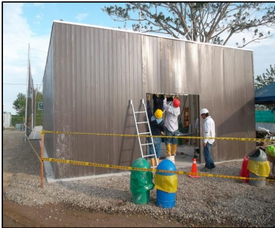
Imagen 22. Postura laminas confinamiento
