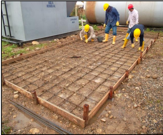
Imagen 38. Instalación acero de refuerzo RH5
