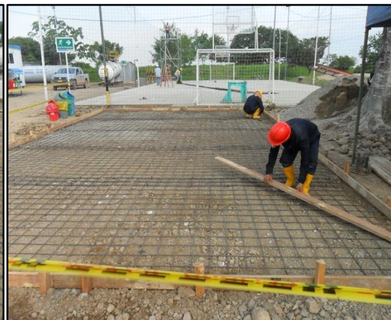
Imagen 13. Acero de refuerzo RH1
