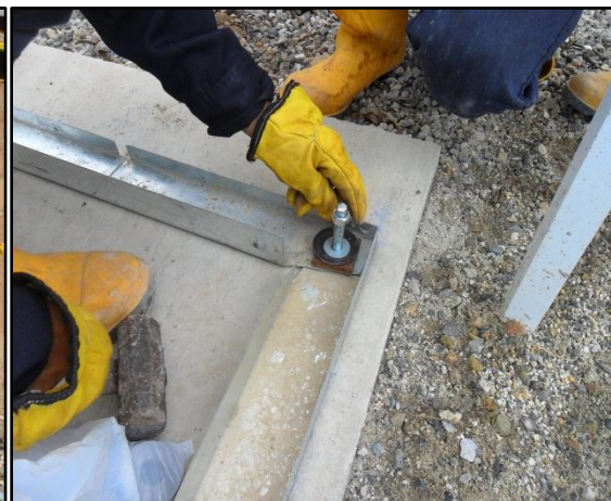
Imagen 21. Montaje rieles caseta
