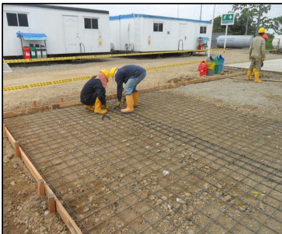
Imagen 12. Acero de refuerzo RH1
