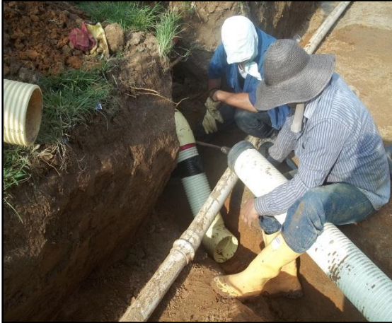
Imagen 75. Arreglo acometida de alcantarillado Imagen 76. Arreglo acometida de alcantarillado
