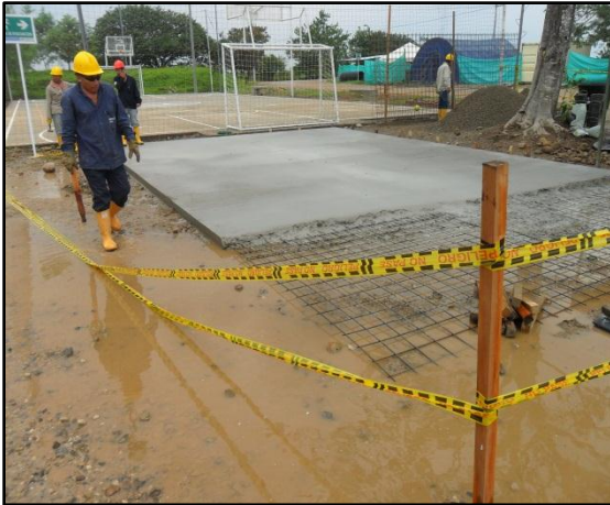
Imagen 14. Fundida concreto RH1
