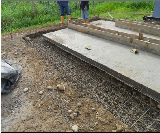
Imagen 42. Acero de refuerzo cárcamo perimetral
