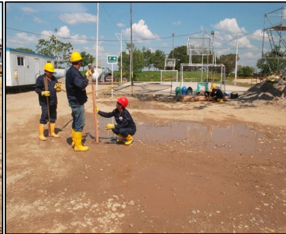
Imagen 5. Localización y replanteo RH1
