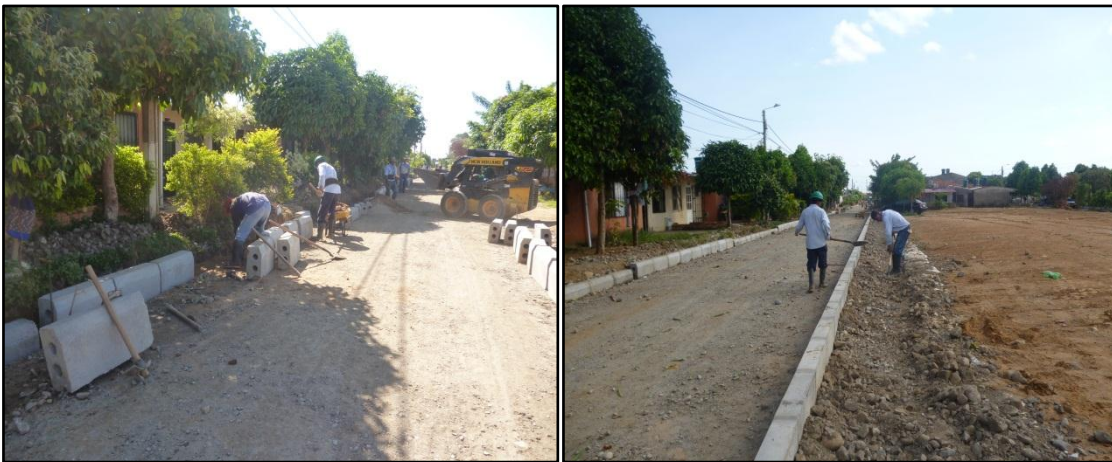
Imagen 79. Instalación de sardineles Imagen 80. Confinamiento de sardineles
