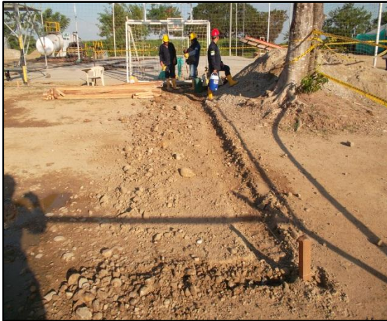
Imagen 6. Excavación manual RH1
