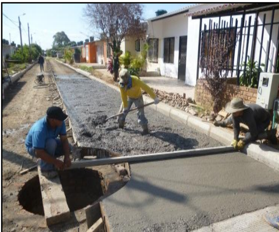
Imagen 86. Enrasado placas de concreto Imagen 87. Enrasado placas de concreto
