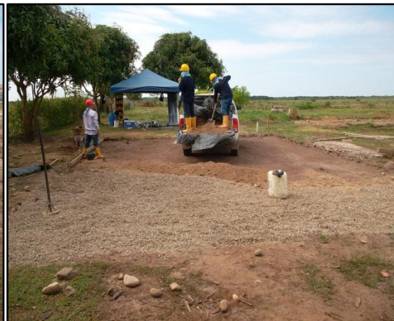
Imagen 54. Relleno manual Gasmocam
