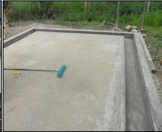
Imagen 43. Cárcamo perimetral RH5
