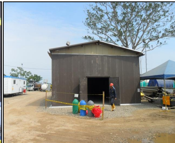
Imagen 29. Impermeabilización base caseta
