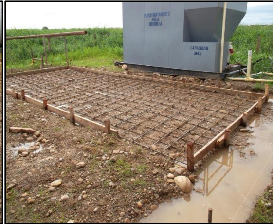
Imagen 39. Instalación acero de refuerzo RH5
