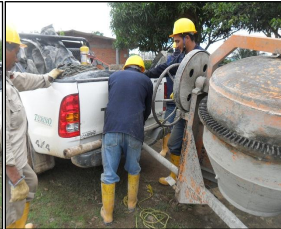
Imagen 49. Movilización de materiales Gasmocam
