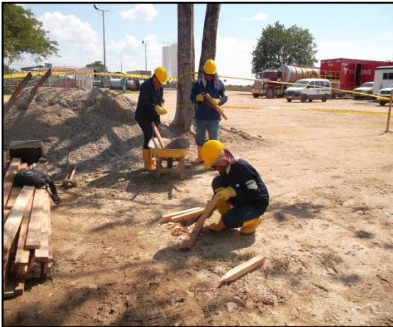
Imagen 4. Localización y replanteo RH1
