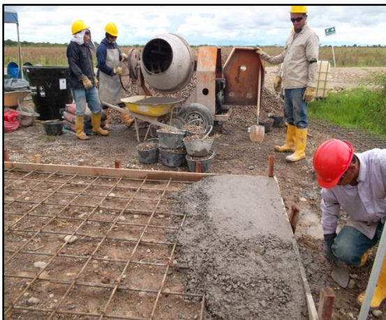
Imagen 40. Elaboración y vaciado concreto RH5
