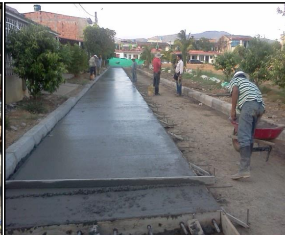
Imagen 86. Enrasado placas de concreto Imagen 87. Enrasado placas de concreto
