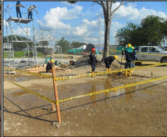
Imagen 7. Excavación manual RH1
