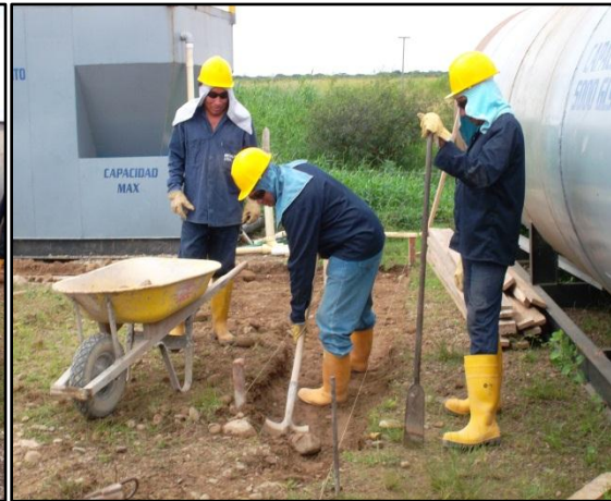
Imagen 35. Excavación manual RH5
