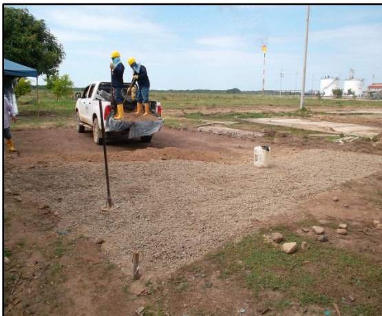
Imagen 53. Relleno manual Gasmocam
