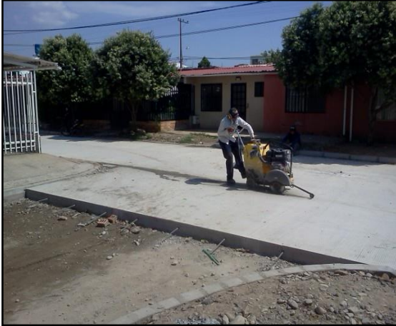
Imagen 88. Corte de dilataciones placas de concreto
