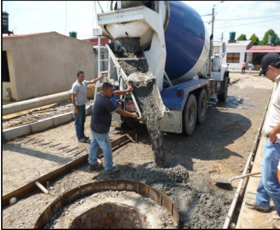
Imagen 84. Fundida placas de concreto Imagen 85. Fundida placas de concreto
