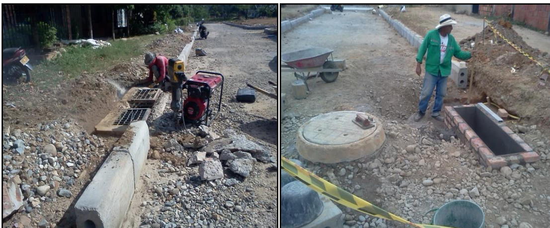
Imagen 81. Demolición sumideros
