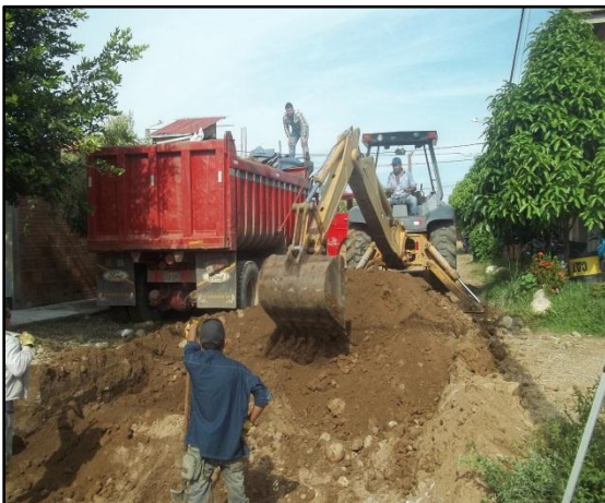
Imagen 69. Cargue de material de excavación Imagen 70. Cargue de material de excavación
