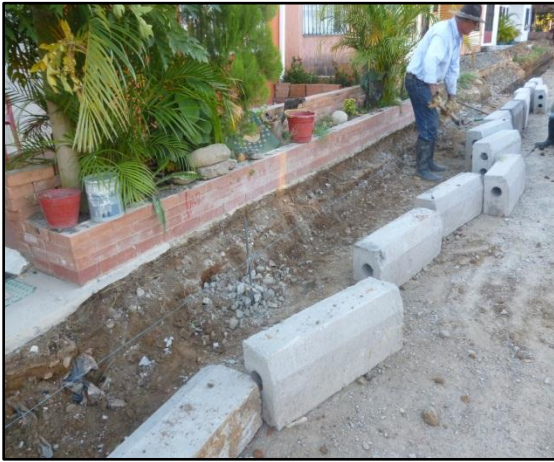
Imagen 67. Excavación para sardineles Imagen 68. Excavación para sardineles
