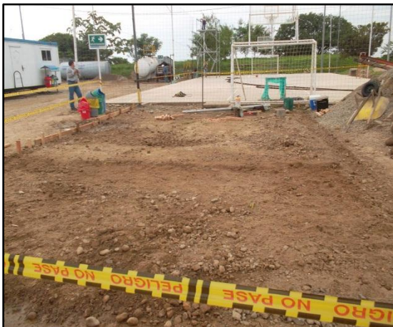
Imagen 8. Relleno manual RH1
