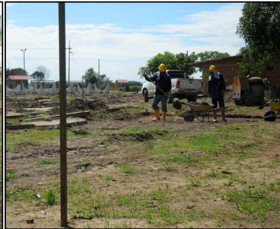
Imagen 52. Excavación manual Gasmocam
