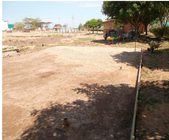
Imagen 55. Formaleta en madera Gasmocam
