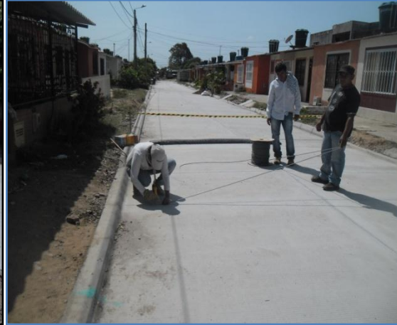
Imagen 89. Sellado de dilataciones placas de concreto
