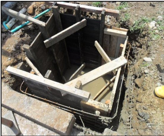
Imagen 44. Formaleta, acero de refuerzo caja de recolección de aguas RH5
