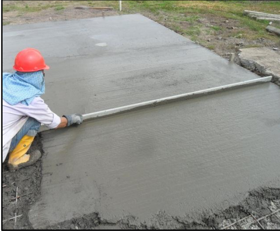
Imagen 58. Fundida concreto placa Gasmocam
