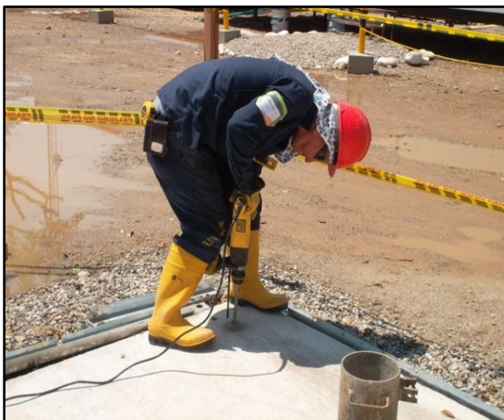
Imagen 20. Montaje rieles caseta
