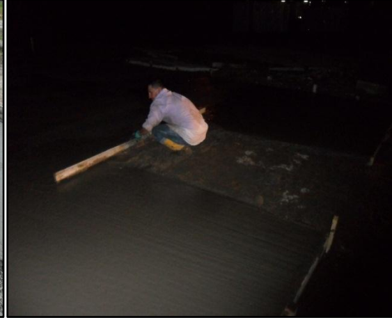
Imagen 59. Fundida concreto placa Gasmocam
