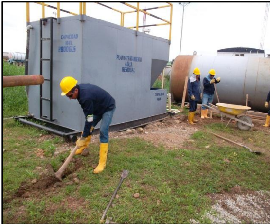
Imagen 34. Excavación manual RH5
