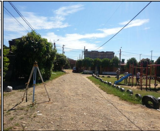
Imagen 64. Localización y replanteo
