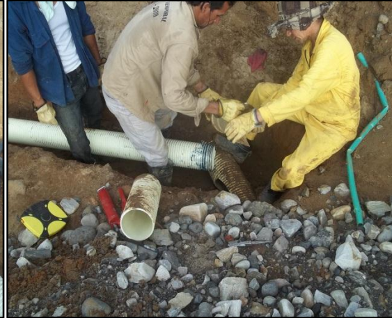
Imagen 75. Arreglo acometida de alcantarillado Imagen 76. Arreglo acometida de alcantarillado
