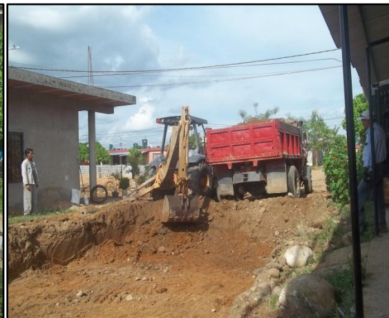
Imagen 69. Cargue de material de excavación Imagen 70. Cargue de material de excavación
