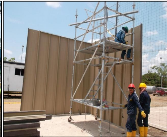
Imagen 23. Postura láminas de confinamiento
