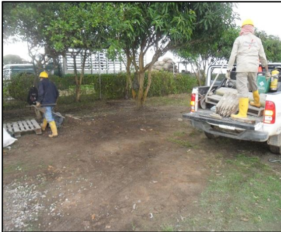
Imagen 48. Movilización de materiales Gasmocam
