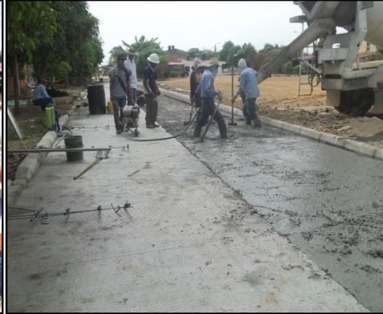
Imagen 84. Fundida placas de concreto Imagen 85. Fundida placas de concreto
