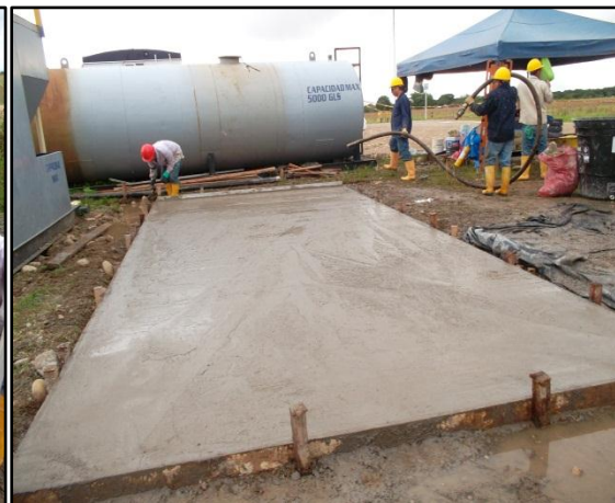
Imagen 41. Elaboración y vaciado concreto RH5
