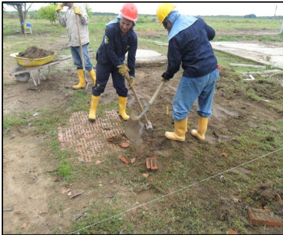
Imagen 51. Excavación manual Gasmocam
