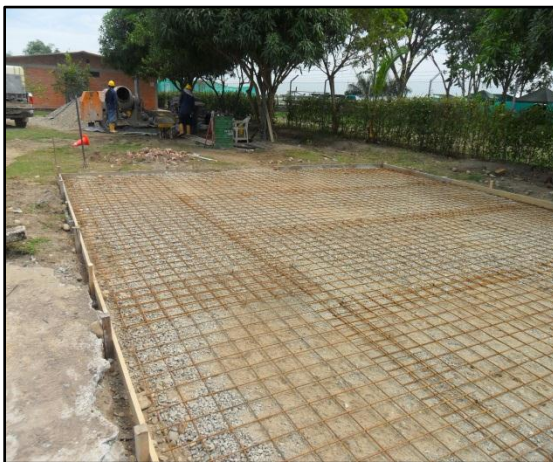
Imagen 56. Acero de refuerzo Gasmocam
