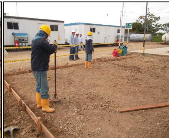
Imagen 9. Relleno manual RH1
