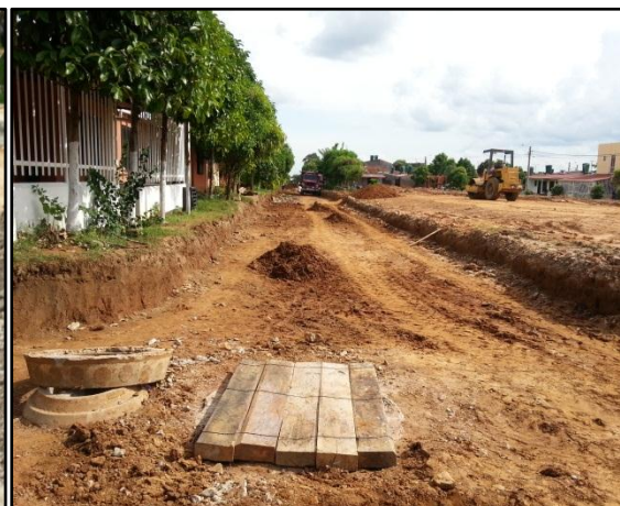
Imagen 77. Nivelación pozos alcantarillado Imagen78. Nivelación pozos alcantarillado
