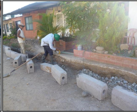
Imagen 67. Excavación para sardineles Imagen 68. Excavación para sardineles
