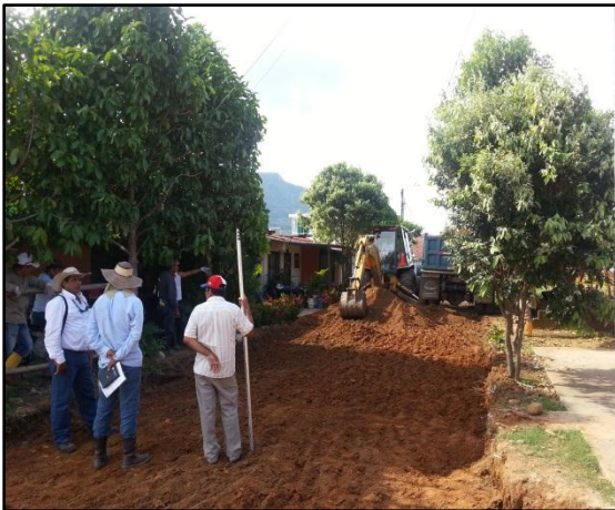
Imagen 65. Excavación mecánica
