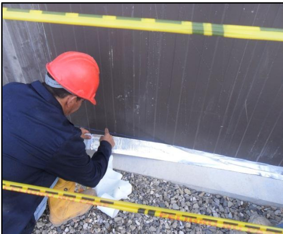
Imagen 28. Impermeabilización base caseta
