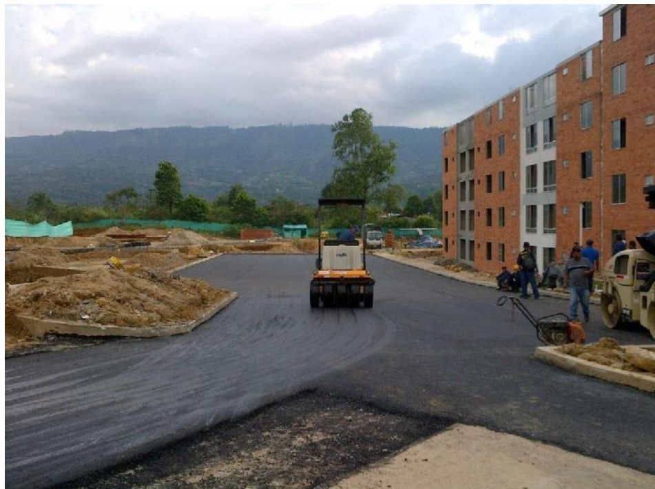
Figura 81 Área Pavimentada. Compactador de llanta.
