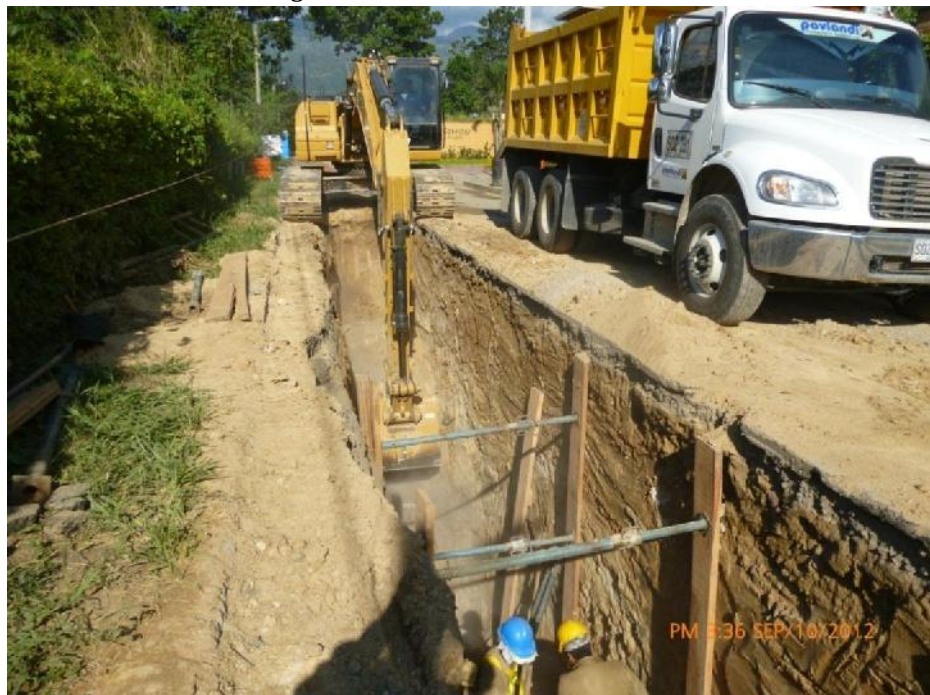
Figura 47 Entibación Pr 129-Pr128
