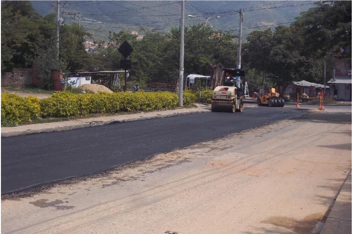
Figura 20 Compactación capa de rodadura
