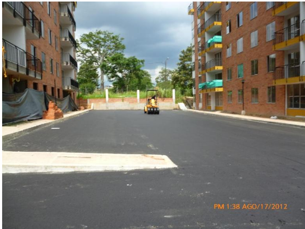
Figura 38 Compactación Carpeta Asfáltica
