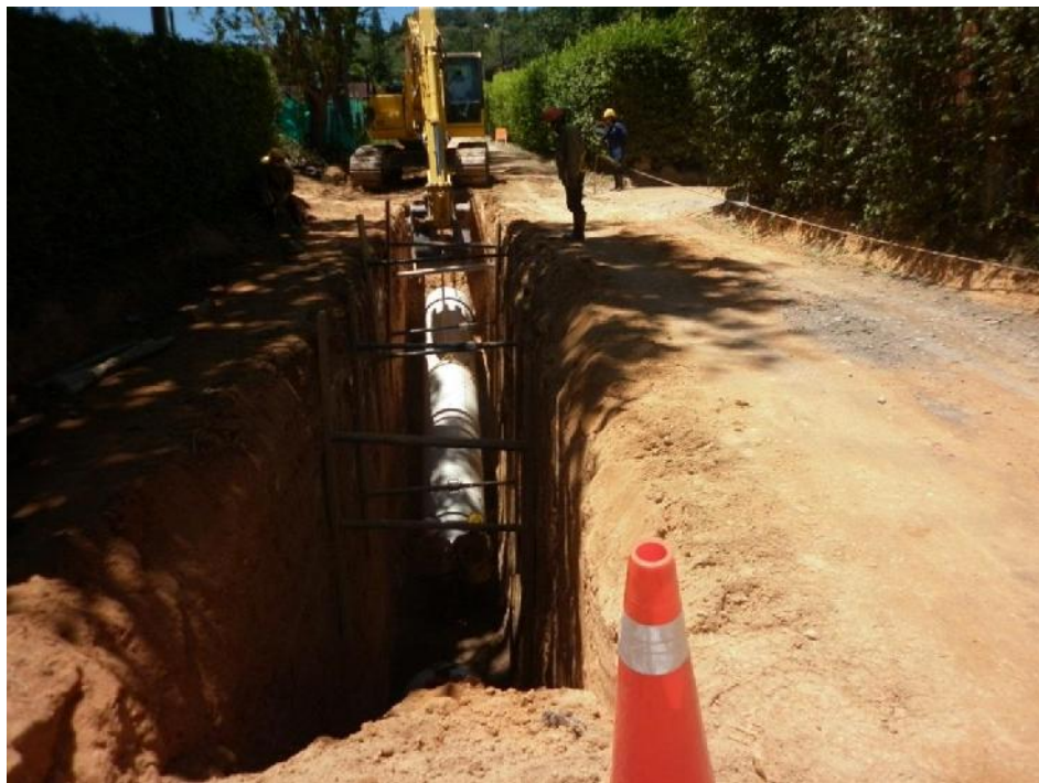
Figura 51 Instalación Tubería Pr 122-Pr 120
