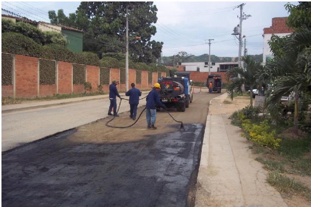
Figura 17 Aplicación Emulsión Asfáltica
