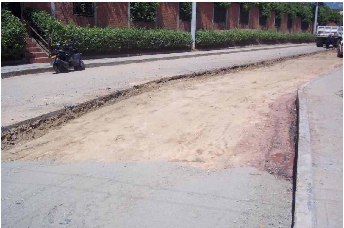
Figura 10 Caja estructura del pavimento
