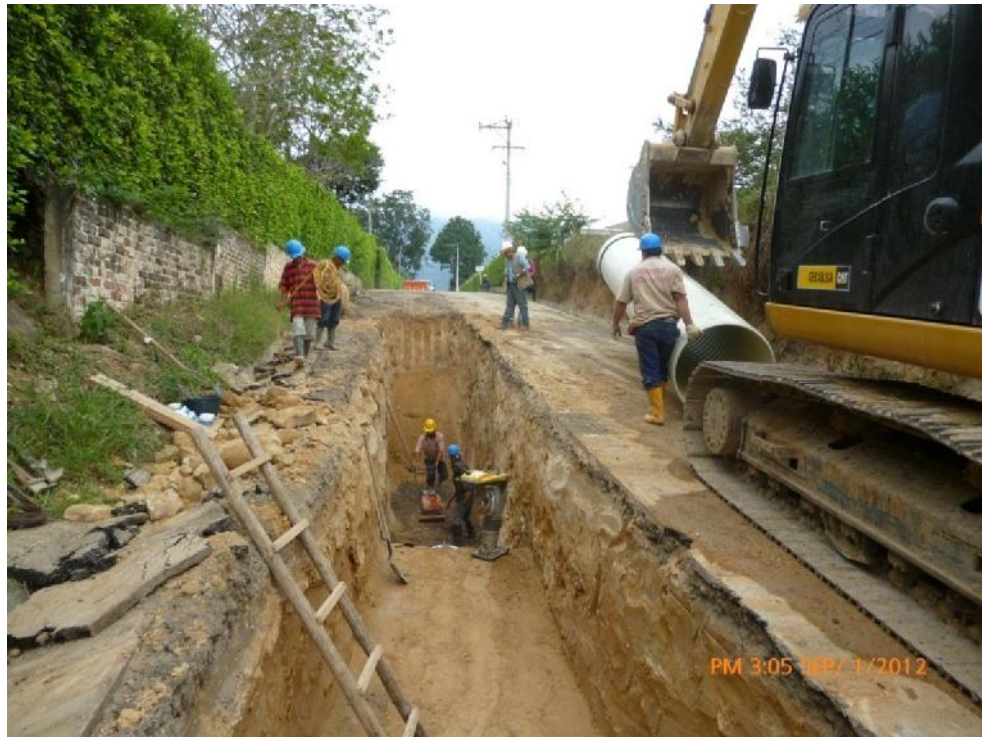
Figura 49 Instalación Tubería Pr 130-Pr129
