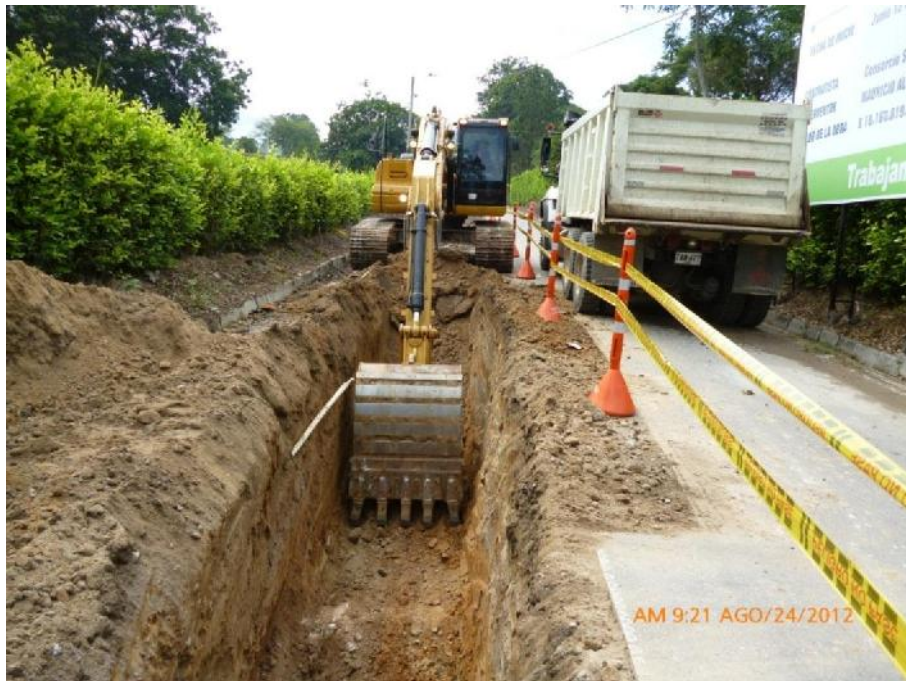
Figura 46 Excavación Pr 136 –Pr 1135
