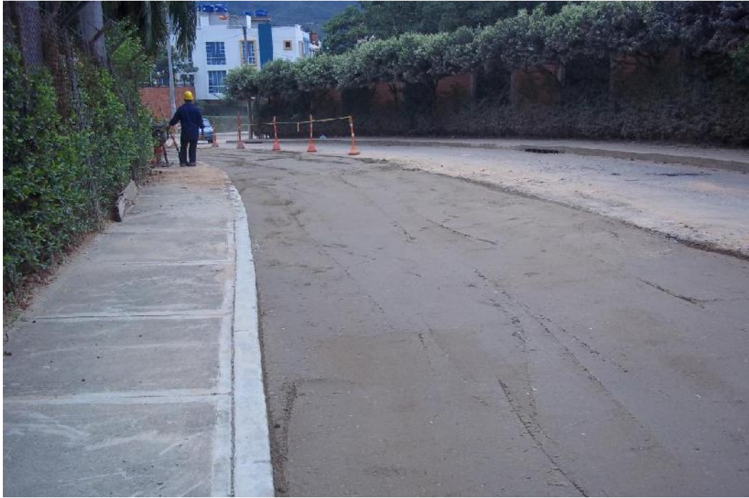
Figura 23 Base Granular
