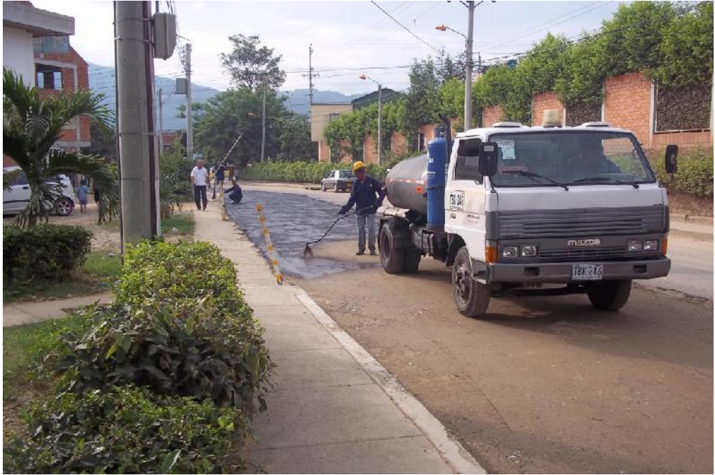
Figura 14 Aplicación Emulsión Asfáltica
