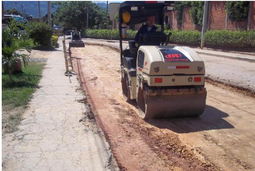
Figura 11 Compactación de la Subrasante
