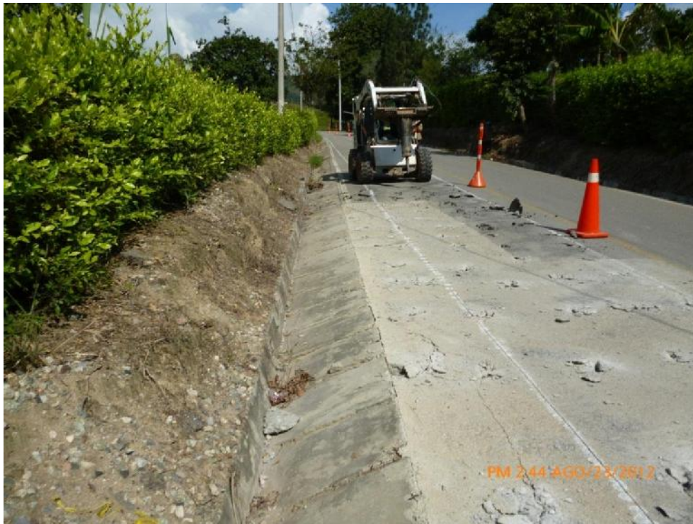
Figura 44 Corte de pavimento existente
