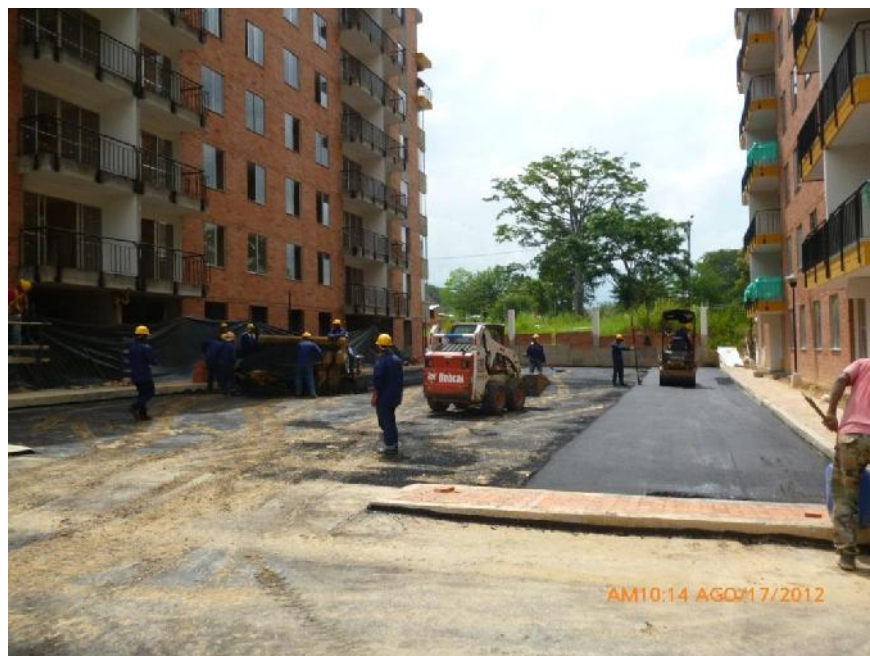
Figura 36 Imprimación del área a intervenir
