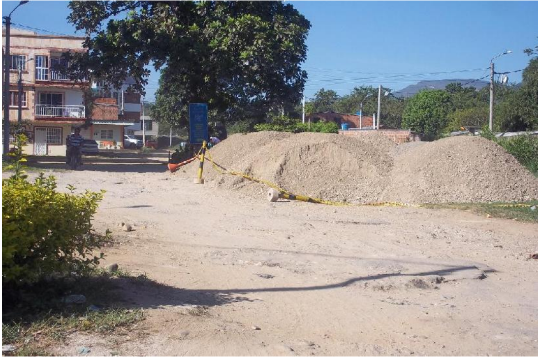
Figura 8 Acopio de Base Granular en el sector.
