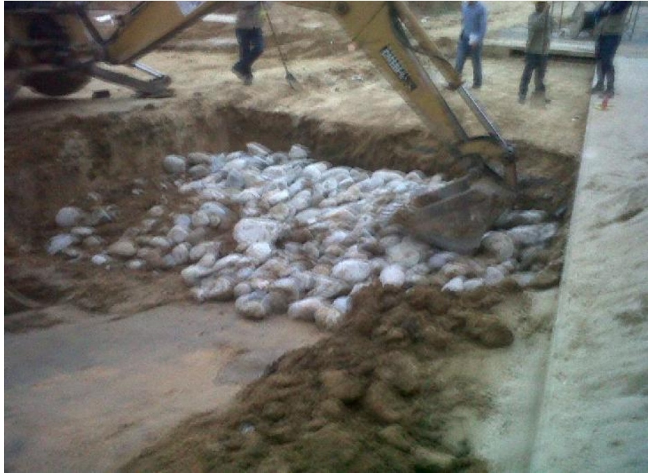
Figura 71 Fallo encontrado. Abscisa K0+005-K0+0010. Profundidad: 50cm.
