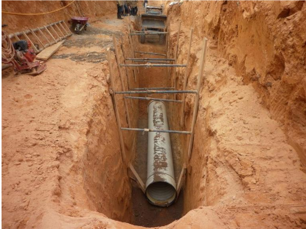
Figura 52 Instalación Tubería con Entibado Pr 120- Pr 119
