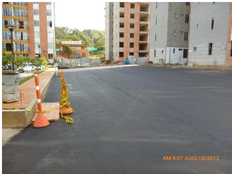
Figura 39 Carpeta Asfáltica Finalizada
