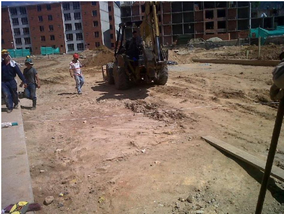
Figura 68 Localización y Replanteo área a pavimentar.
