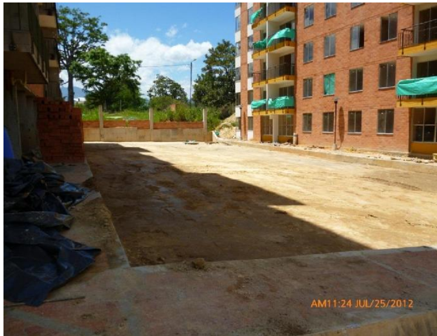
Figura 33 Subrasante compactada
