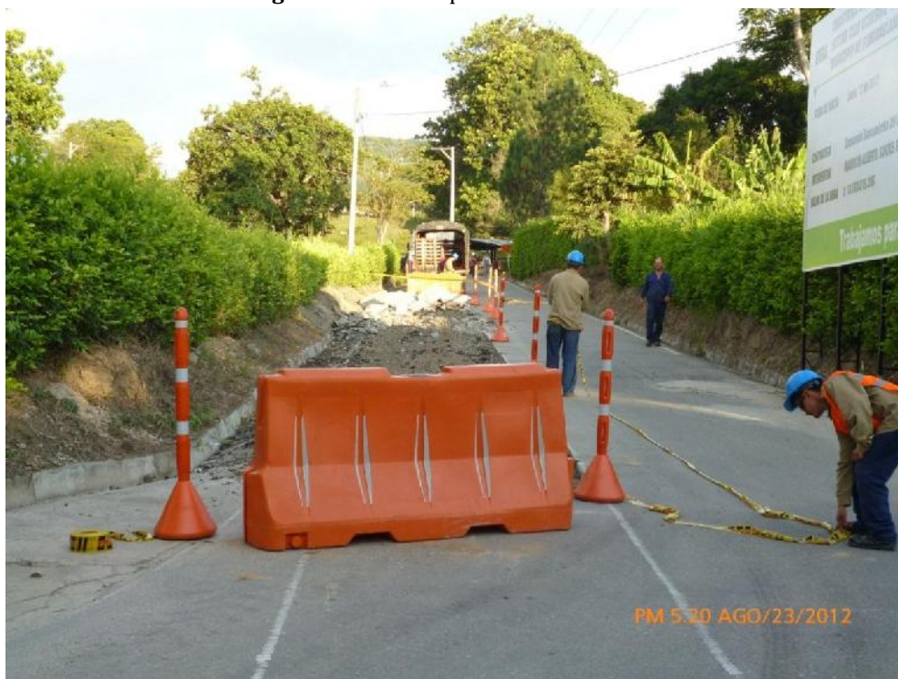
Figura 45 Demolición de Pavimento
