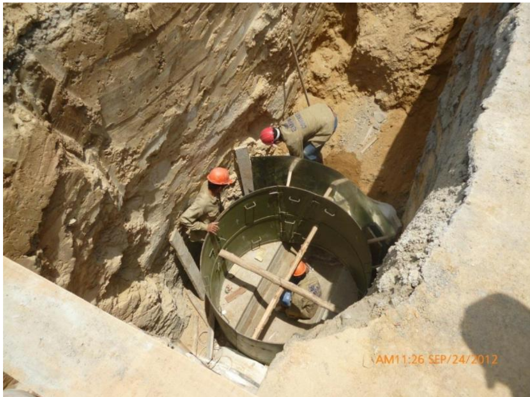
Figura 63 Formaleta Estructura Pozo
