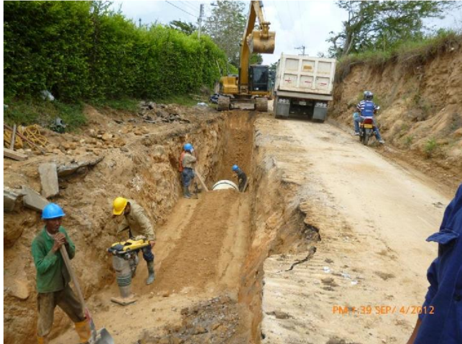
Figura 55 Compactación con Saltarín 40 cm por encima del tubo Pr 130-Pr 129
