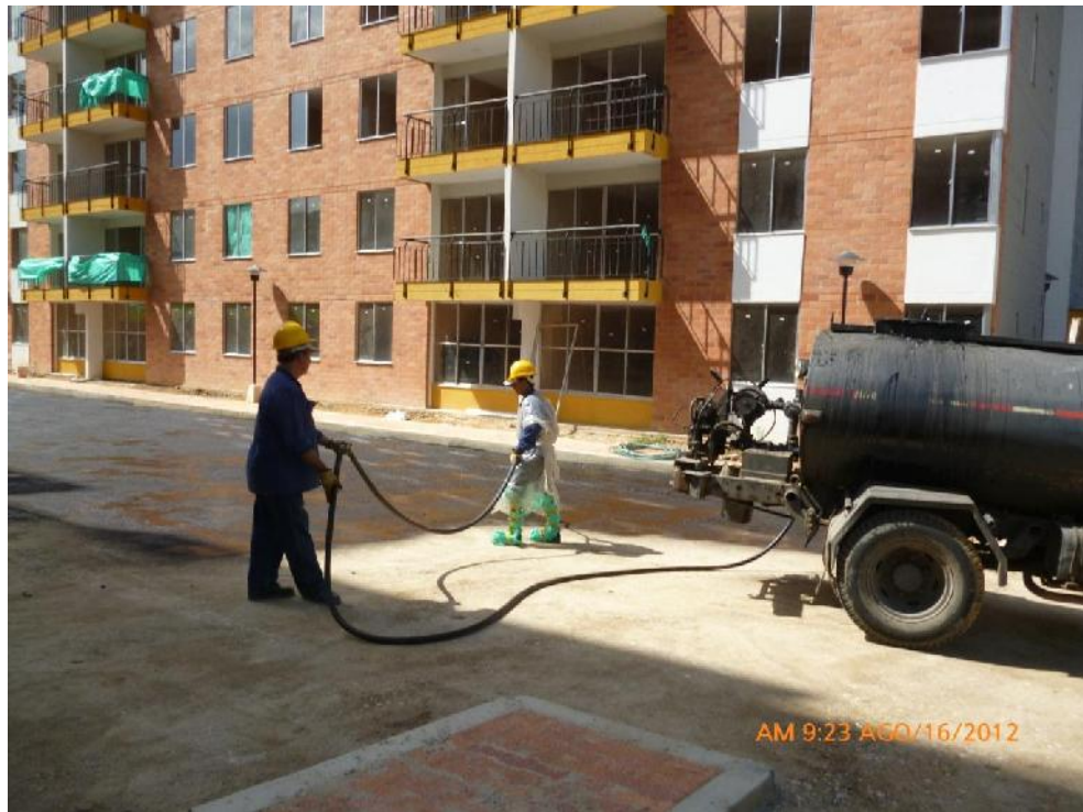
Figura 36 Imprimación del área a intervenir
