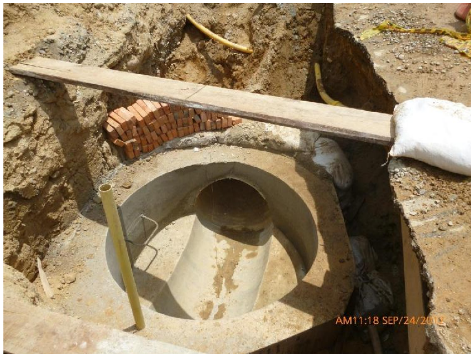
Figura 61 Cañuela Fundida Pr 130
