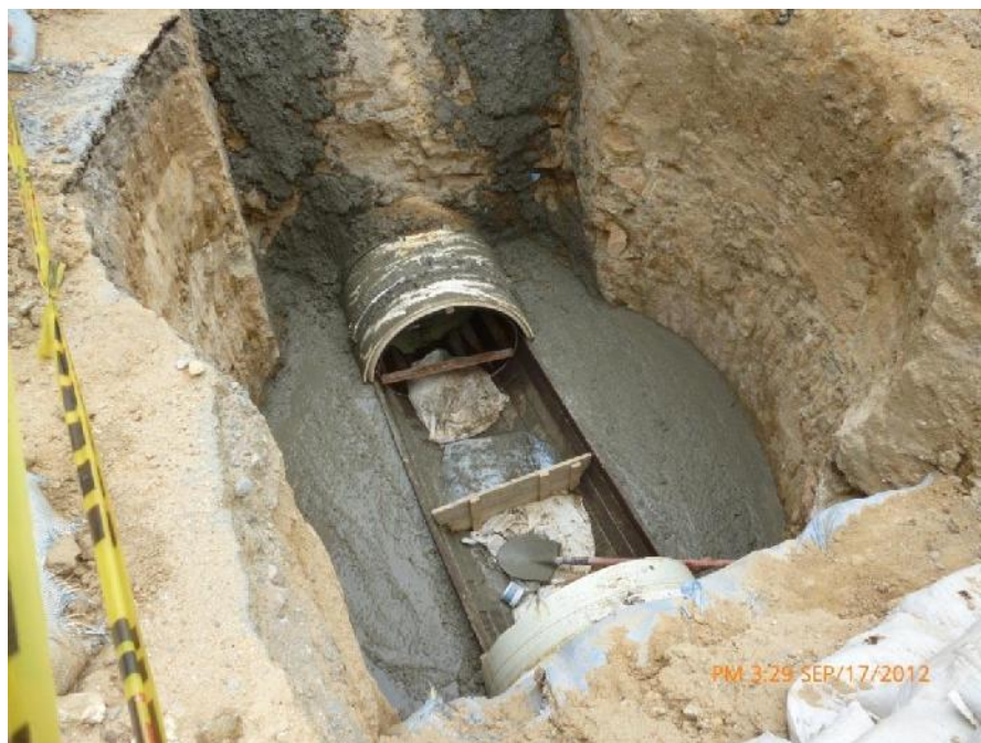
Figura 60 Fundida Cañuela Pr 131
