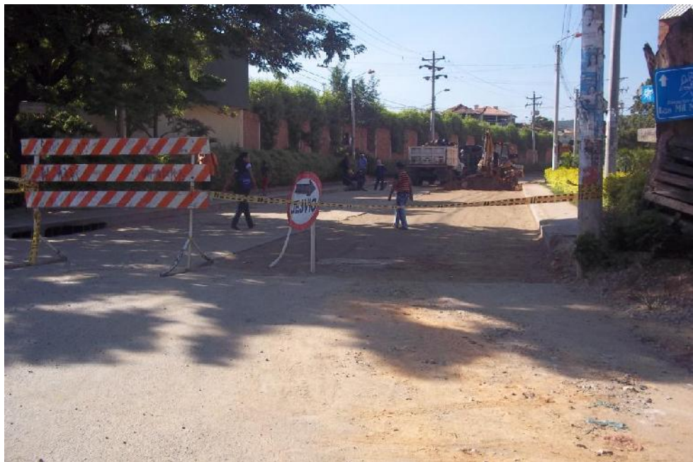
Figura 7 Demolición pavimento existente con Retroexcavadora.
