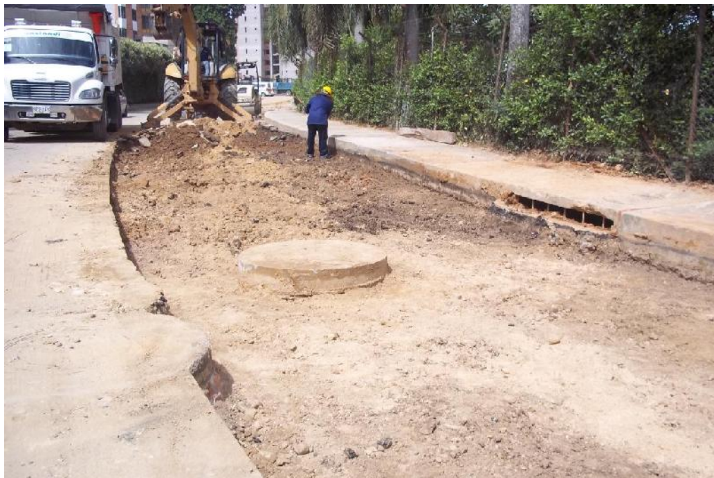
Figura 22 Demolición Pavimento existente
