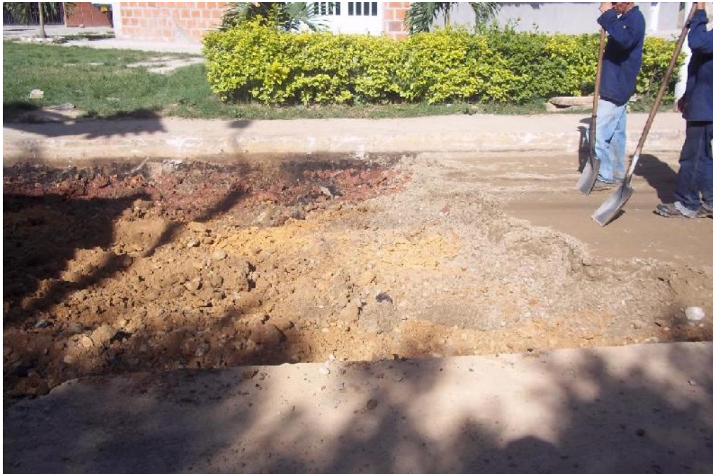
Figura 6 Demolición pavimento existente y caja estructura de pavimento
