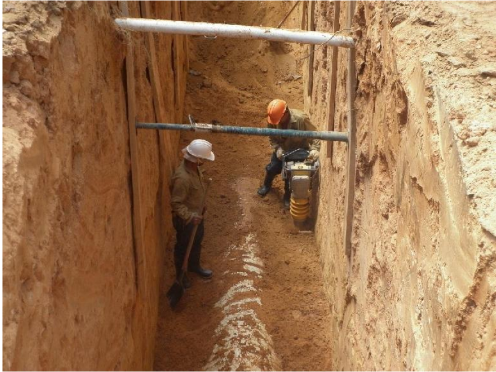
Figura 57 Relleno Pr 122-Pr120
