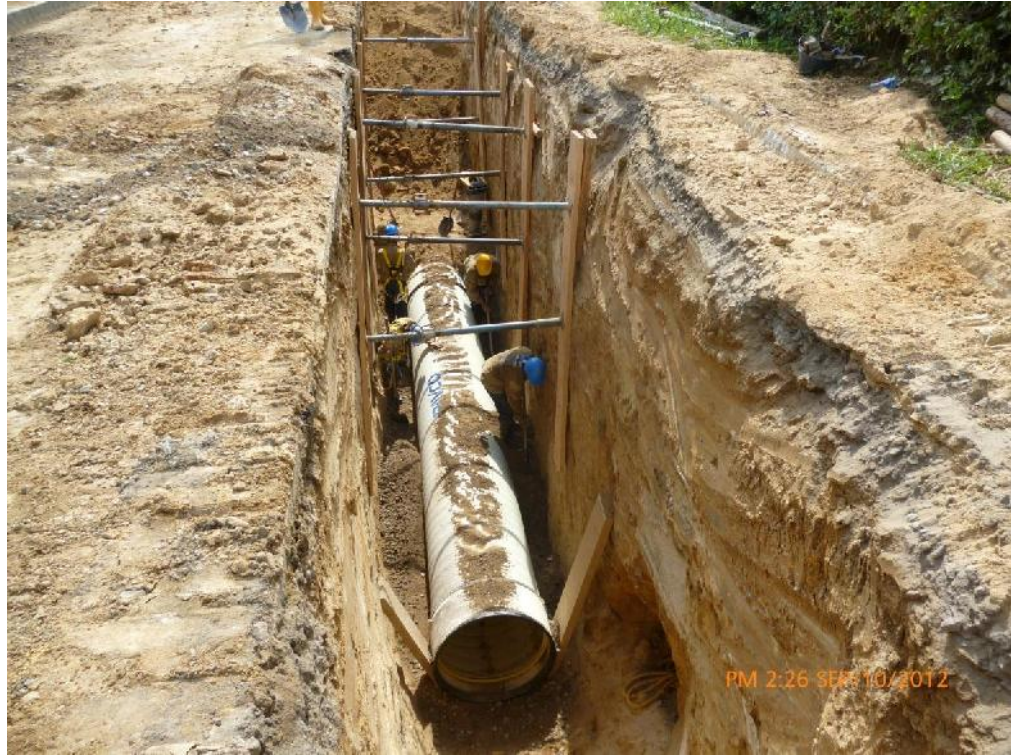
Figura 50 Instalación Tubería Pr 129-Pr 128
