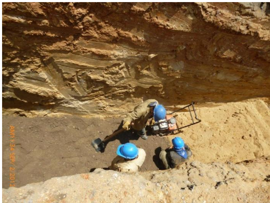
Figura 54 Replanteo 20 cm de Base Granular Pr 128-Pr127
