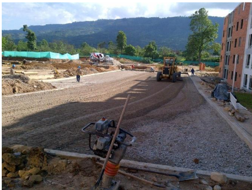
Figura 74 Aplicación Base Granular Con Motoniveladora
