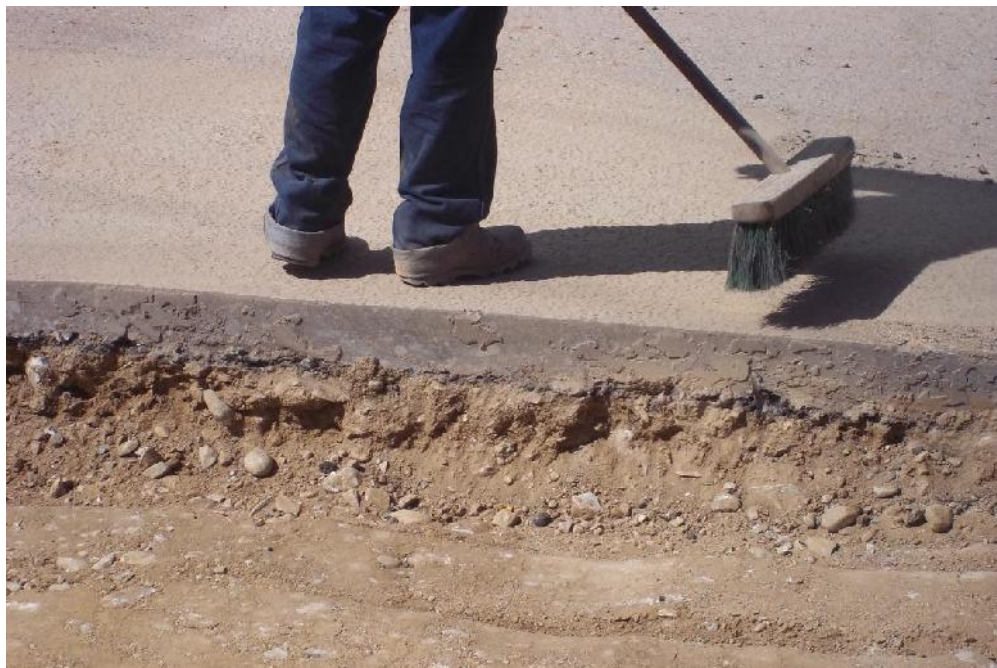
Figura 12 Estratificación de la estructura de Pavimento existente
