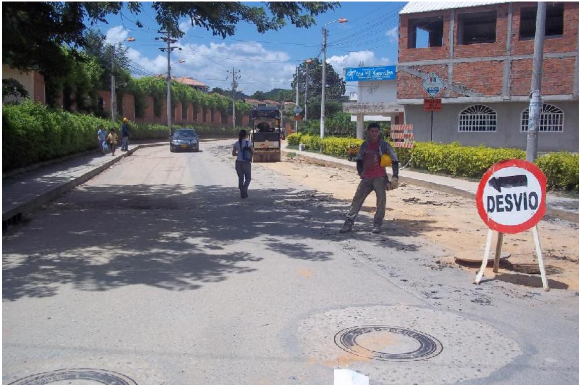
Figura 3 Demarcación área a intervenir Arboleda Campestre
