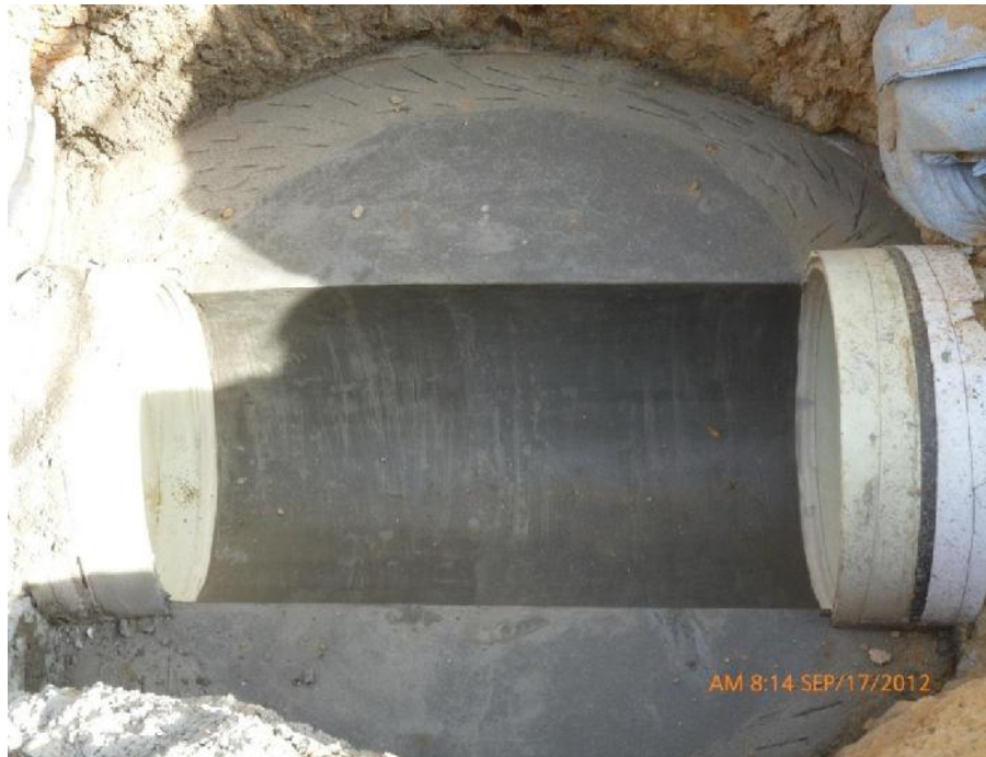
Figura 61 Cañuela Fundida Pr 130
