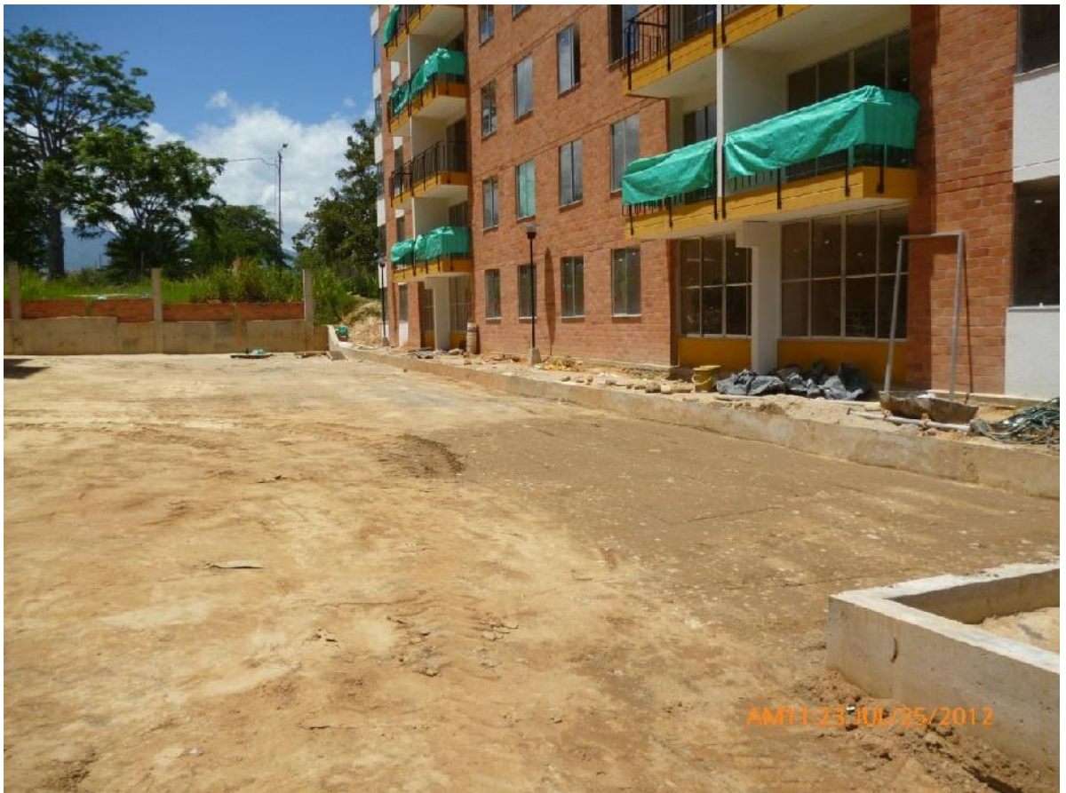
Figura 30 Caja existente Arboleda Campestre parte Interna
