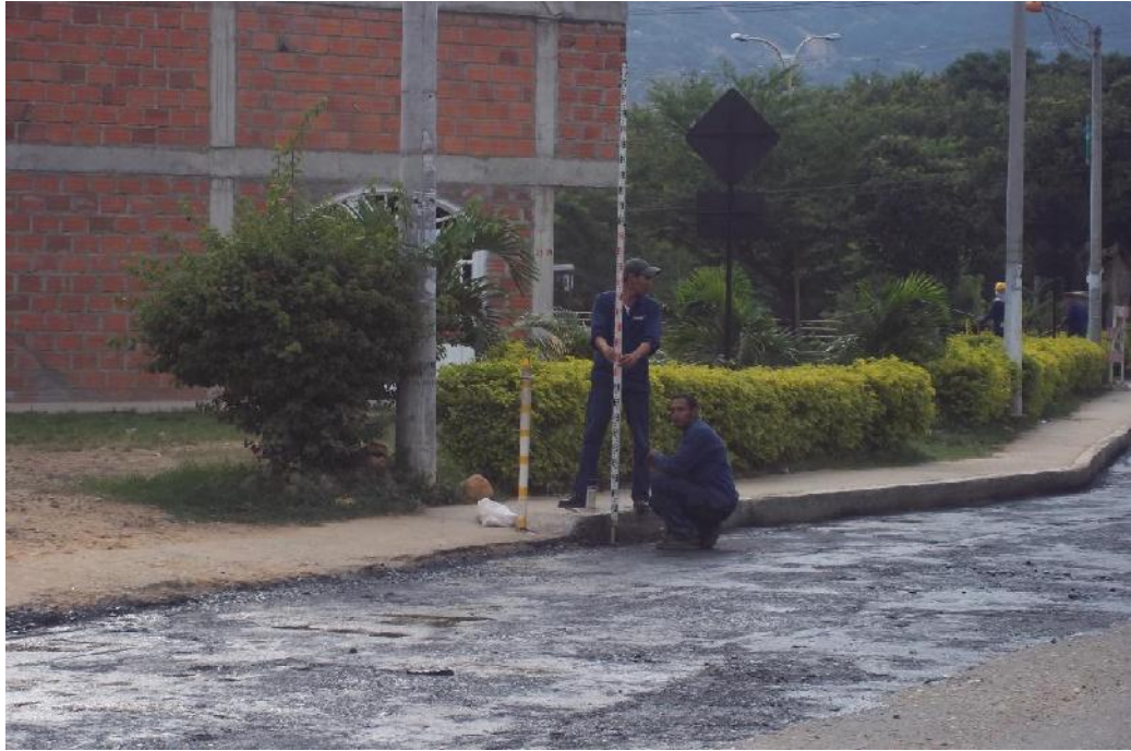
Figura 16 Fijación de niveles para la aplicación de la mezcla asfáltica
