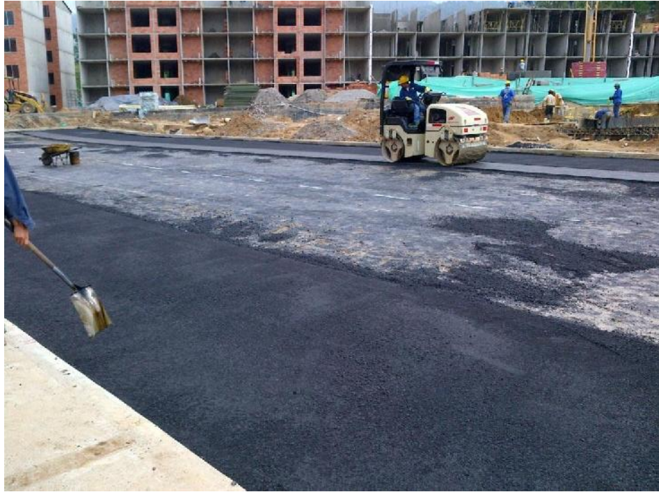
Figura 78 Compactación Capa Asfáltica
