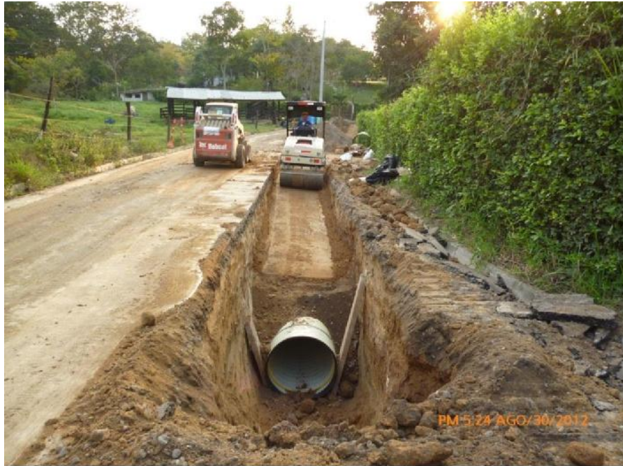
Figura 53 Compactación Relleno Pr 132-Pr 131
