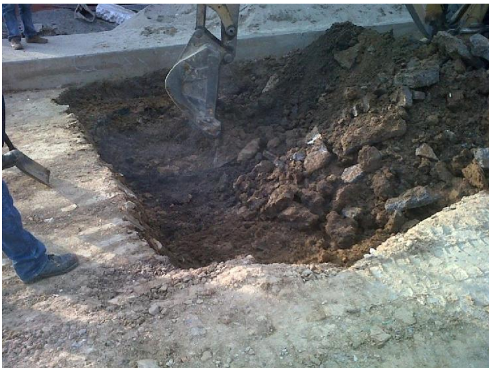
Figura 69 Excavación de la Subrasante
