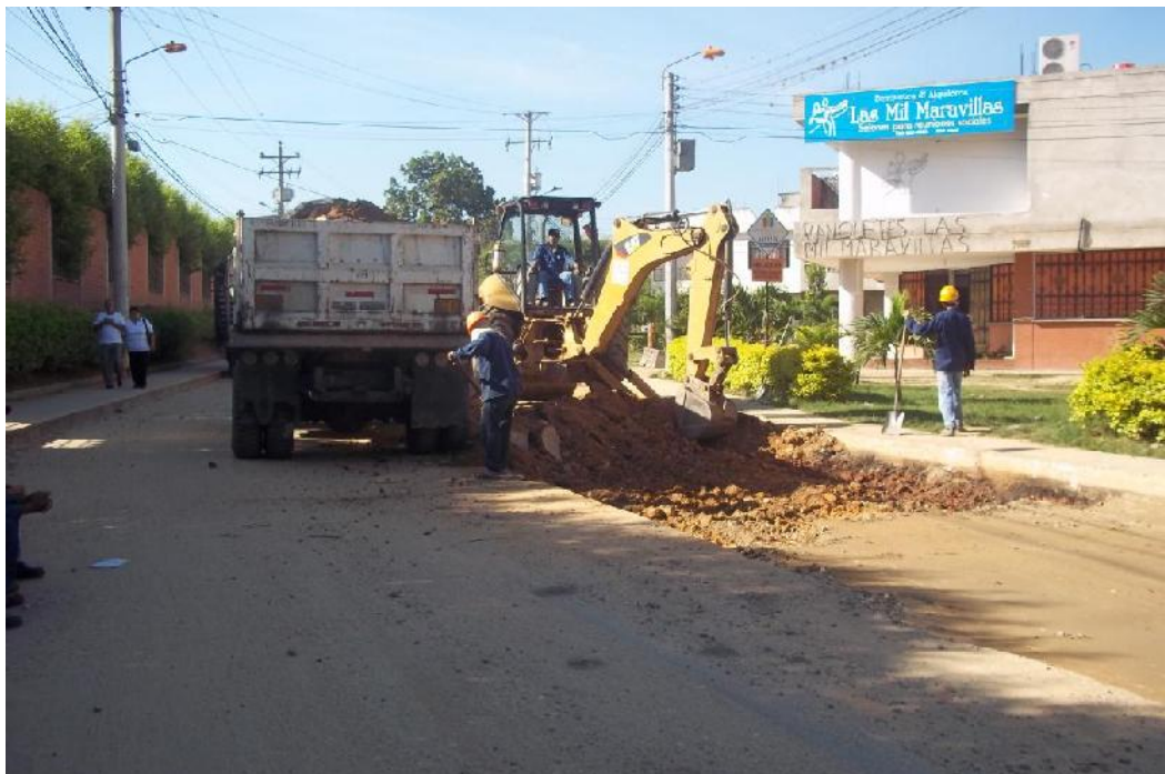
Figura 9 Excavación 27 cm de profundidad.
