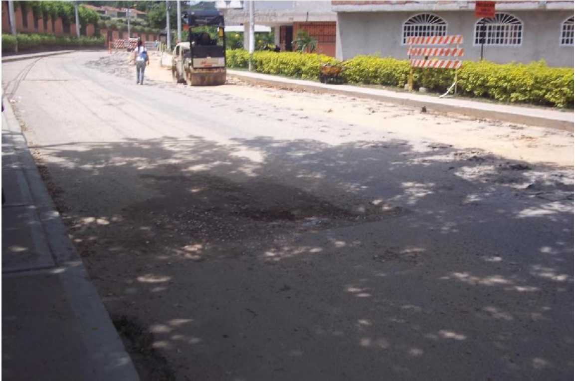
Figura 4 Corte del pavimento existente con el Bocat de martillo
