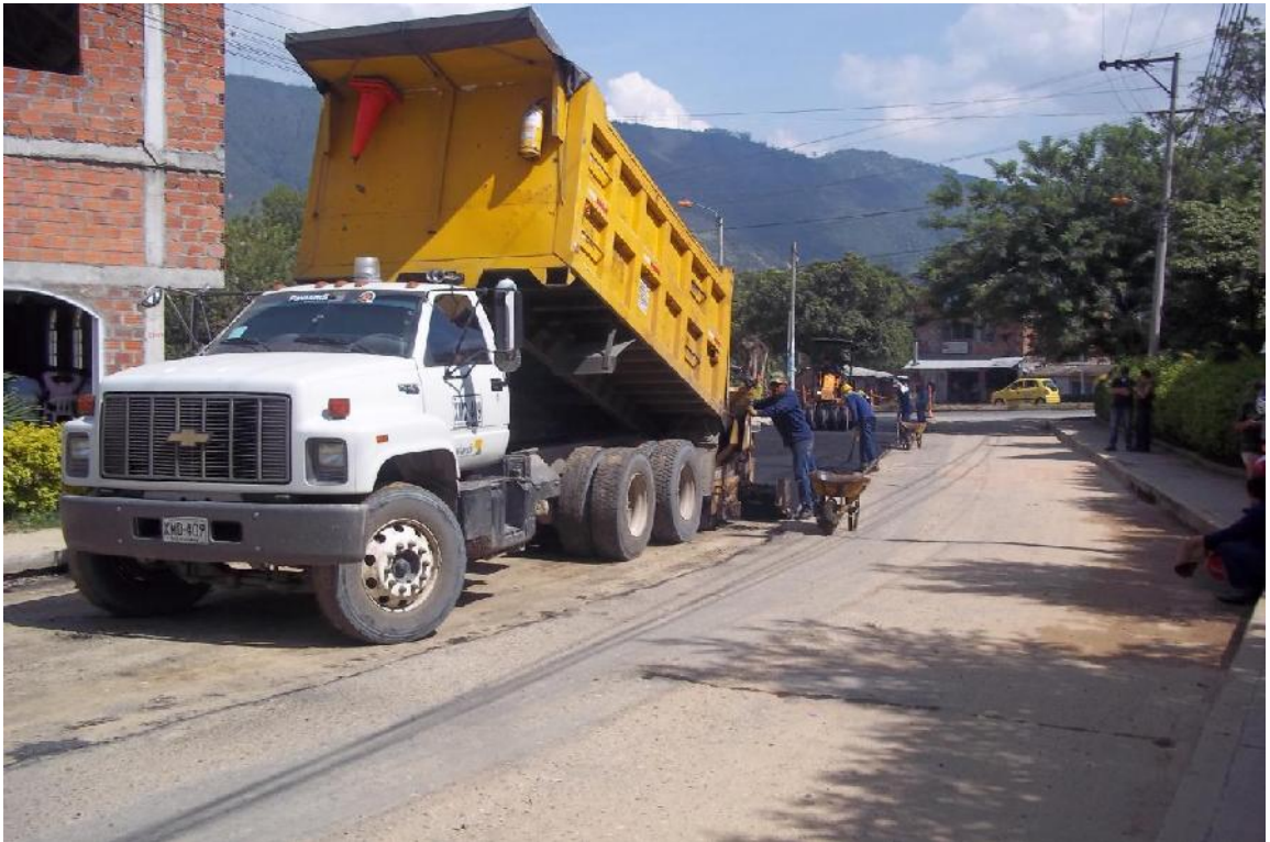
Figura 18 Aplicación mezcla asfáltica
