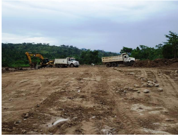
Fotografía 38-Extracción de material de la zona Industrial 2 para planta trituradora
