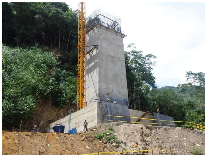
Fotografía 25-Pila eje 2 Puente Pujamanes
