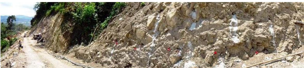
Fotografía 22-Talud pernado K10+120
