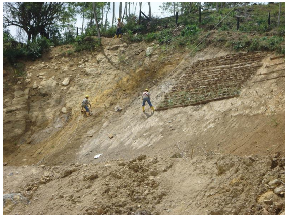
Fotografía 43-Construcción de trinchos en madera para estabilización de taludes, sector K20+400 al K20+410 MI.
