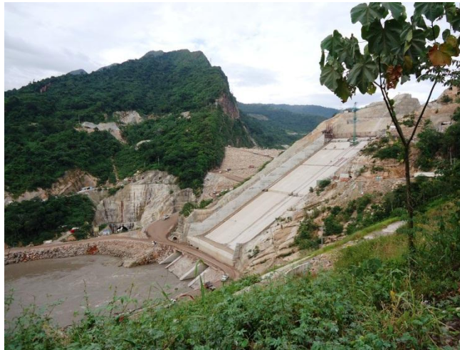
Fotografía 1-Vista Agua Debajo de la presa – Vertedero y Túneles de Desvió
