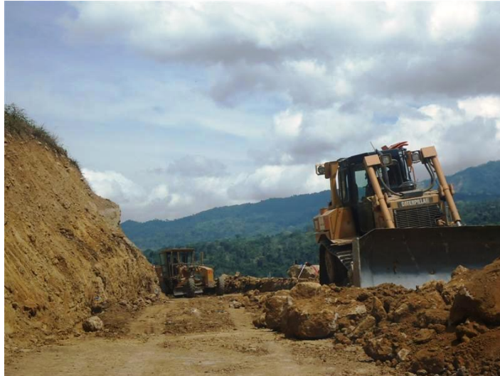
Fotografía 17-Excavacion para llegar a cota de Sub-rasante K6+980-K7+100
