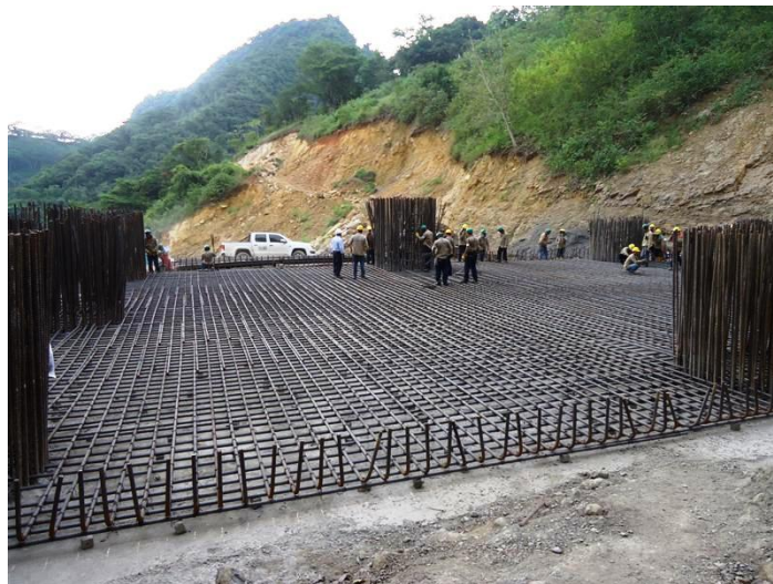
Fotografía 31-Construcción de la parrilla inferior de la zapata del Puente el Tablazo eje 4
