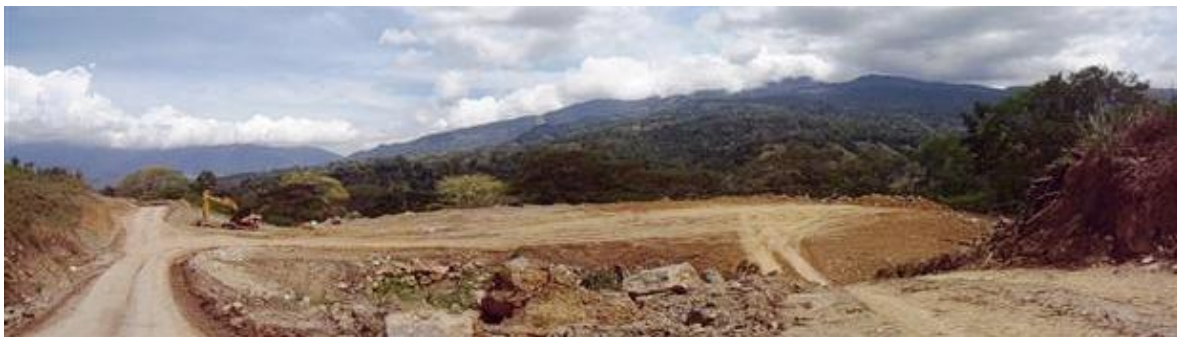
Fotografía 18-Conformacion de material en el depósito 2A
