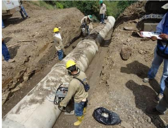
Fotografía 48-Instalación tubería \varnothing=90\text{m} , colocación y compactación de material de relleno tipo A para zanjas (sub-base granular), en la construcción de la alcantarilla del sector K17+545
