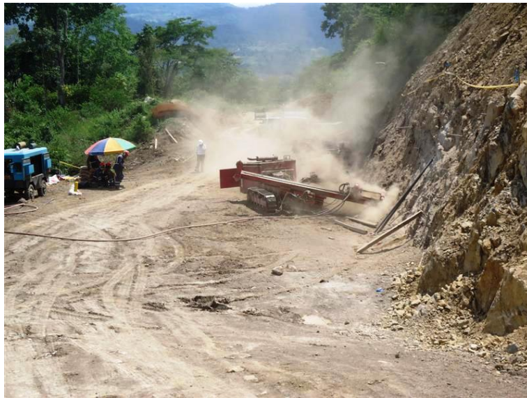
Fotografía 21-Perforaciones para instalación de pernos de anclaje K10+100 – K10+120
