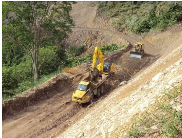
Fotografía 49-Excavación hasta nivel de sub-rasante, cargue y acarreo al depósito No. 1MB, sector K23+060 al K23+110.
