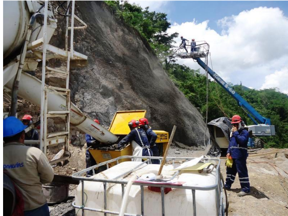
Fotografía 23-Lanzado de concreto para estabilización de talud K10+200 – K10+240
