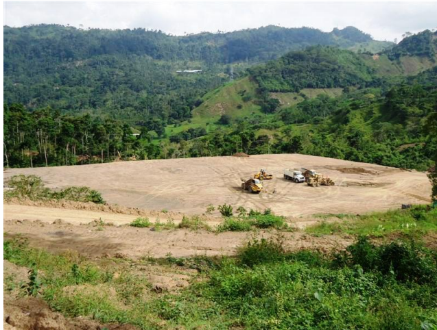
Fotografía 12-Compactacion de material proveniente de explanaciones–Deposito 1
