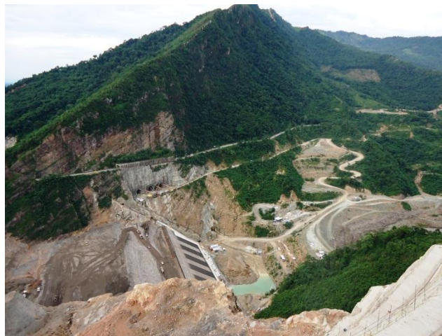
Fotografía 2-Vista Agua Arriba de la presa – Cara de Concreto de la Presa
