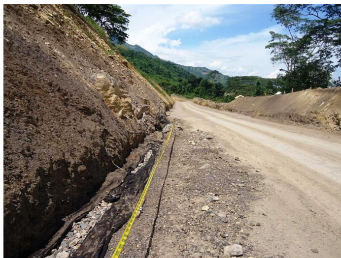
Fotografía 19-Construccion de Filtros
