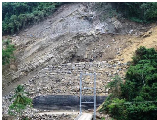
Fotografía 41-Vista muro y enrocado del eje 2, para plataforma del puente el Tablazo
