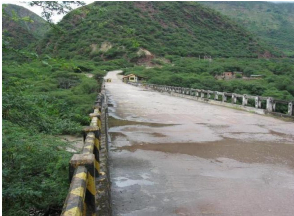
Fotografía 4-Actual Puente Gómez Ortiz L=120 m
