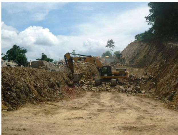
Fotografía 14-Excavacion de material para acceso a estribo 3 del puente NN V – K6+040
