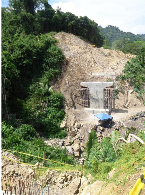
Fotografía 15-Vista de los 3 ejes del puente NN V
