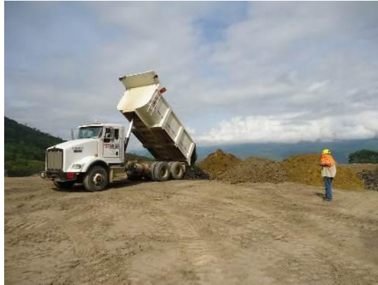
Fotografía 51-Disposición final, conformación, extendido y compactación en el depósito No 5.
