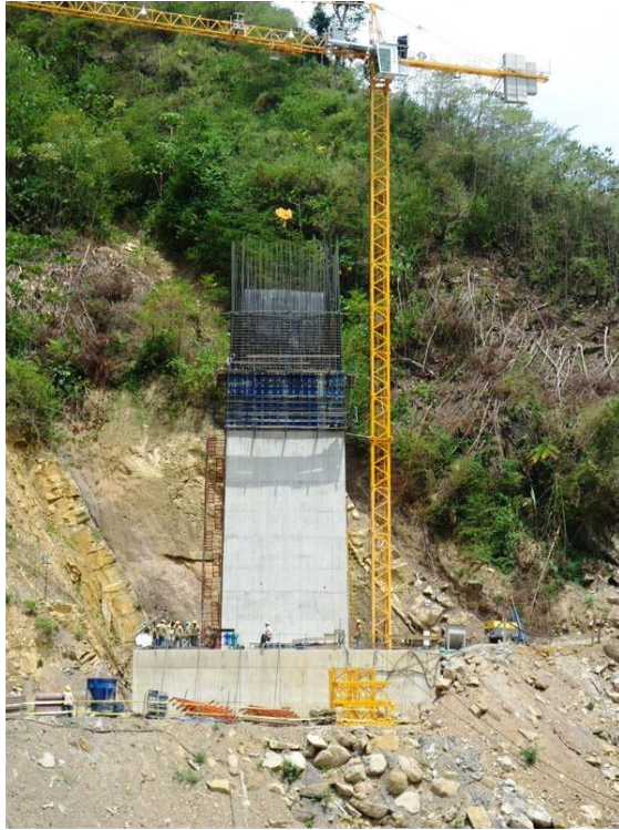
Fotografía 26- Construcción pila eje 3 Puente Pujamanes
