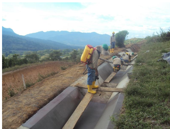
Fotografía 47-Colocación de concreto, vibrado, acabado final y aplicación de aditivo en la construcción de zanjas de coronación, en el sector K23+434 al K23+422 MI.
