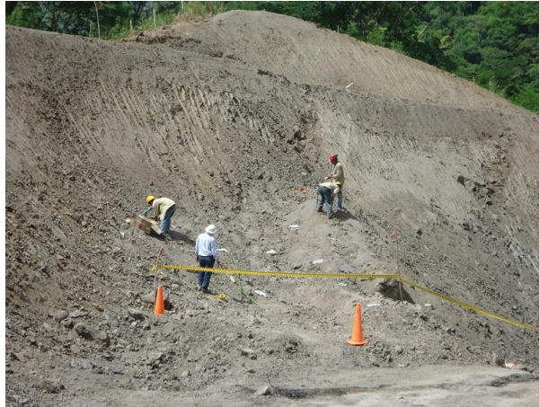
Fotografía 45-Cargue y tacado de barrenos con material explosivo, para posterior procedimiento de voladura, en el sector K17+270 al K17+325 MI.
