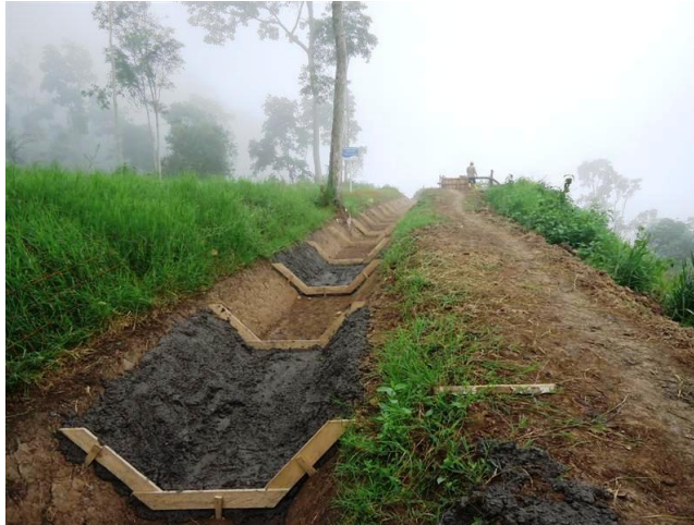
Fotografía 32- Construcción de las zanjas de coronación K1+900
