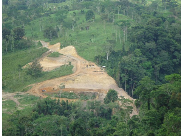
Fotografía 29-Vista Estribo 1 y eje 2 puente Chucuri
