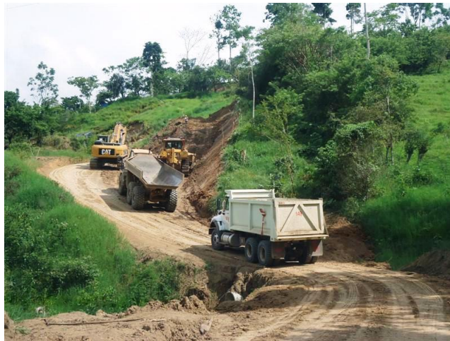
Fotografía 13-Excavacion de material para conformación de vía – K0+500 – K0+ 550
