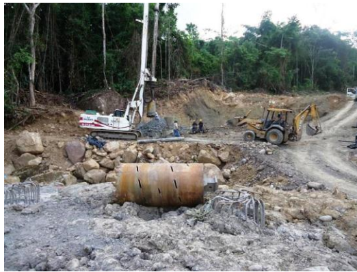
Fotografía 27- Perforación para pilotes Eje 2 Puente NN VI
