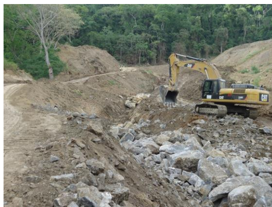
Fotografía 44-Construcción de filtros, para recuperación del costado norte del depósito No 5.
