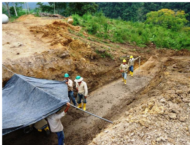
Fotografía 37-Compactación de relleno para la Obra de arte K17+340
