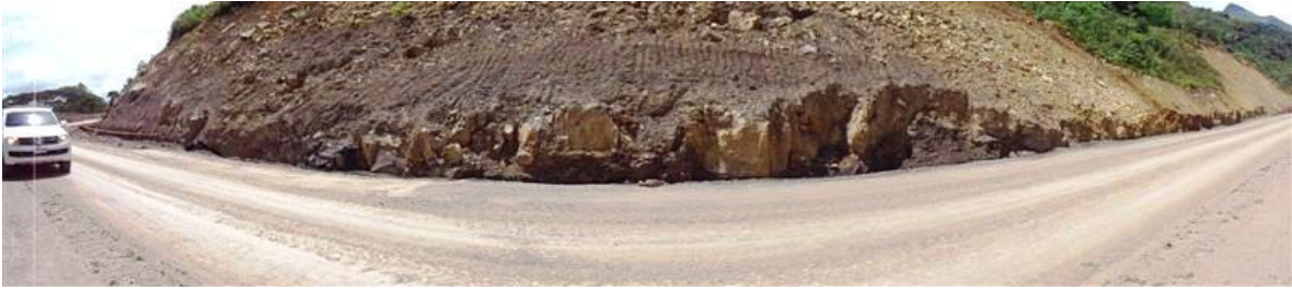
Fotografía 20-Estabilizacion de sub-rasante con cal
