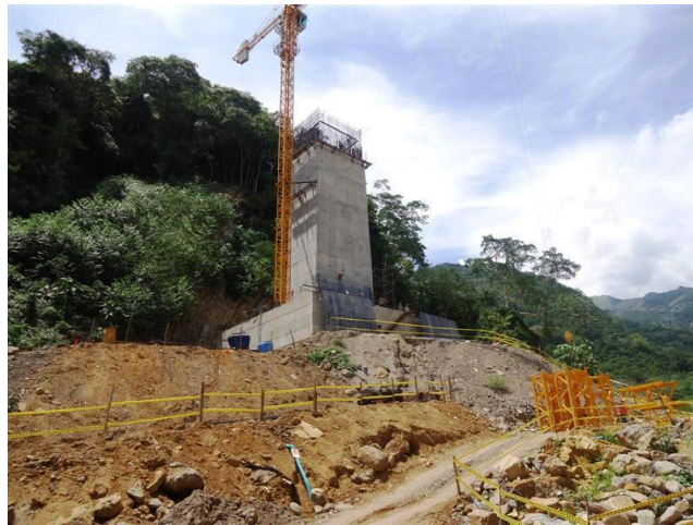
Fotografía 24-Construcción Pila eje 2 Puente Pujamanes
