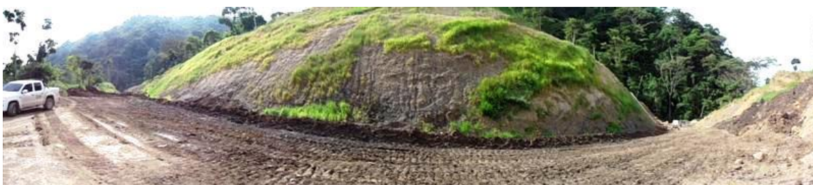
Fotografía 11-Estabilización de talud con hidrosiembra K1+900 – K2+000
