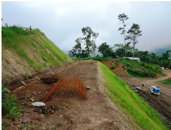
Fotografía 33- Construcción de las cunetas en las bermas del talud K1+900
