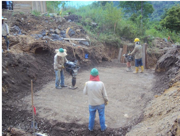
Fotografía 46-Excavación, cimentación, instalación de tubería \varnothing=1,2m , relleno y compactación con sub-base granular, en la construcción de la alcantarilla del sector K22+574.
