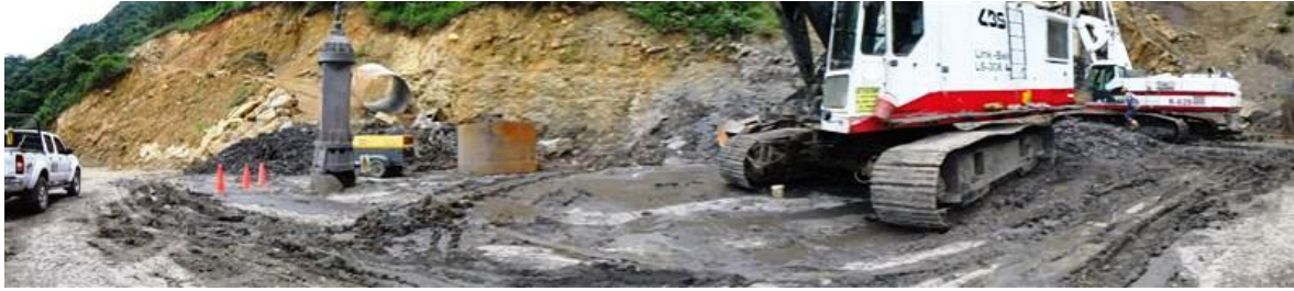
Fotografía 35-Pilotaje en eje 4 Puente El Tablazo
