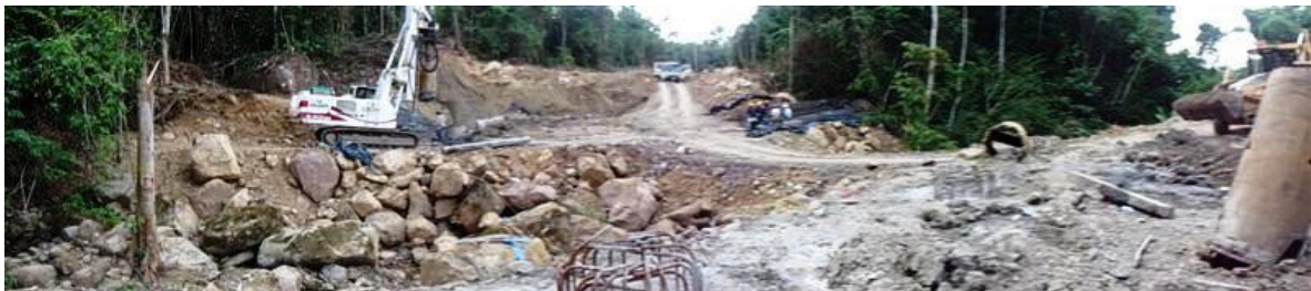
Fotografía 28- Vista eje 2 y 3 Puente NN VI
