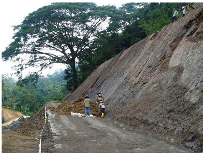
Fotografía 10-Siembra de pasto estrella para estabilización de taludes K1+200 – K1+250
