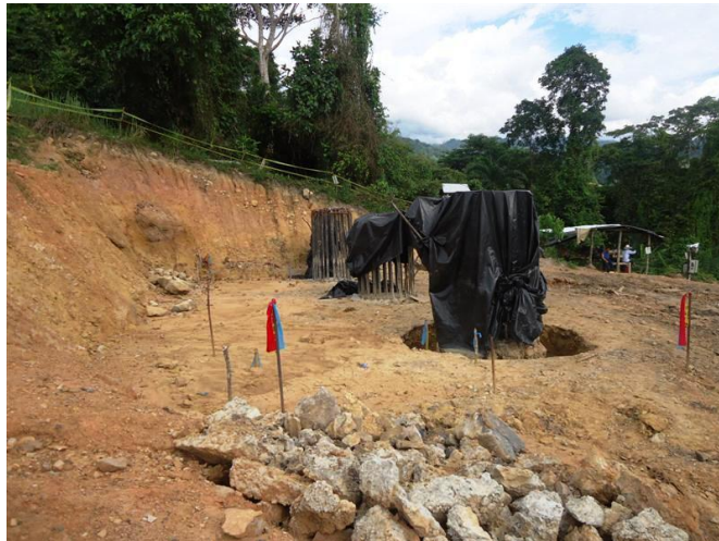
Fotografía 30-Pilotes del estribo 1 Puente Chucuri
