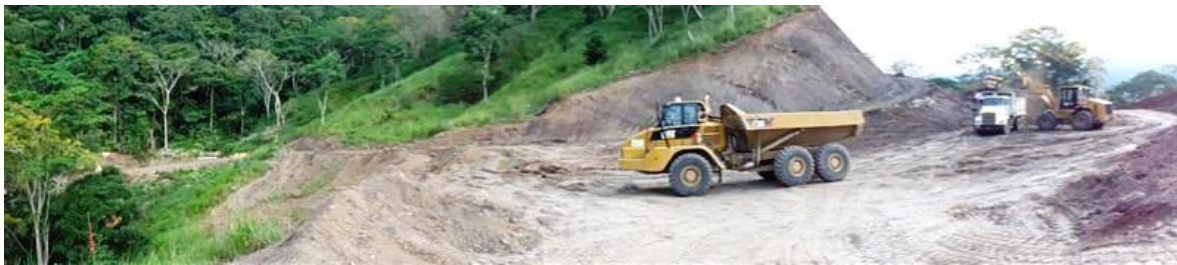
Fotografía 39-Excavacion y cargue de material al depósito 5 - K16+780
