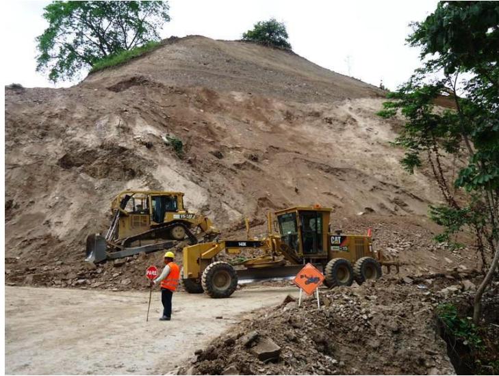
Fotografía 36-Excavación y Perfilado del Talud K24+000
