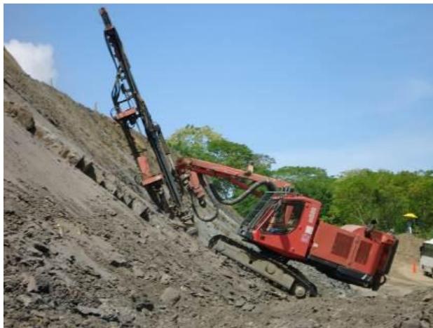
Fotografía 50-Actividades de perforación con equipo Sandvik DX 500, para posterior procedimiento de voladura, en el sector K16+890 al K16+950 MI.
