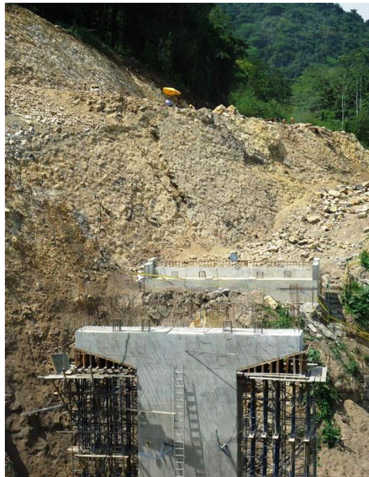
Fotografía 16-Viga cabezal eje 2 puente NN V
