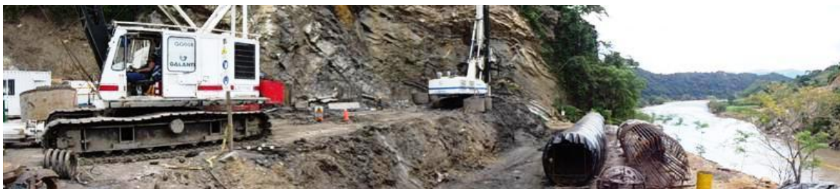
Fotografía 34- Pilotaje en eje 3 del Puente el Tablazo
