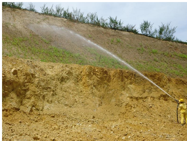
Fotografía 53-Aplicación de agua para riego en taludes estabilizados con hidrosiembra, sector K20+750 al K20+900 MI
