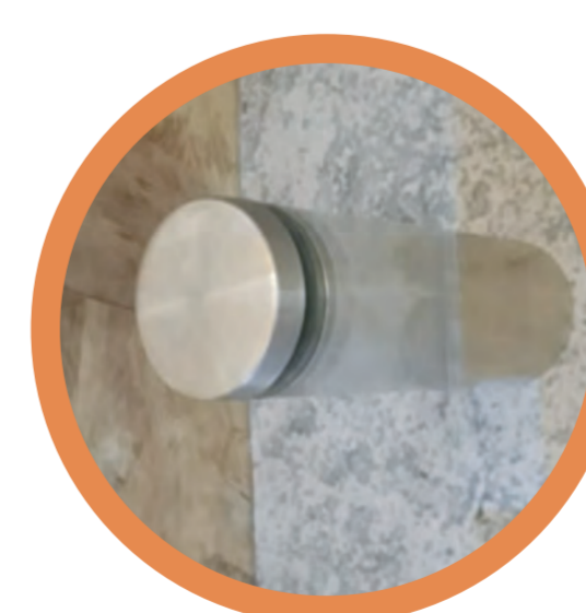
DETALLE D Fijación de vidrio
