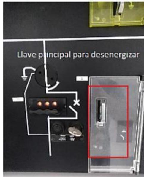
Con la celda aislada el siguiente paso es aterrizar la celda ya que aunque no hay corriente existen corrientes parásitas que en cualquier momento pueden entrar y causar un enorme daño al personal que esté operando en ese momento. Para aterrizar la celda se debe dirigir al circuito que se encuentra en la parte superior derecha y con la misma llave cerrar el circuito. Con la celda ya aterrizada el siguiente paso es dejar con candado el circuito de aterrizaje para evitar accidentes.
