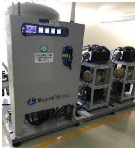
Figura 22: Partes del compresor de aire medicinal.
