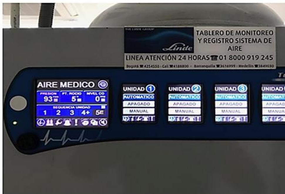
1. La manipulación del sistema de aire medicinal se hace por medio de una pantalla táctil, esta con el fin de encender de acuerdo a como se quiere que el sistema trabaje
