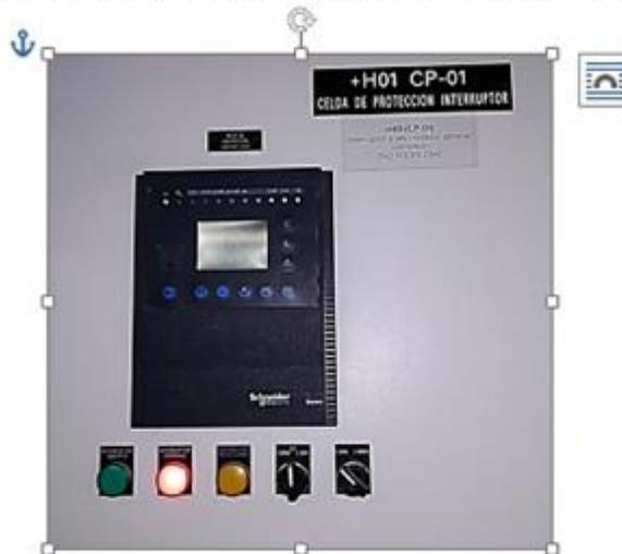
Aquí podemos visualizar la celda de entrada del voltaje que proporciona la ESSA en la cual podemos visualizar la tensión que nos está entregando la electrificadora. Lo mínimo permitido es 33,2 Kv. Si se presenta una caída de tensión que sobrepase el limite antes mencionado se debe pedir el permiso respectivo al jefe de división de ambiente físico el cual en este caso es el arquitecto Gabriel Pradilla para poder determinar si se implementa o no la planta de respaldo.
