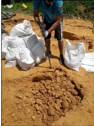
Ilustración 29. Ejecución de la técnica de apique.
