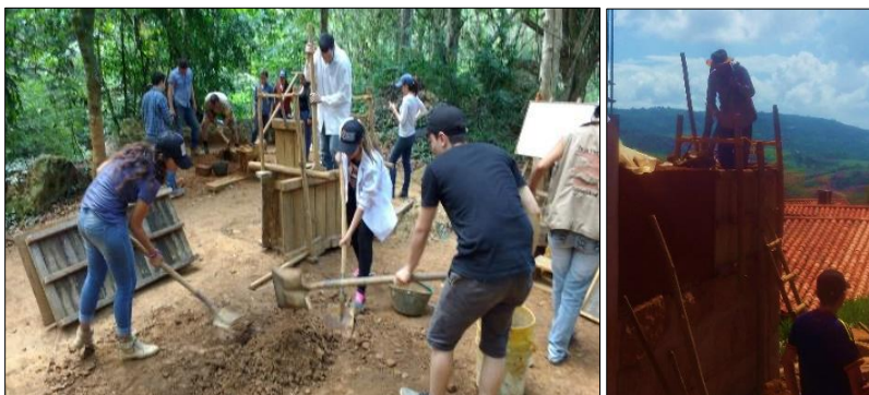
Ilustración 6. Extracción de materia prima y elaboración de muros de tapia pisada.
