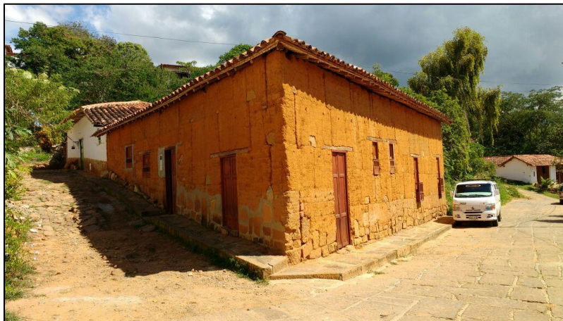
Ilustración 5. Vivienda construida en tapia pisada.
