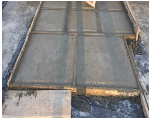
Imagen 36 – Desarrollo de actividades subestación La Sierra 3.
