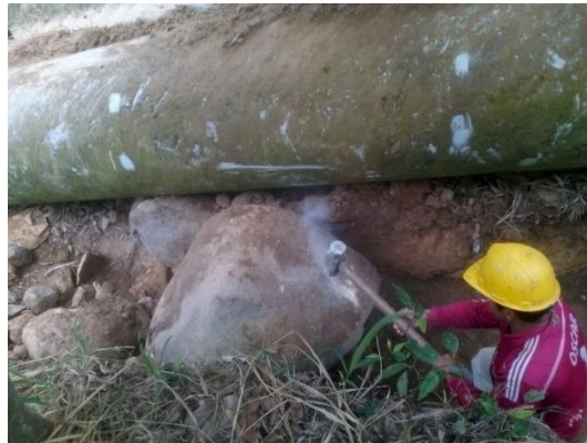
Imagen 15 – Excavación manual de rocas línea de impulsión Bosconia.
