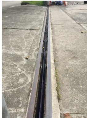
Imagen 37 – Desarrollo de actividades subestación La Sierra 4.
