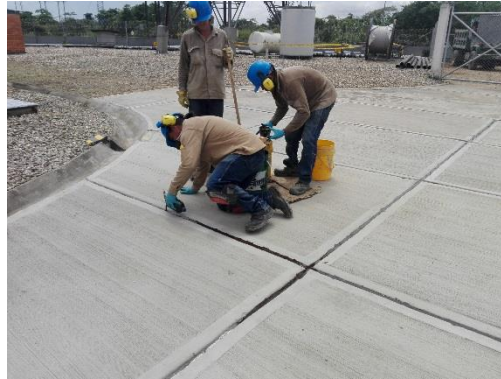
Imagen 28 – Desarrollo de actividades subestación Caño Limón 5.
