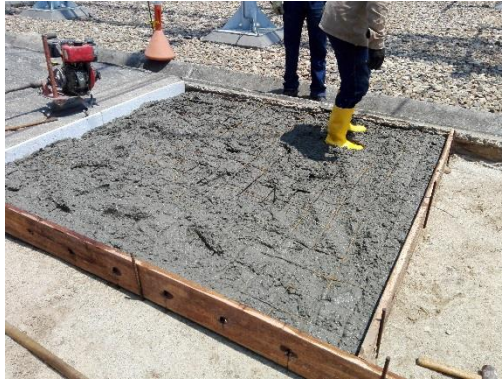
Imagen 26 – Desarrollo de actividades subestación Caño Limón 3.
