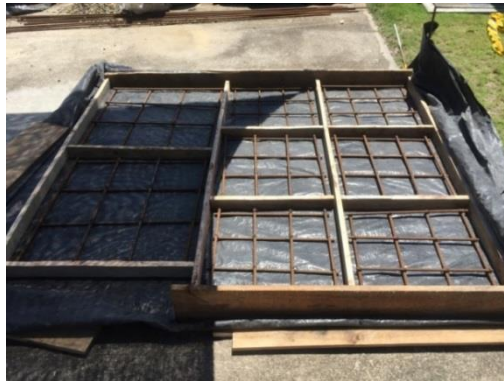
Imagen 35 – Desarrollo de actividades subestación La Sierra 2.
