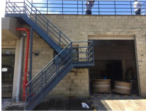
Imagen 41 – Desarrollo de actividades subestación La Sierra 8.
