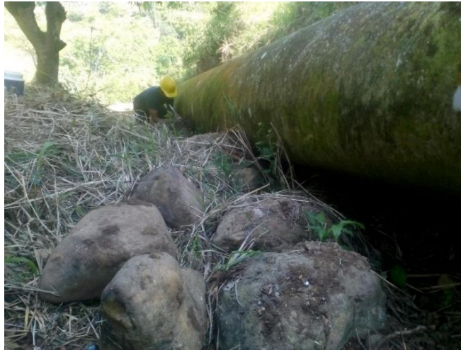
Imagen 14 – Aspecto inicial línea de impulsión Bosconia 3.
