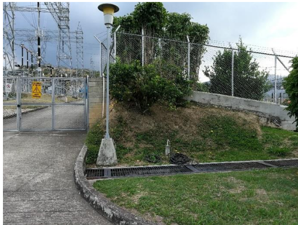
Imagen 21 – Ubicación muro de contención subestación Ocaña.
