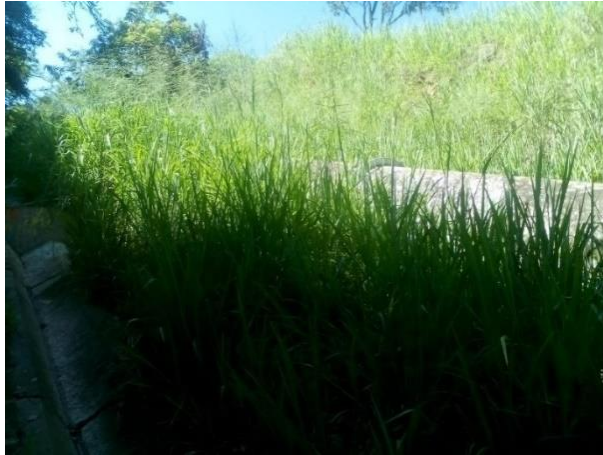
Imagen 12 – Aspecto inicial línea de impulsión Bosconia 1.
