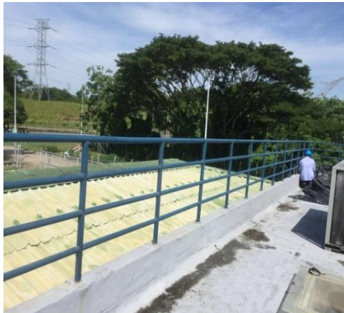
Imagen 40 – Desarrollo de actividades subestación La Sierra 7.
