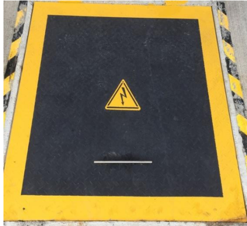
Imagen 39 – Desarrollo de actividades subestación La Sierra 6.
