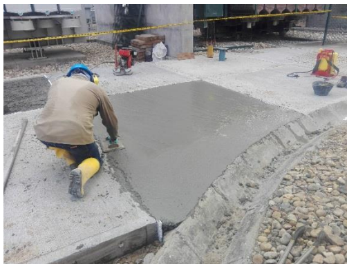
Imagen 27 – Desarrollo de actividades subestación Caño Limón 4.
