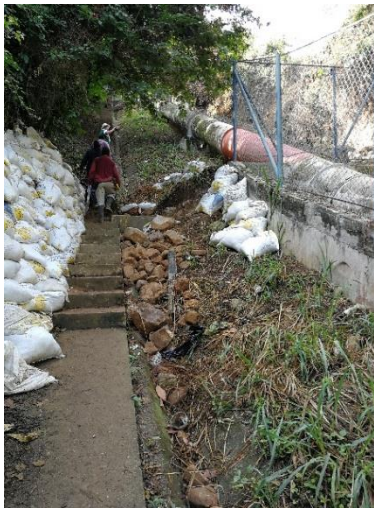
Imagen 13 – Aspecto inicial línea de impulsión Bosconia 2.
