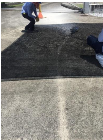
Imagen 34 – Desarrollo de actividades subestación La Sierra 1.
