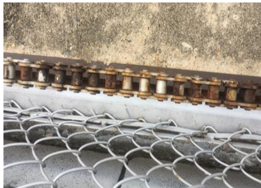
Imagen 38 – Desarrollo de actividades subestación La Sierra 5.
