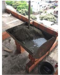
Figura 25. Preparación de mezcla (arena, cemento y agua)
