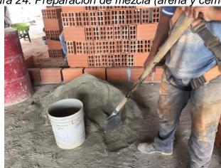
Figura 24. Preparación de mezcla (arena y cemento)
