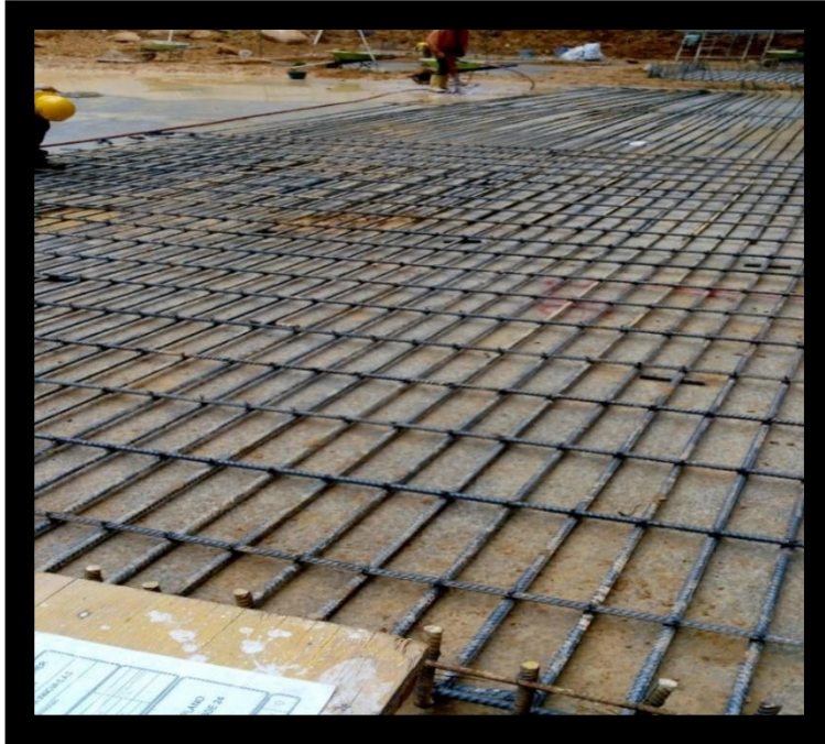
Ilustración 13: Medición de separación de hierros en parrilla inferior de cimentación edificio Millenium Bussines Tower.
