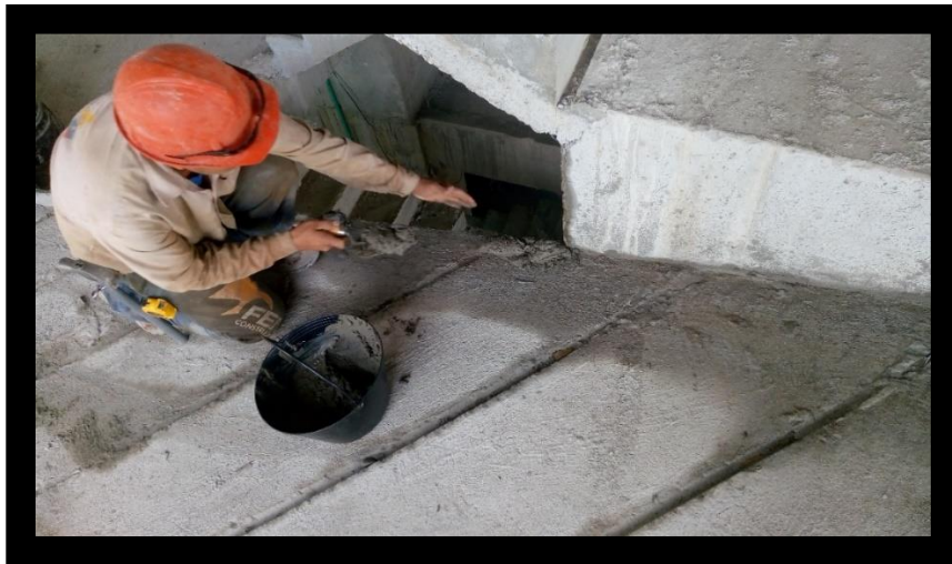
Ilustración 22: Aplicación de mezcla (poyo) para evitar la filtración de agua en pisos inferiores
