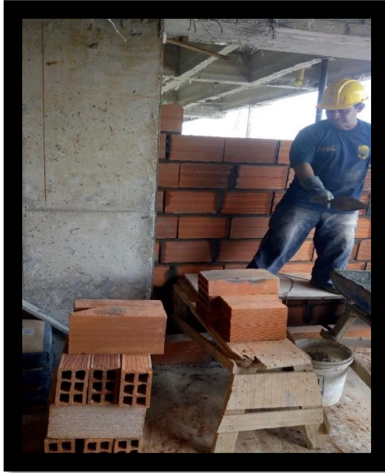
Ilustración 5: Ladrillos entregados para mampostería
