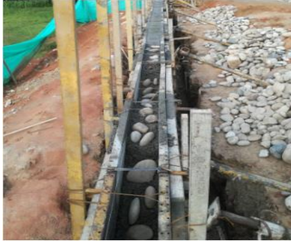
MURO EN CONCRETO CICLOPEO
