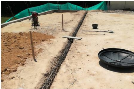
ACERO DE REFUERZO
