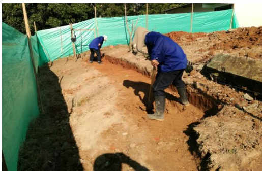
EXCAVACION MANUAL PARA CIMINETOS
