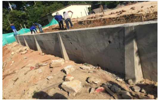
MURO EN CONCRETO CICLOPEO
