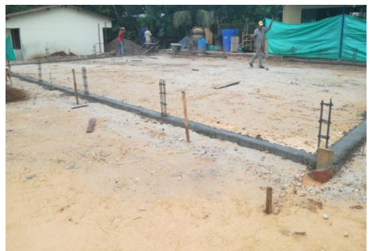
CONCRETO VIGA DE CIMENTACION 0,20 M X 0,20 M
