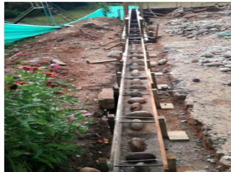
MURO EN CONCRETO CICLOPEO
