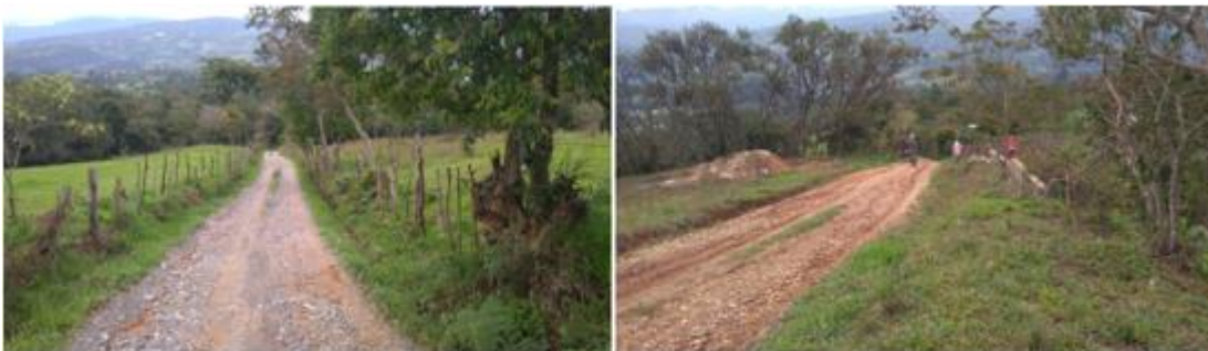
Ilustración 18. Estado actual TRAMO 2- Barbosa Santander
