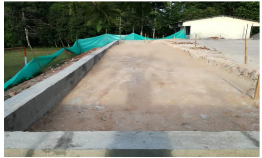
RELLENO COMPACTADO EN MATERIAL SELECCIONADO
