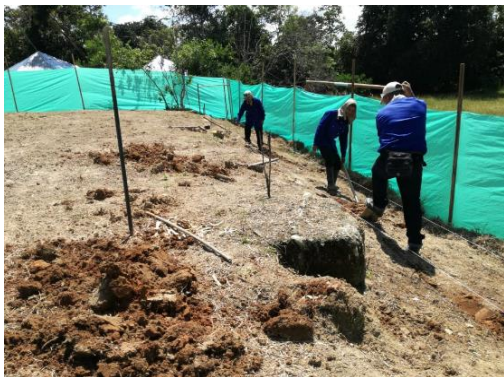
DESMONTE Y DESCAPOTE
