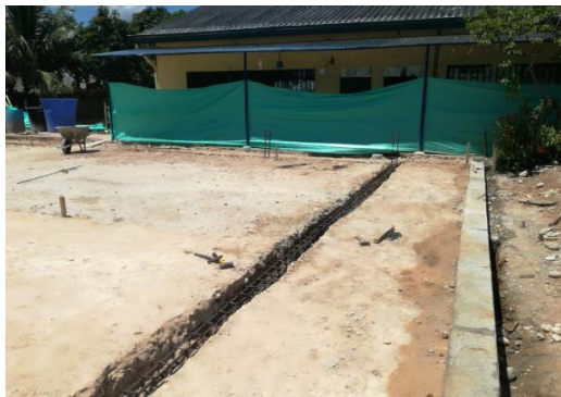
CONCRETO VIGA DE CIMENTACION 0,20 M X 0,20 M
