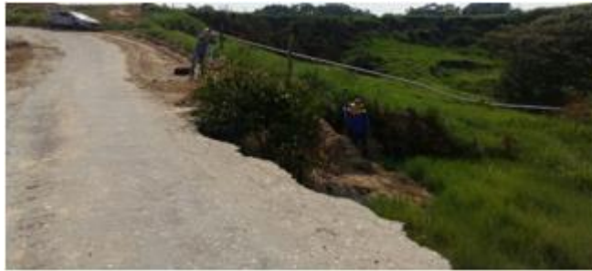
Ilustración 20. Estado actual via que conduce a la vereda mata de piña
