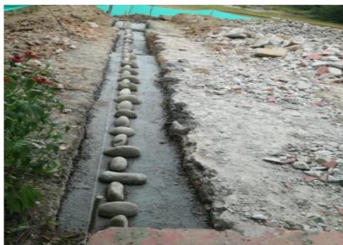
MURO EN CONCRETO CICLOPEO
