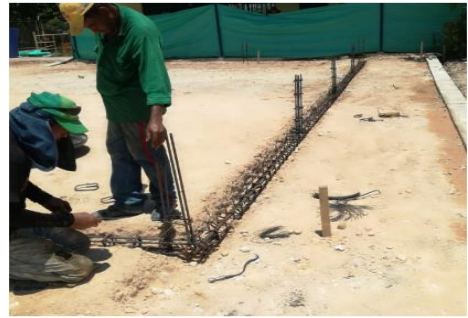
ACERO DE REFUERZO
