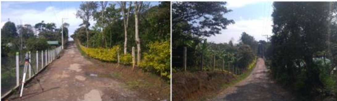
Ilustración 17. Estado actual TRAMO 1- Barbosa Santander
