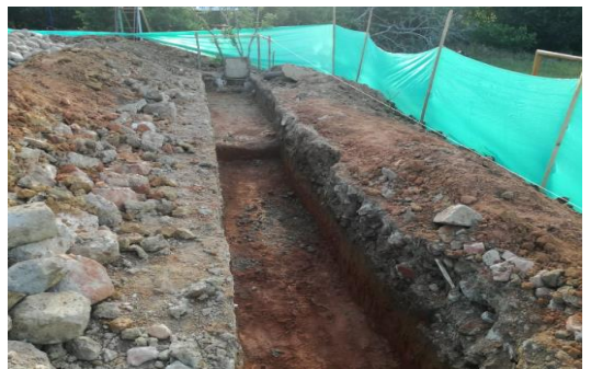
EXCAVACION MANUAL PARA CIMINETOS
