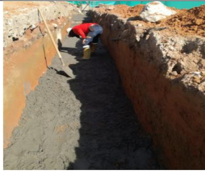
SOLADO DE LIMPIEZA
