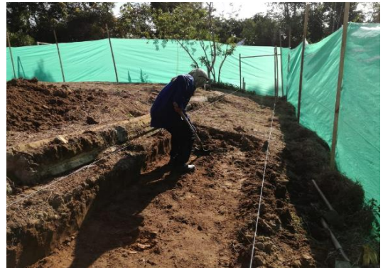
DESMONTE Y DESCAPOTE
