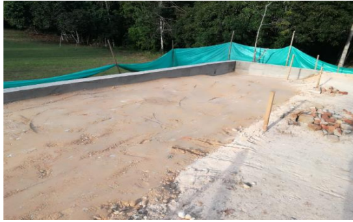
RELLENO COMPACTADO EN MATERIAL SELECCIONADO
