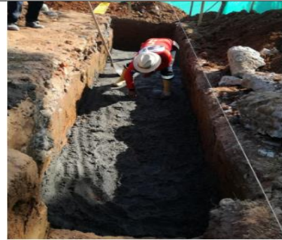
SOLADO DE LIMPIEZA
