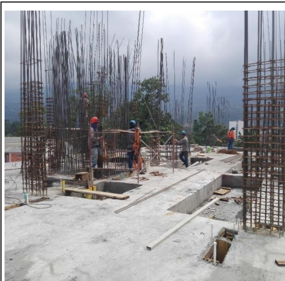
Figura 20. Armado de columnas (N+15.90). Fuente: PROINSAN S.A.S.
