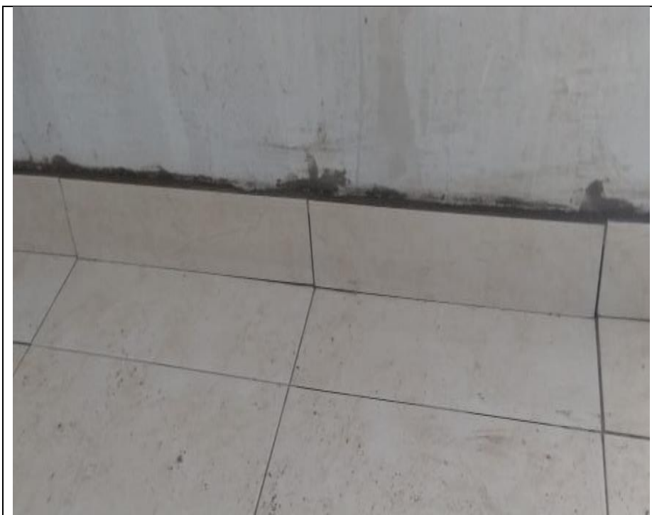
Figura 35. Guardaescoba en cerámica – Apto modelo. Fuente: PROINSAN S.A.S.
