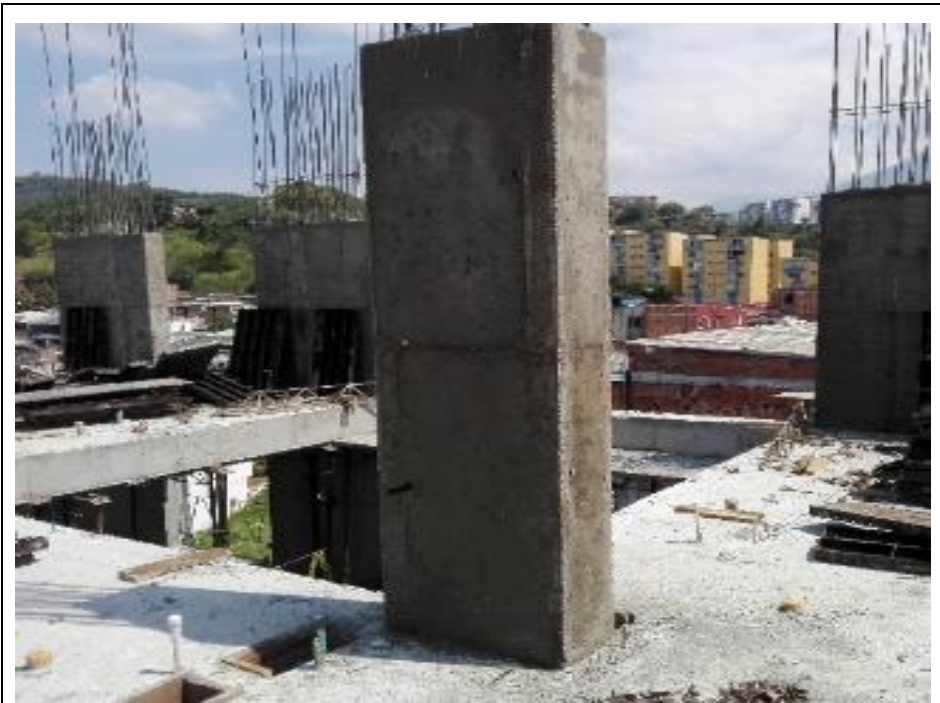
Figura 23. Desencofrado de columnas (N+15.90). Fuente: PROINSAN S.A.S.
