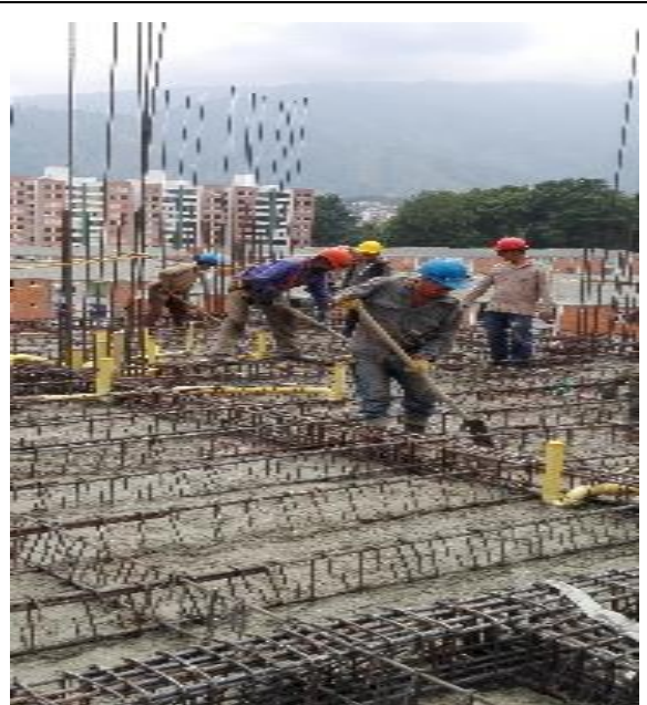
Figura 15. Fundida de placa - Piso 6 N+15,90).
