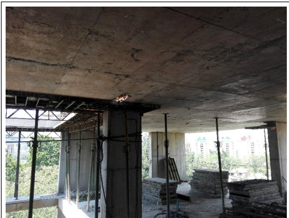
Figura 19. Desencofrado de placa - Piso 6 (N+15,90). Fuente: PROINSAN S.A.S.
