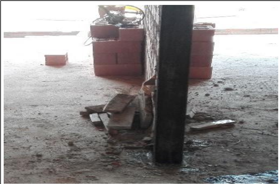
Figura 28. Columneta – Piso 3. Fuente: PROINSAN S.A.S
