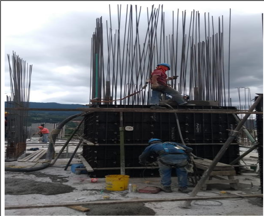
Figura 24. Armado y fundida de ascensor Piso 7 (N+18.55). Fuente: PROINSAN S.AS.
