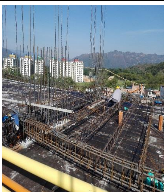
Figura 14. Armado - Piso 6 (N+15,90). Fuente: PROINSAN S.A.S.
