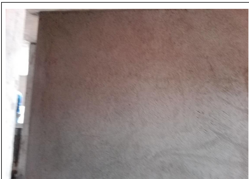
Figura 29. Friso liso sobre muro – Apto modelo. Fuente: PROINSAN S.A.S.
