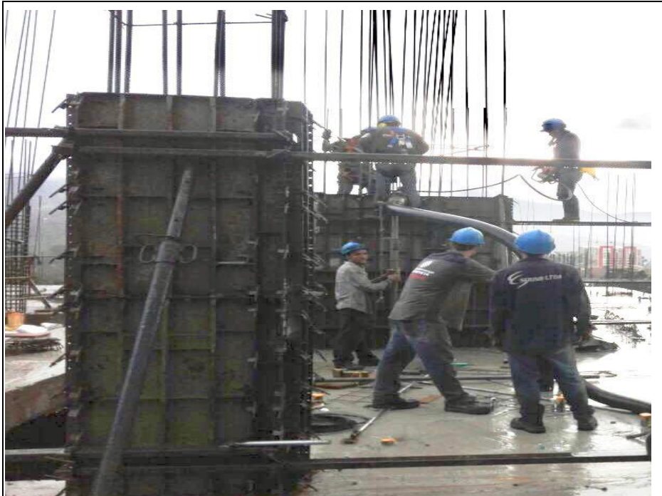
Figura 22. Fundida de columnas (N+15.90). Fuente: PROINSAN S.A.S.
