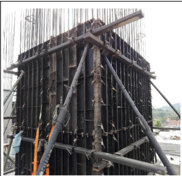
Figura 21. Encofrado de columnas (N+15.90).
