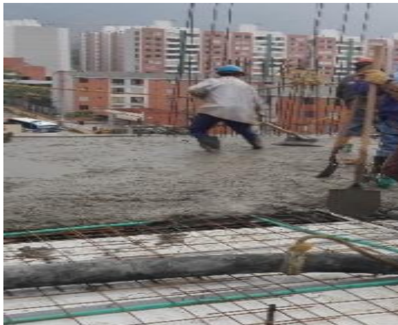
Figura 17. Fundida de placa - Piso 6 (N+15,90). Fuente: PROINSAN S.A.S.
