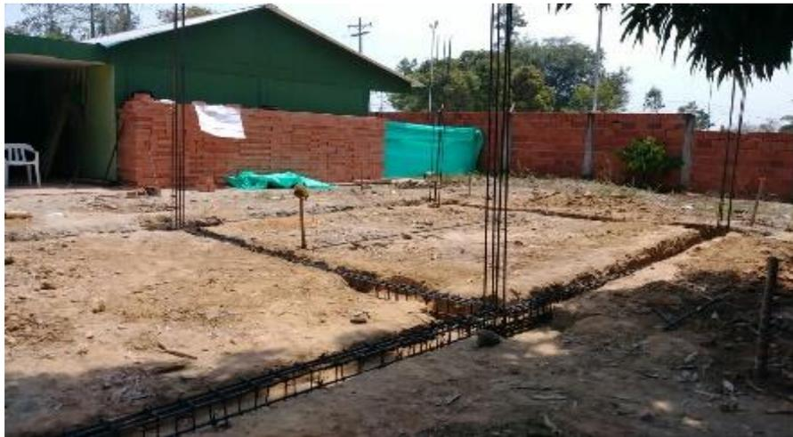
*Fig. 5. ARMADO DE ACERO*
