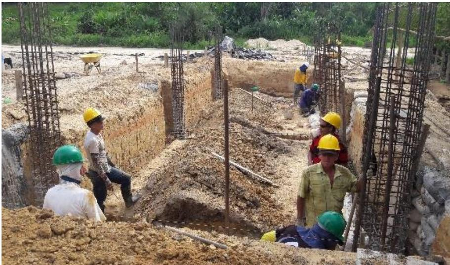
*Fig. 13 EXCAVACIÓN Y ARMADO DE ACERO EN OFICINAS*
