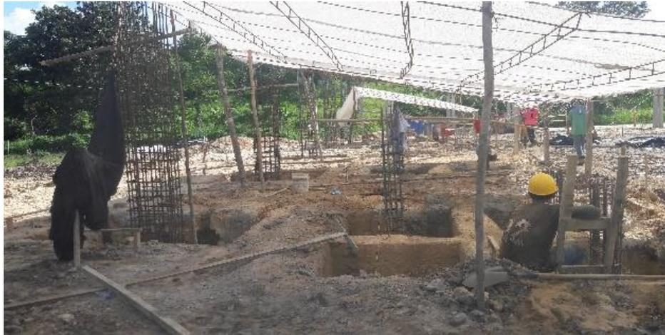
*Fig. 14 ARMADO DE ACERO PARA COLUMNAS DE LA GRADERÍA*
