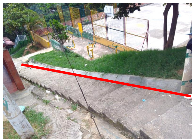
Figura 25. Ubicación de baranda en la Cra. 9
