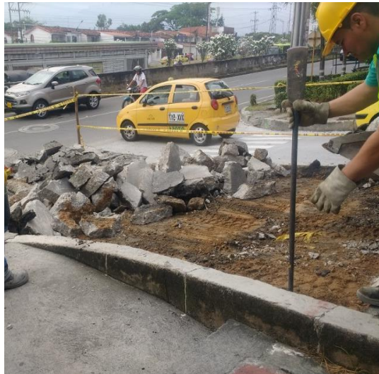
Figura 6. Demolición estructura de pavimento.
