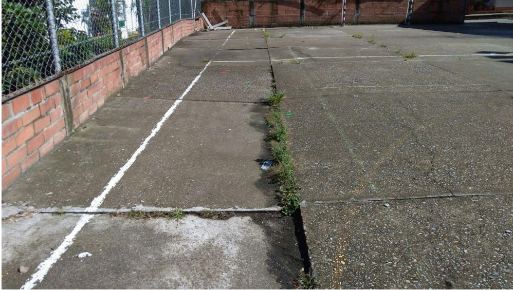
Figura 2. Estado actual Polideportivo del conjunto Paragüitas Real.
