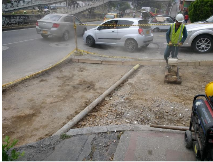
Figura 7. Compactación y nivelación del terreno.
