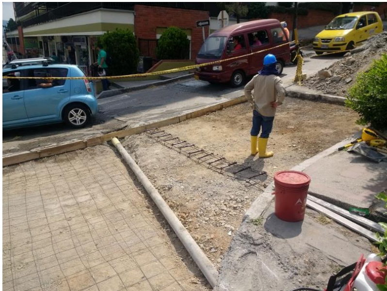
Figura 8. Preparación terrena para fundida.
