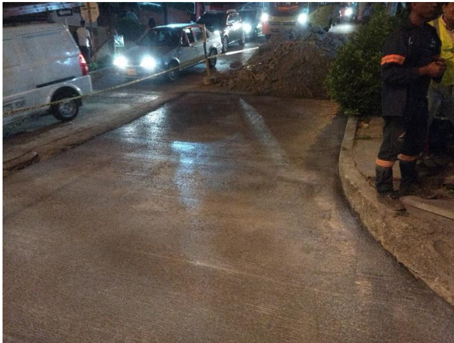
Figura 10. Aplicación Antisol.
