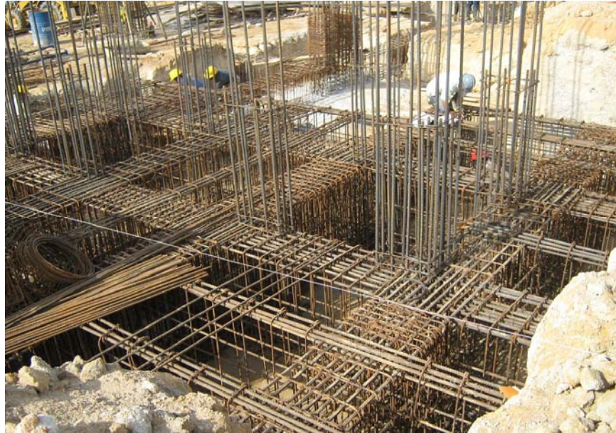
Figura 16. Cimentación y Arranque Pantallas Foso de Ascensor
