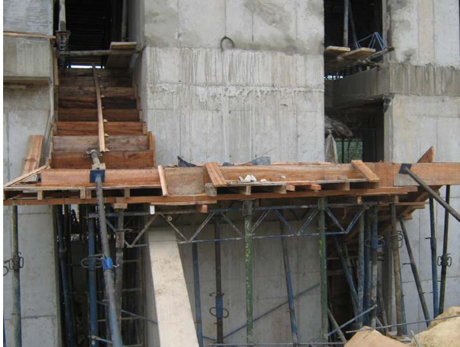
Figura 39. Armado Escaleras Sótano 2 Torre 1
