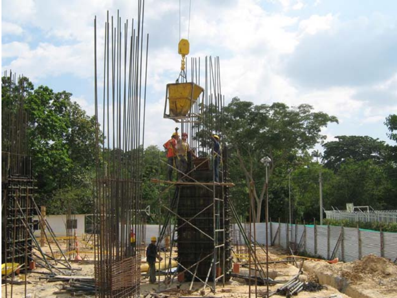
Figura 19. Fundida de Columnas
