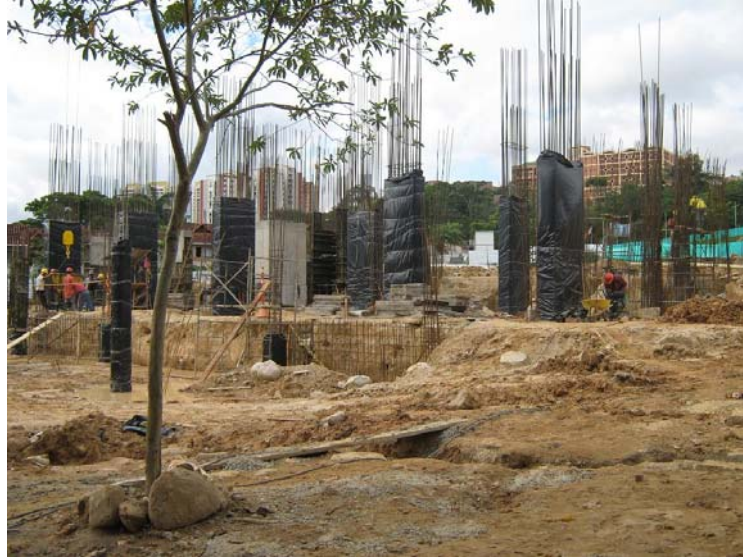
Figura 21. Columnas Torre 1 Sótano 2
