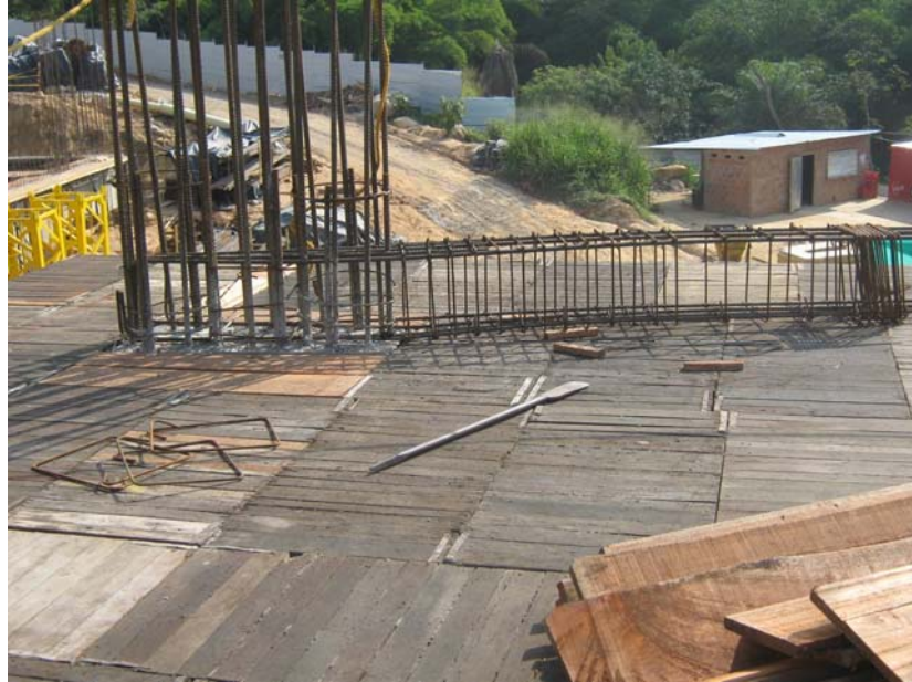
Figura 37. Armado Vigas Placa Torre 1 Piso 1 N+815.90
