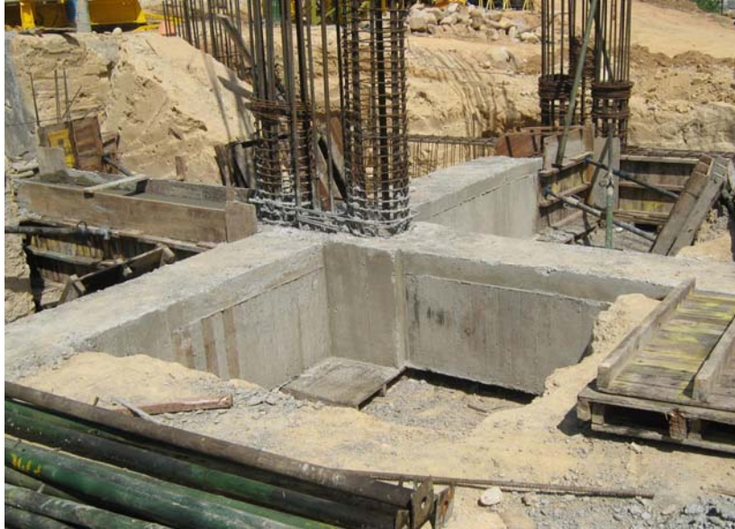
Figura 17. Arranque de Columnas Torre 1
