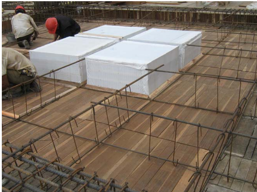
Figura 38. Armado Placa Aligerada Vigas, Viguetas, Aligerante (lona).
