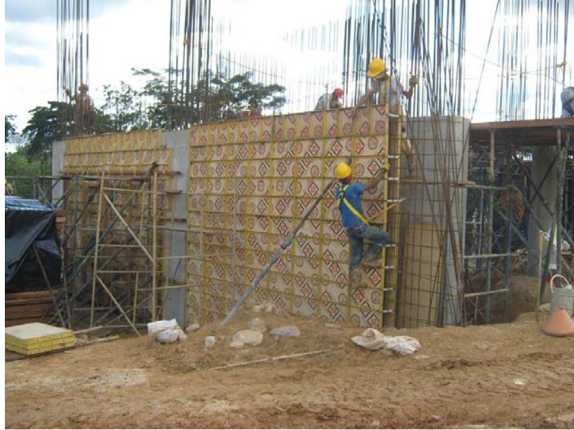
Figura 24. Fundida Muro de Contención Torre 1 Sótano 2
