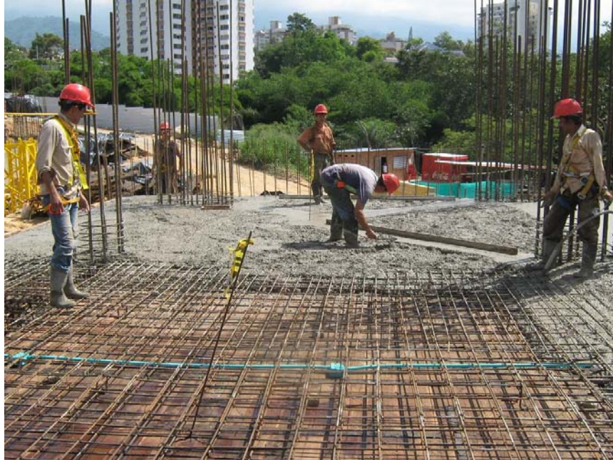
Figura 27. Fundida Placa Maciza N+813 Torre 1 Sótano 1
