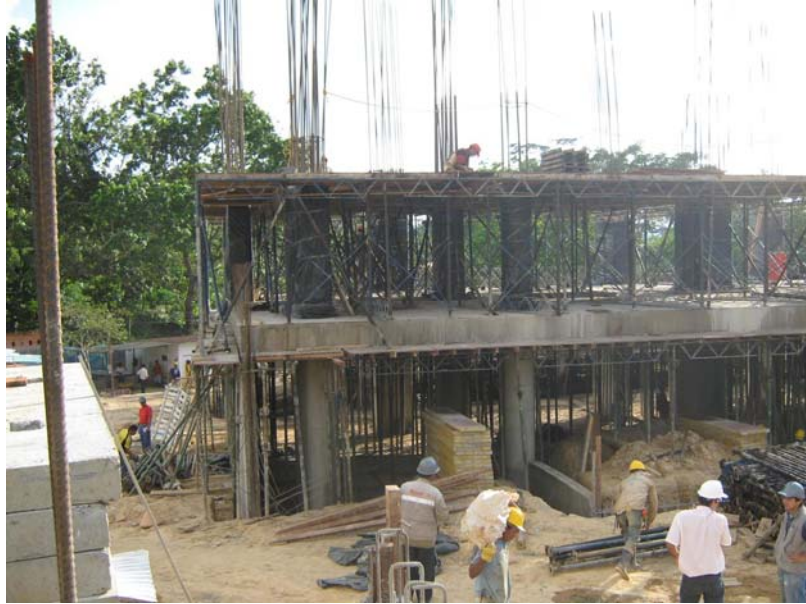
Figura 36. Cimbrado Vigas Placa Piso 1 Torre 1 N+815.90
