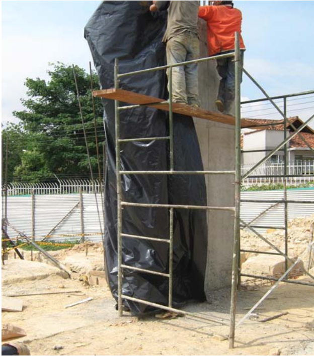
Figura 20. Curado en Campo Elementos Estructurales
