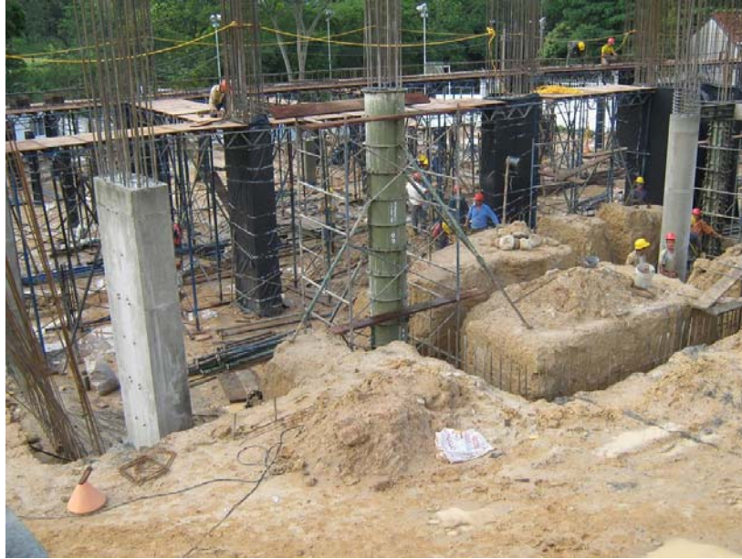
Figura 26. Armado Placa Sótano 1 N+813
