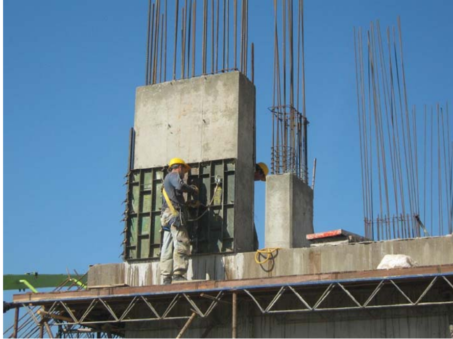
Figura 34. Encofrado Foso de Ascensor
