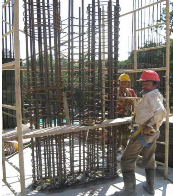
Figura 30. Encofrado de Columnas con la Formaleta Manoportable
