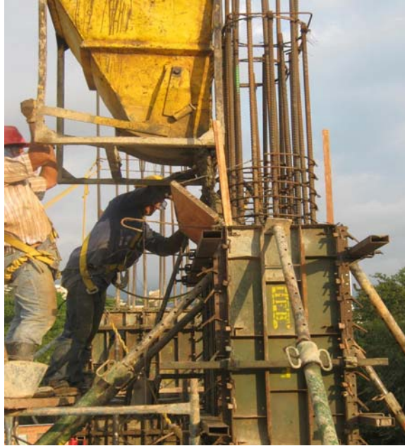
Figura 32. Verificación de Plomos después de Fundir el Elemento
