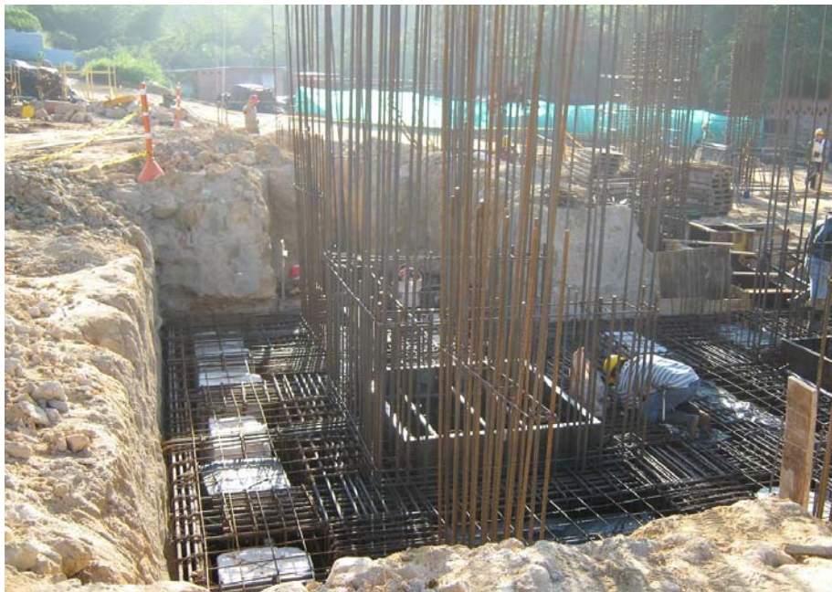
Figura 16. Cimentación y Arranque Pantallas Foso de Ascensor
