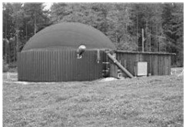
Figura 9, Digestor con tanque de almacenamiento
