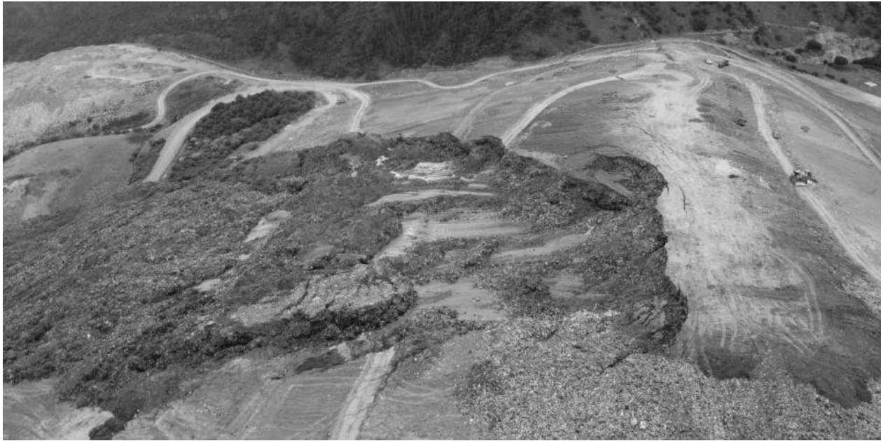
Figura 11, deslizamiento en relleno Doña Juana
