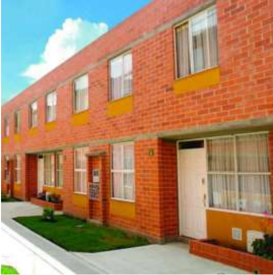
Fotografía 3. Mampostería a la vista en fachada
