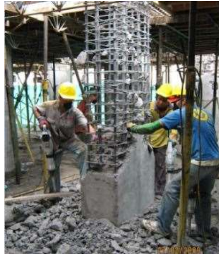
Fotografía 13. Retrabajos por falta de planificación (BOTERO, 2017) Fotografía 14. Falta de requerimiento técnico (BOTERO, 2017)
