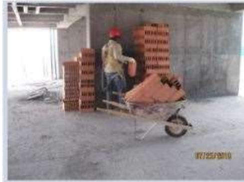
Fotografía 23. Sobrecarga de material (BOTERO, 2017) Fotografía 24. Uso de herramientas de transporte indebidas (BOTERO, 2017)
