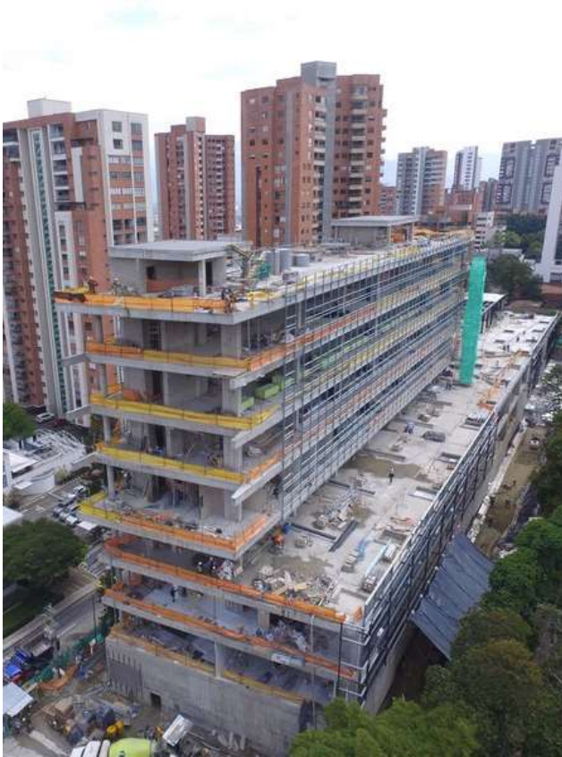
Fotografía 28. Cámara de Comercio de Medellín. Conconcreto
