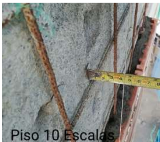
Fotografía 8. Revisión malla borde de losa para chapas
