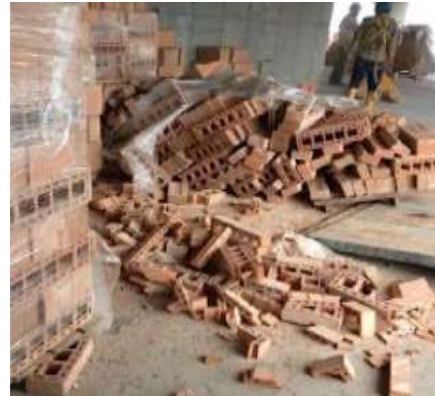
Fotografía 17. Desperdicio por mal transporte (BOTERO, 2017) Fotografía 18. Desperdicio por mal almacenamiento (BOTERO, 2017)
