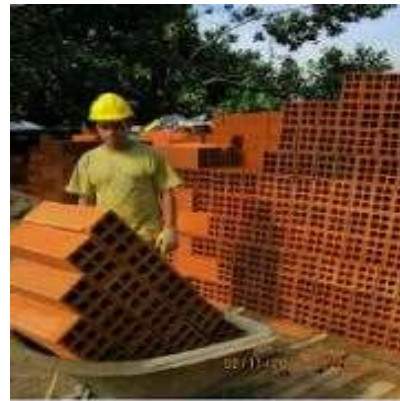
Fotografía 19. Método erróneo de transporte (BOTERO, 2017) Fotografía 20. Herramienta de transporte no apta (BOTERO, 2017)
