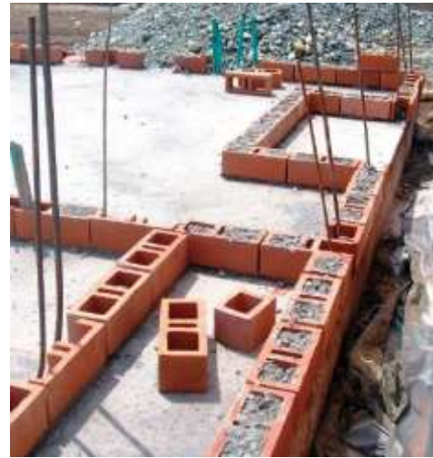
Fotografía 2. Refuerzos de hierro
