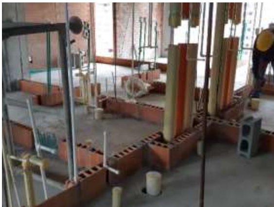
Fotografía 9. Redes sanitarias y desagüe interior
