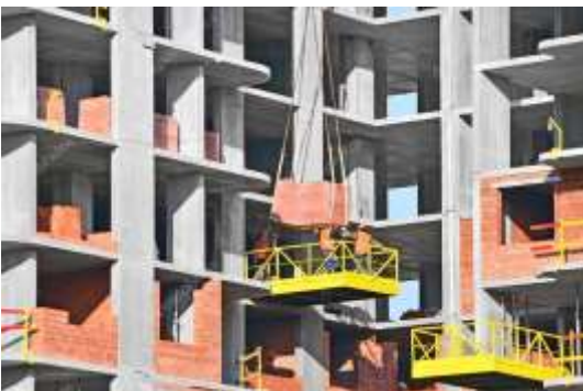
Fotografía 11. Transporte Horizontal del Ladrillo
