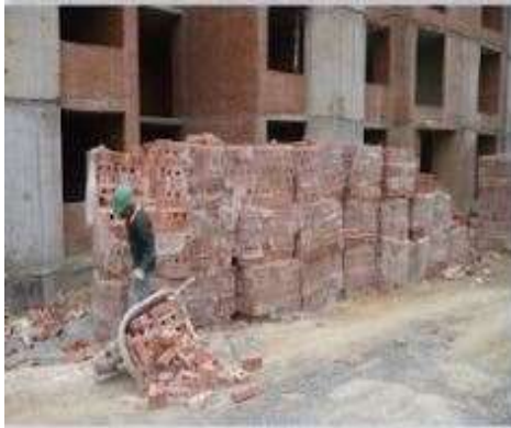
Fotografía 17. Desperdicio por mal transporte (BOTERO, 2017) Fotografía 18. Desperdicio por mal almacenamiento (BOTERO, 2017)
