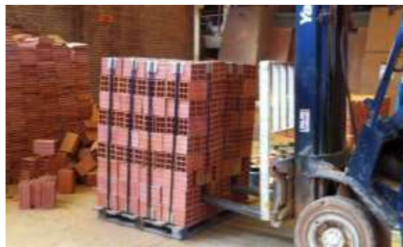
Fotografía 12. Transporte Vertical del Ladrillo
