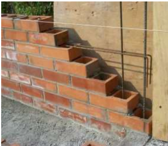
Fotografía 1. Mampostería estructural con refuerzos
