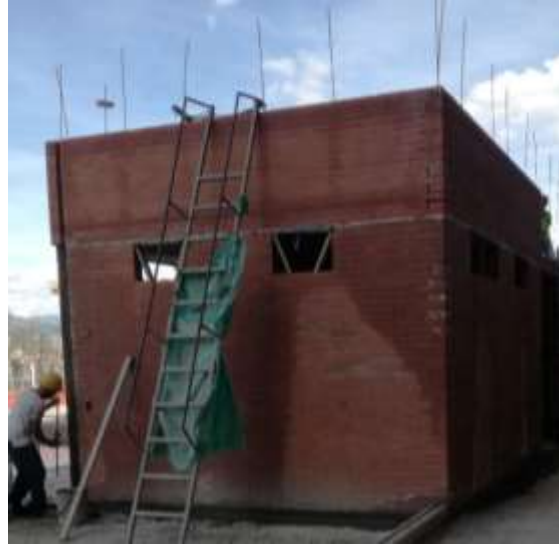
Fotografía 4. Mampostería a la vista
