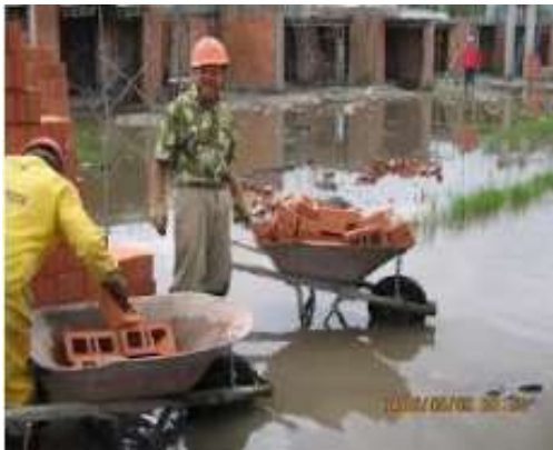
Fotografía 19. Método erróneo de transporte (BOTERO, 2017) Fotografía 20. Herramienta de transporte no apta (BOTERO, 2017)
