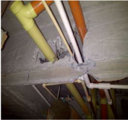
Fotografía 13. Retrabajos por falta de planificación (BOTERO, 2017) Fotografía 14. Falta de requerimiento técnico (BOTERO, 2017)
