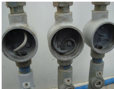
Imagen 12. Mantenimiento correctivo a cajas de paso o pasacables en tanques
