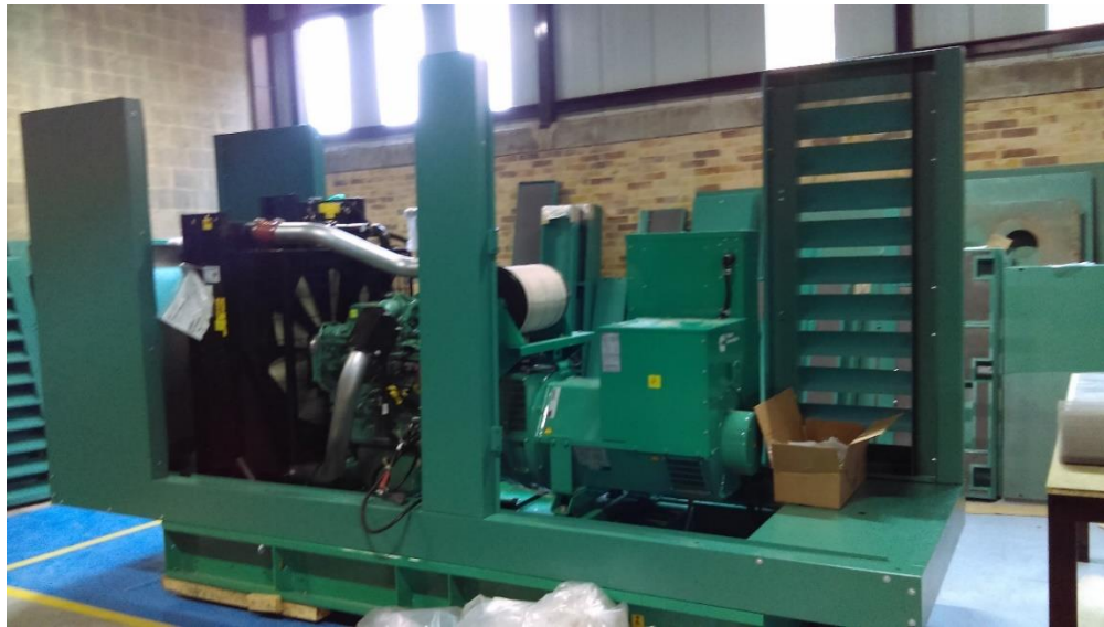
Figura 7. Ensamble de la cabina insonora al grupo electrógeno.
