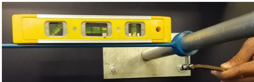
Figura. 10. Nivelación y ajuste de la b barra de medición de desplazamiento vertical
