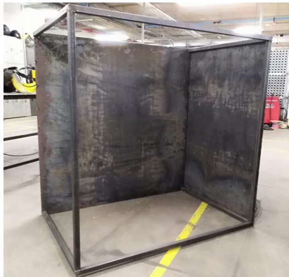
Figura 40. Ensamble de la estructura y las láminas de cobertura
