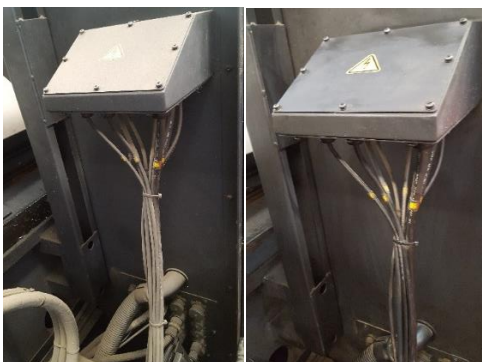
Figura 23 y 24. Antes y después unidad eléctrica.
