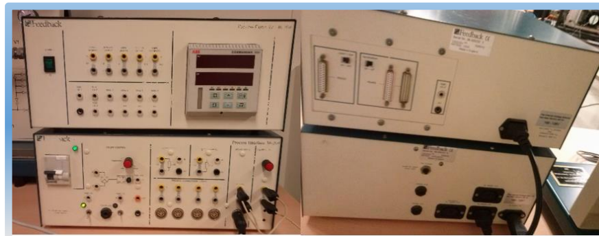
Figura 13. Interfaz de Proceso y Controlador ABB Commander 300
