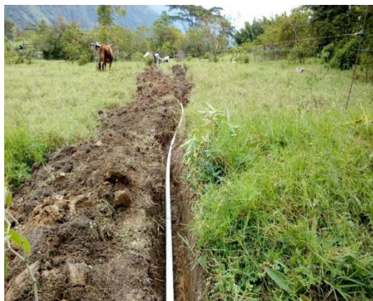
Imagen 9 Suministro e instalación de tubería de 1/2"
