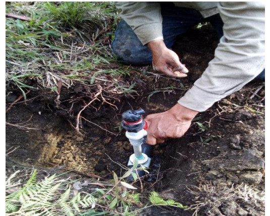
Imagen 11 Suministro e instalación de válvula ventosa.
