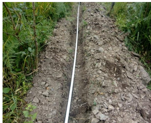
Imagen 9 Suministro e instalación de tubería de 1/2"
