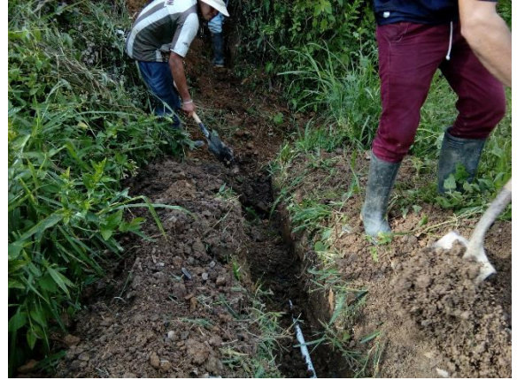
Imagen 13 Relleno manual con material seleccionado de la excavación.
