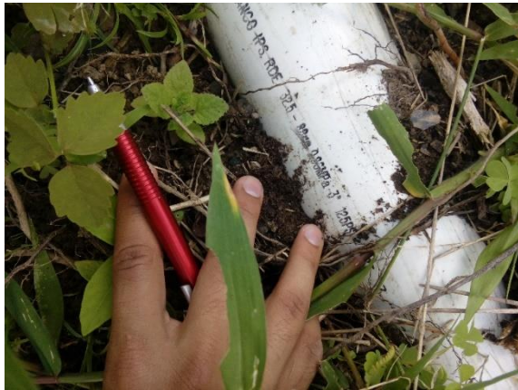
Imagen 2 Evidencia de tubería de 3" RDE 32.5 y desarenador la cabaña.
