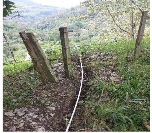
Imagen 10 Suministro e instalación de tubería de 1" con sus respectivas uniones.
