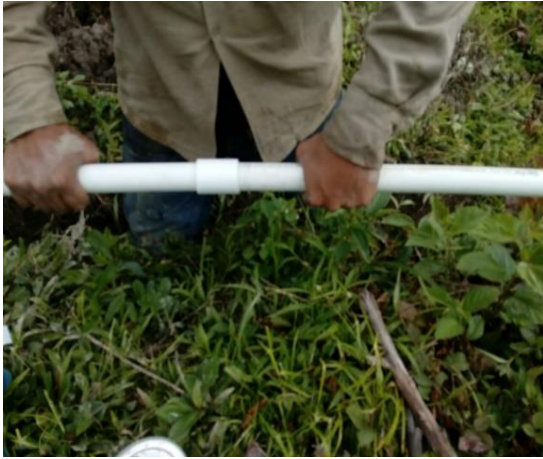
Imagen 10 Suministro e instalación de tubería de 1" con sus respectivas uniones.
