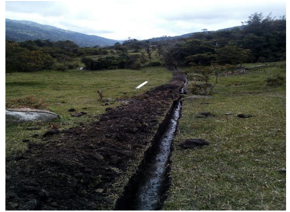
Imagen 7 Excavación manual para instalación de tubería.
