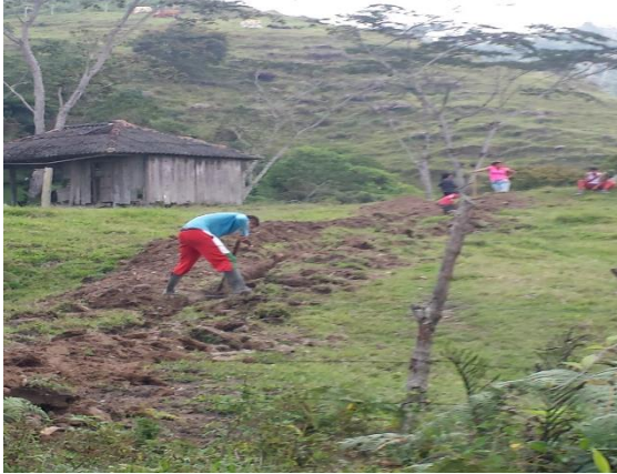
Imagen 13 Relleno manual con material seleccionado de la excavación.
