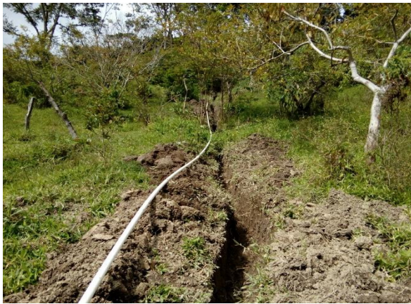
Imagen 7 Excavación manual para instalación de tubería.
