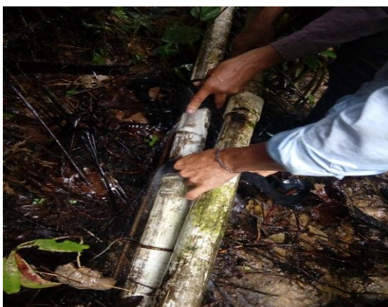
Imagen 1 Tubería en mal estado y cristalizada en zona de inspección.
