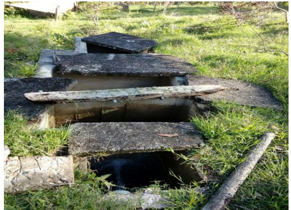
Imagen 2 Evidencia de tubería de 3" RDE 32.5 y desarenador la cabaña.
