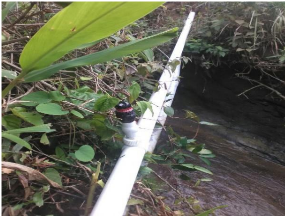
Imagen 11 Suministro e instalación de válvula ventosa.
