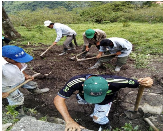
Imagen 14 Trabajo de extensión de tierra sobre tubería instalada.
