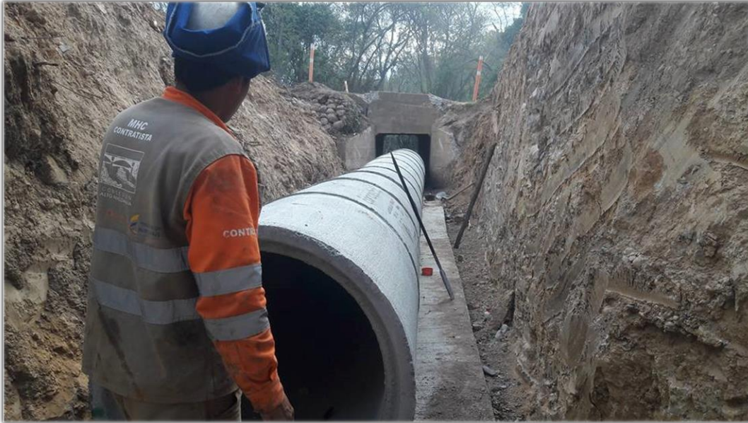
Figura 8. Instalación tubería en concreto reforzado Diámetro = 90 cm.
