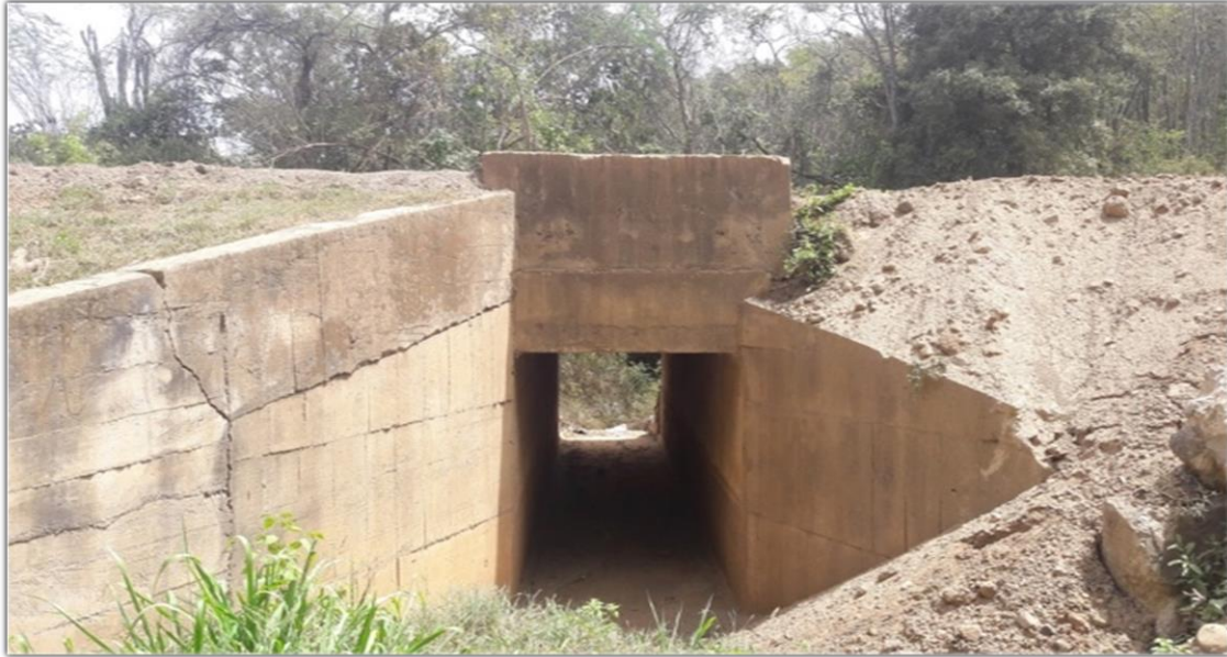
Figura 4. Box culvert antiguo km 85+955.
