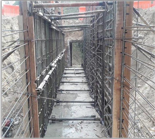
Figura 7. Vista frontal del encofrado y del plano del Box coulvert 2 X 2 m.
