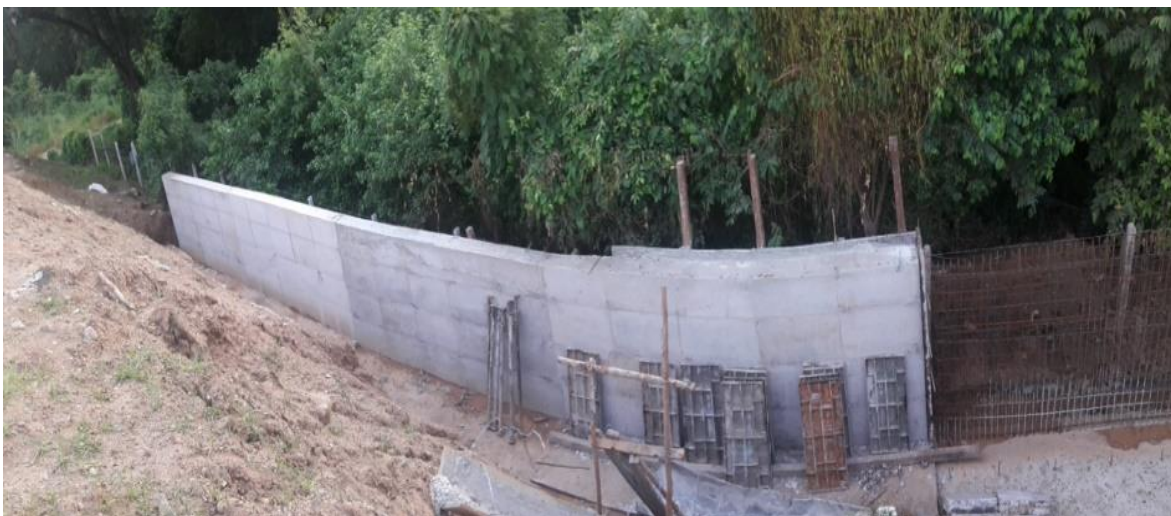
Figura 11. Muro patero en etapa de ejecución km 79+800, módulos 1,2 y 3.
