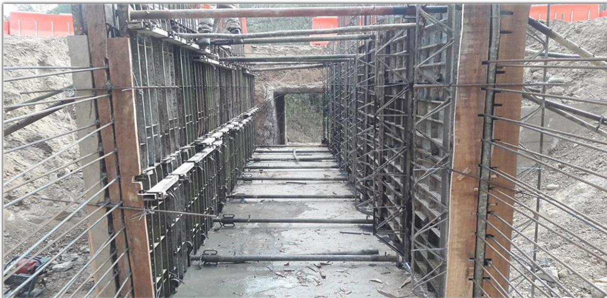
Figura 14. Izquierda método alineador-corbata, derecha método cercha torón.
