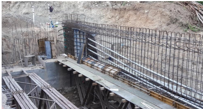
Figura 13. Encofrado viga 1, etapa 1 Puente 16G. Tiempo de construcción de la viga con 1 maestro y 7 ayudantes (4 semanas).
