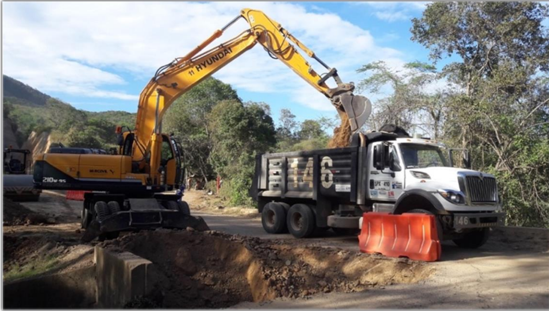
Figura 5. Excavación Box culvert Km85+955 /Retroexcavadora HYUNDAI 210-W.
