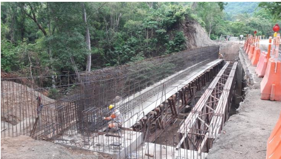
Figura 12. Amarre de aceros en la viga 1 etapa 1 puente 16G.
