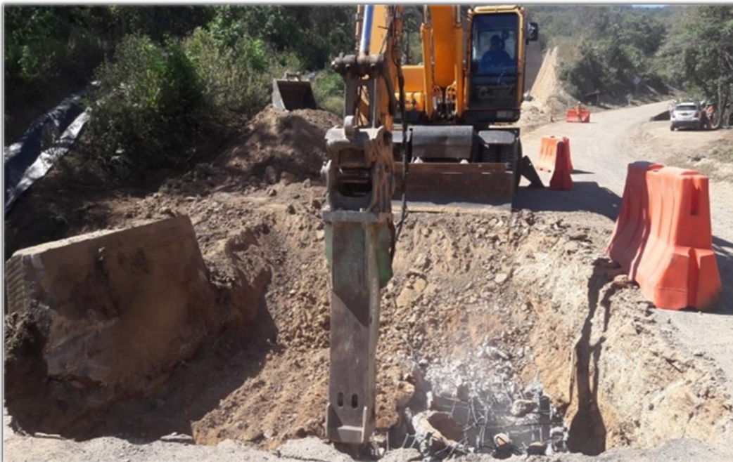
Figura 6. Demolición Box culvert Km 85+955 / Retroexcavadora HYUNDAI 210-W.
