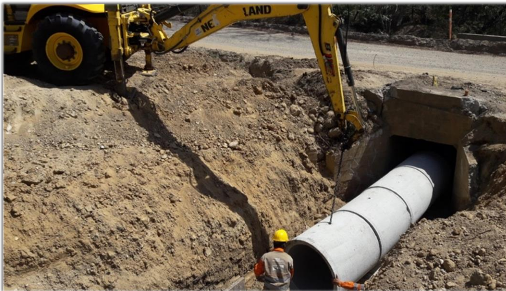
Figura 9. Descargue de tubería para alcantarilla no revestida.
