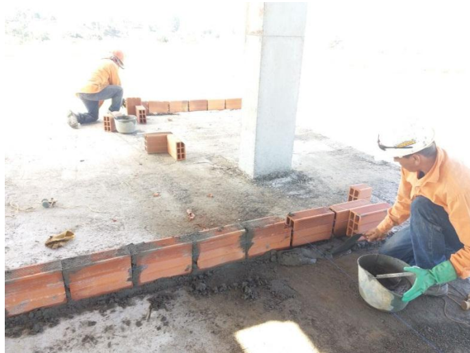
Imagen 22 - Replanteo de mampostería.
