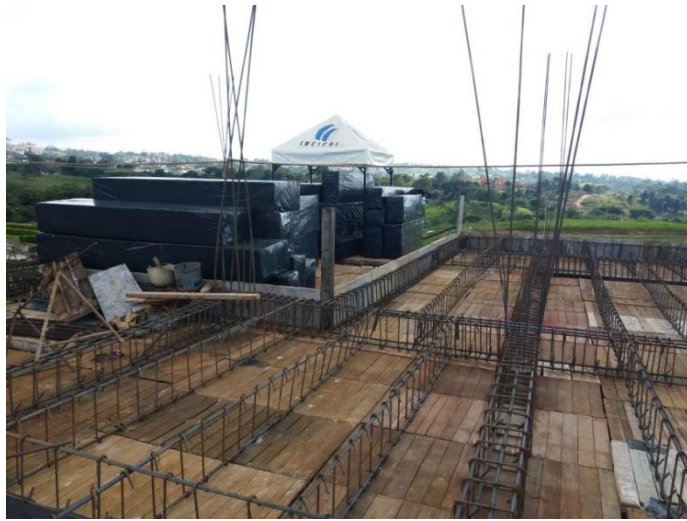
Imagen 2 - Acero instalado en la placa
