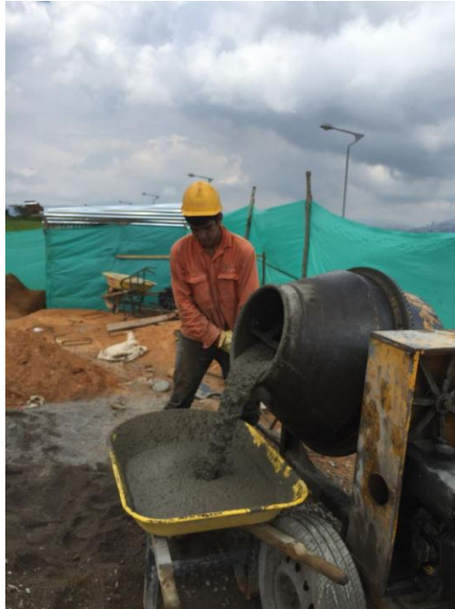
Imagen 11 - Mezcla de concreto para las columnas
