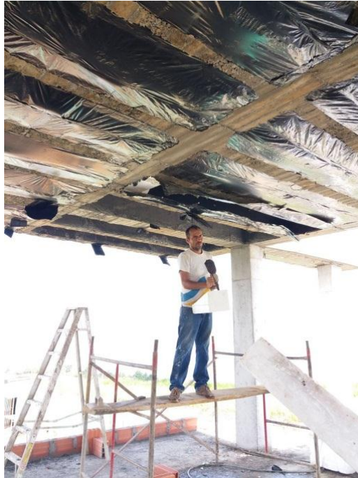
Imagen 8 - Retiro de los casetones
