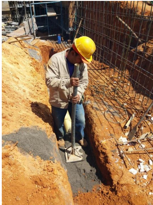
Imagen 17 - Compactacion de la cimentación de los colectores.
