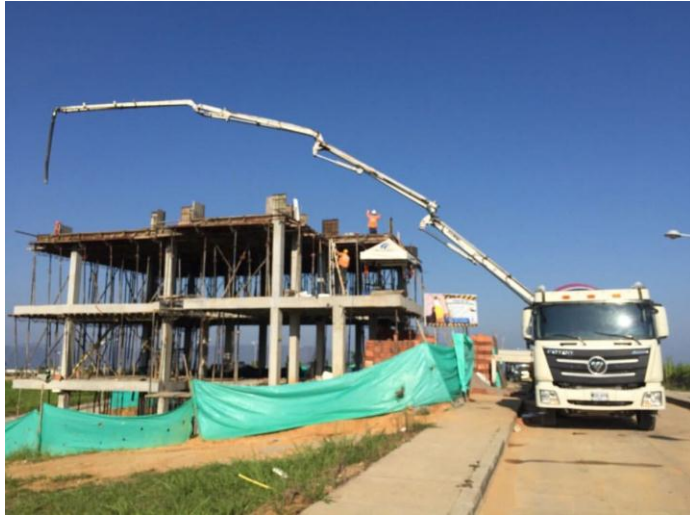
Imagen 12 - Colocación de concreto mediante autobomba
