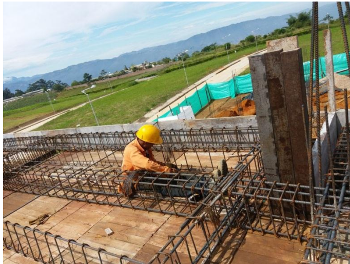
Imagen 1 - Instalación del acero en la placa
