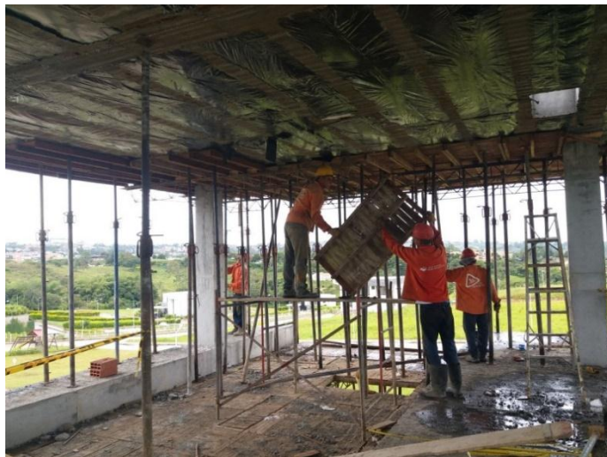
Imagen 7 - Desencofrado de formaleta
