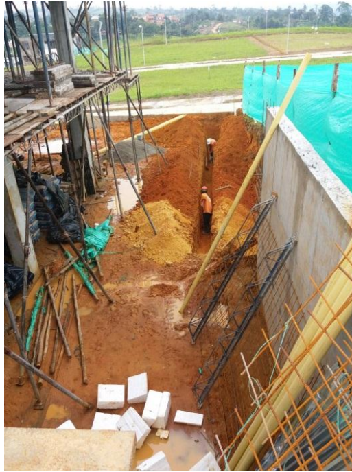
Imagen 15 - Excavación de zanjas para colectores
