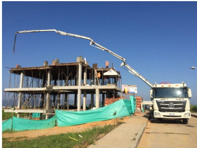
Imagen 26 - Colocación de concreto mediante autobomba.
