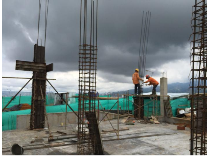
Imagen 9 - Instalación del acero en las columnas
