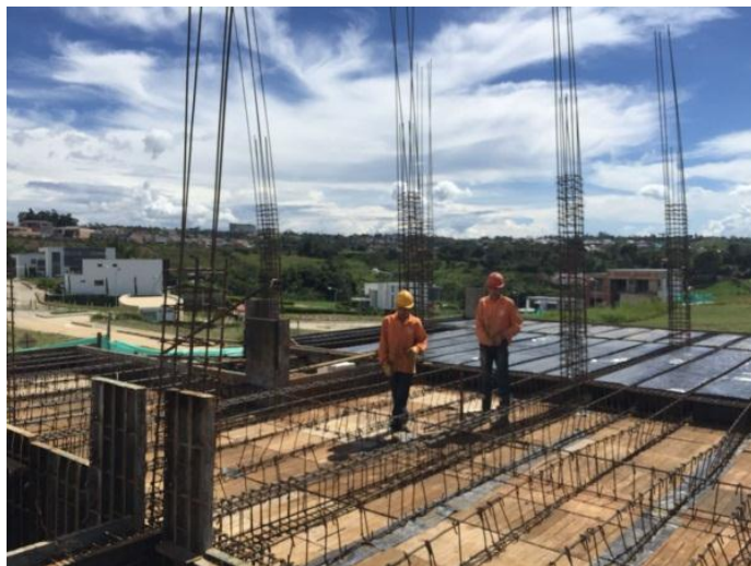
Imagen 3 - Instalación de casetones
