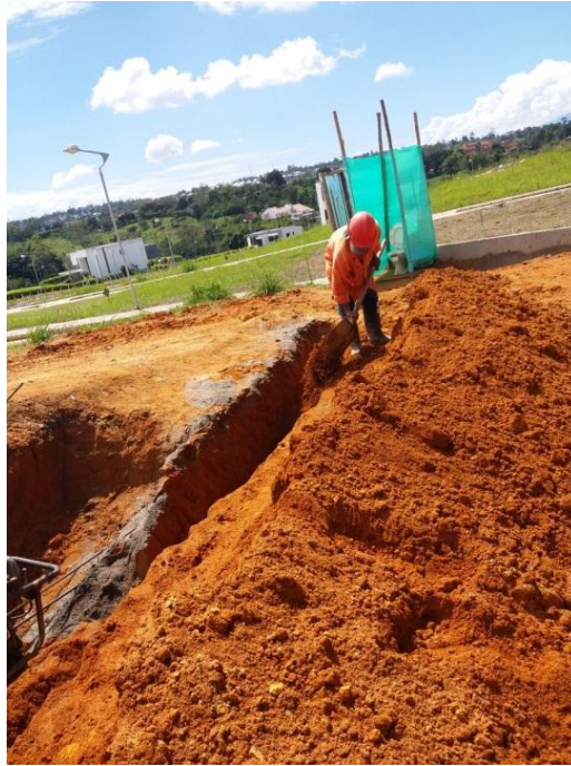
Imagen 18 - Relleno en material común.
