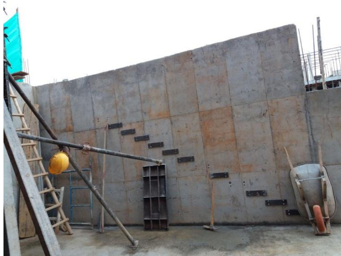
Imagen 29 - Platinas instaladas con pernos para escalera flotante.
