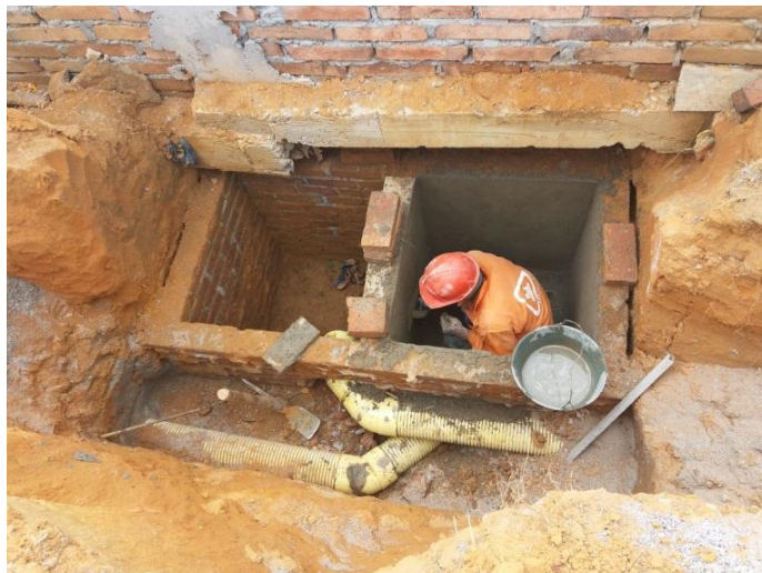
Imagen 21 - Friso e impermeabilización de cajas de inspección.
