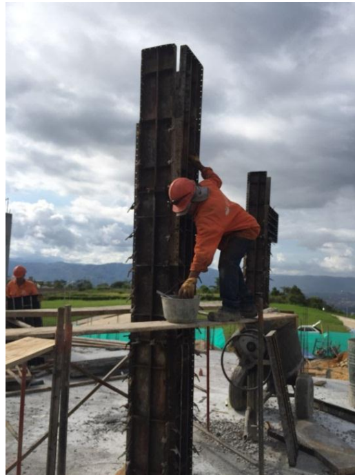
Imagen 10 - Instalación de la formaleta en las columnas
