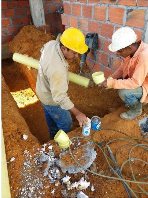
Imagen 27 - Instalación de redes sanitarias.
