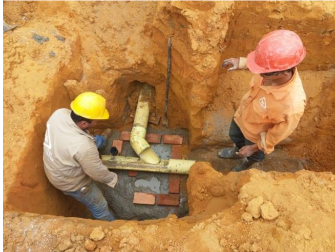
Imagen 20 - Construcción de cajas de inspección.
