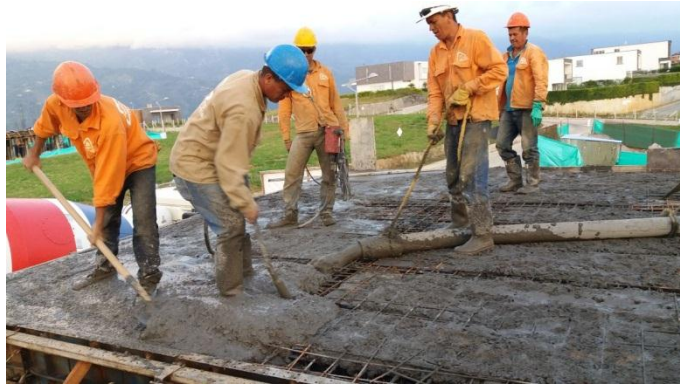
Imagen 4 - Suministro y colocación de concreto
