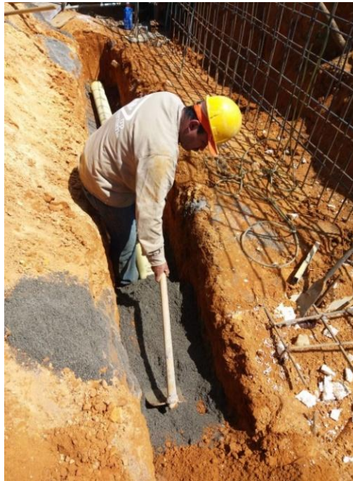
Imagen 16 - Cimentación de colectores.
