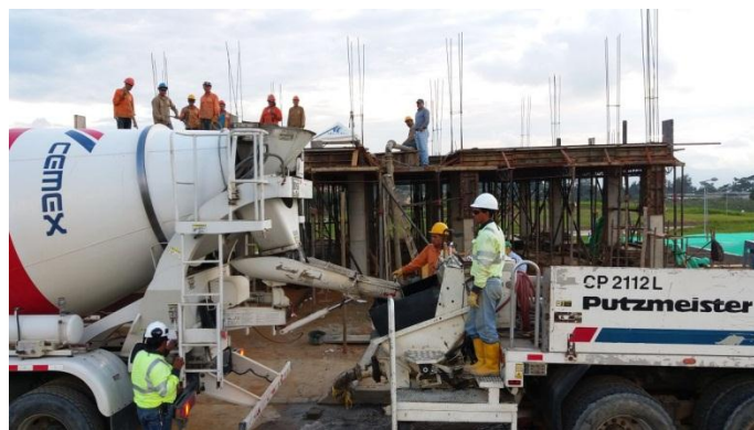
Imagen 5 - Suministro y colocación de concreto
