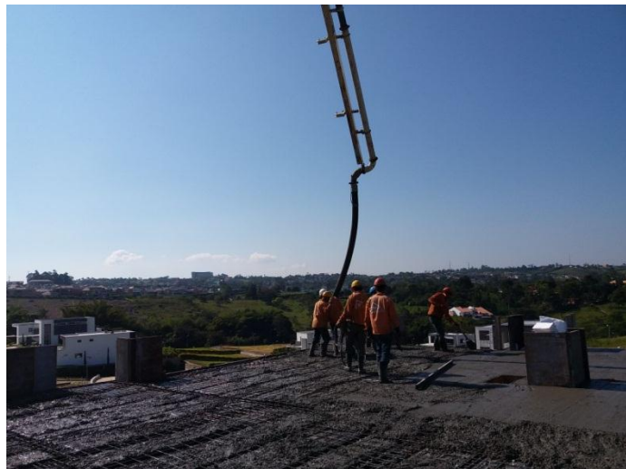
Imagen 13 - Suministro y colocación de concreto para cubierta
