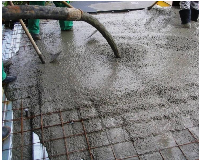
Figura No 4. Vaciado de concreto FUENTE: Blog 360| de Concreto
