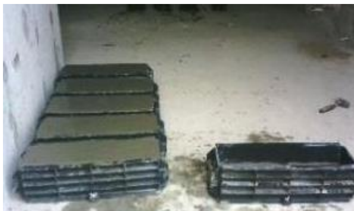
Figura 23. Elaboración de Vigas Fuente: PROPIA
