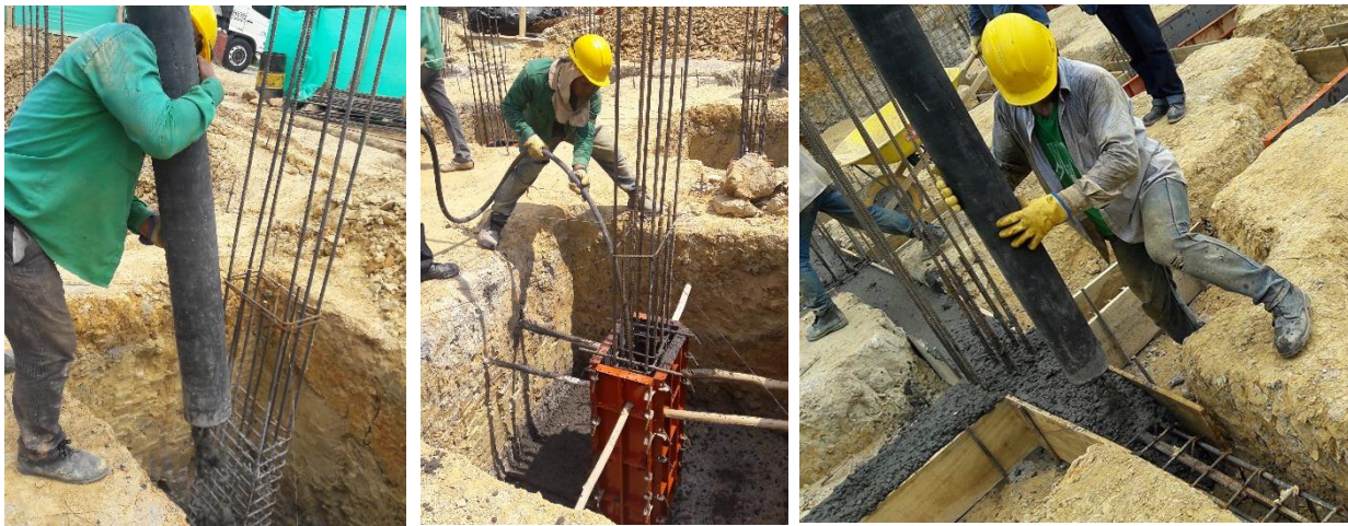
Figura 29 Fundida en obra Fuente: PROPIA
