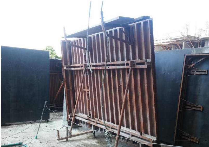
Ilustración 6. Módulos de formaleta Outinord usados en estructura túnel.
