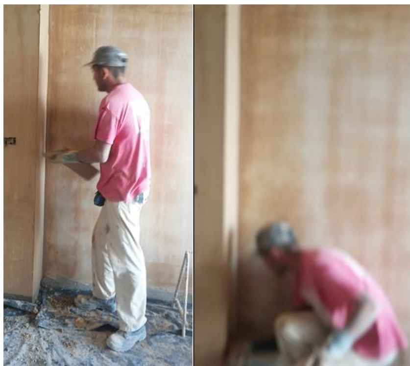
Ilustración 9. Estuco interior apartamentos.
