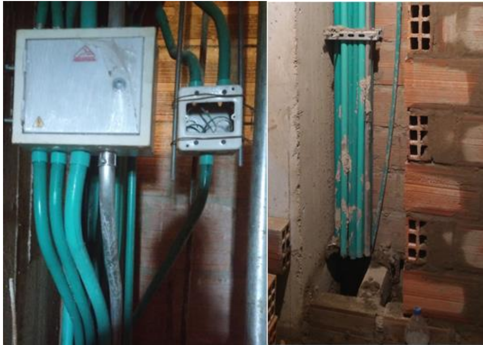
Ilustración 13. Bajante sistema atraparrayo.
