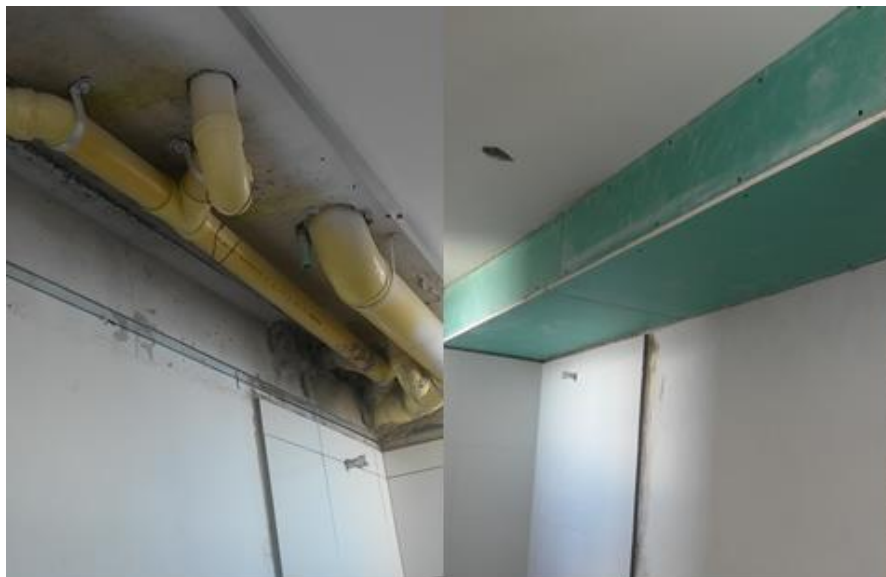
Ilustración 12.Cubierta - cielo raso baños.
