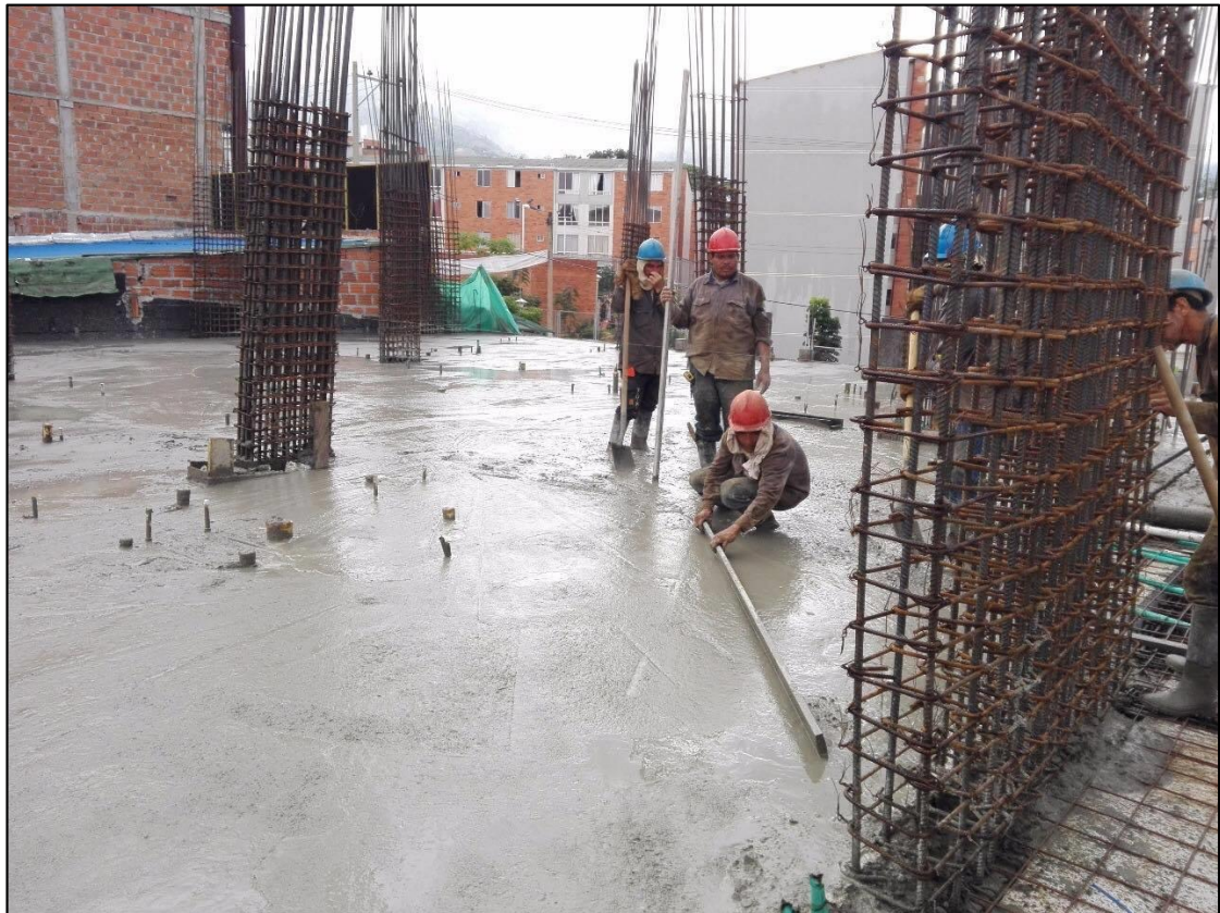
Figura 21. Nivelación de la placa
