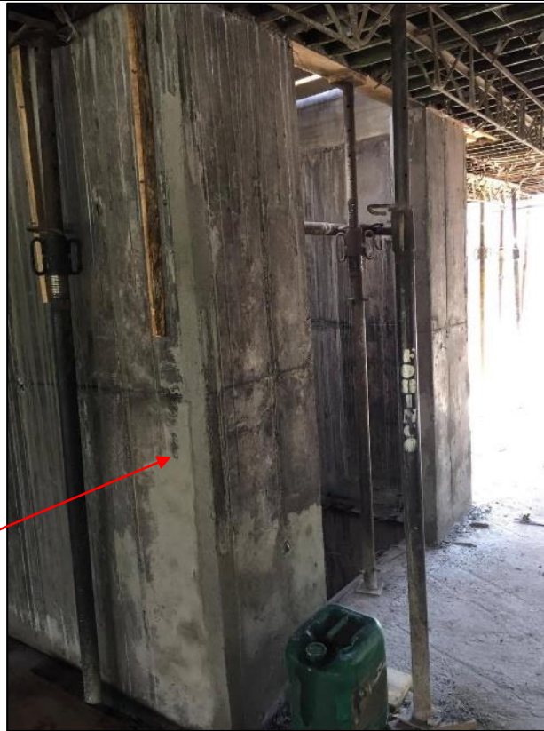
Figura 15. Mejoramiento de elementos verticales
