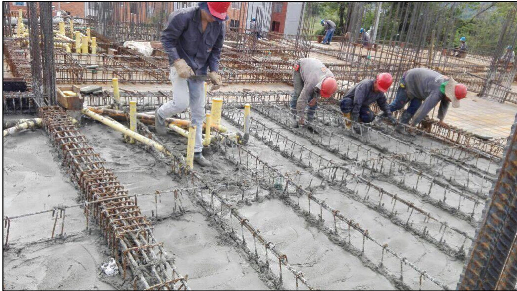
Figura 19. Armado de arañas
