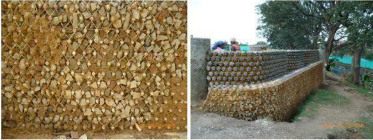
Ilustración 23 Fuente: (Casanova, 2011) Muros hechos con botellas
