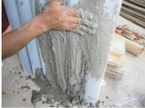
Ilustración 19 Fuente: (Cerón, 2013) Cobertura con mortero (paso 5) y pintada (paso 6)
