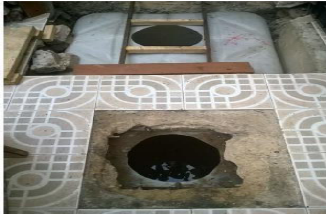
Ilustración 33 Fuente: (Salazar, 2016) Batería de tanques enterrados en el patio de la casa
