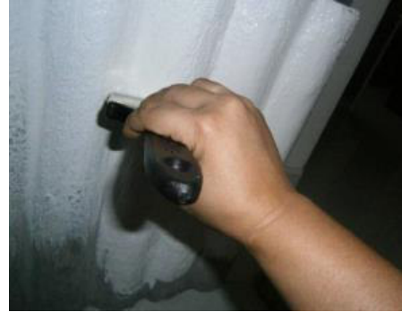
Ilustración 19 Fuente: (Cerón, 2013) Cobertura con mortero (paso 5) y pintada (paso 6)
