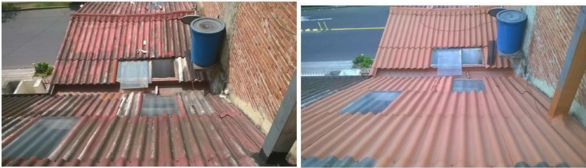
Ilustración 31 Fuente: (Salazar, 2016) Mantenimiento, limpieza y tratado de cubiertas y canales
