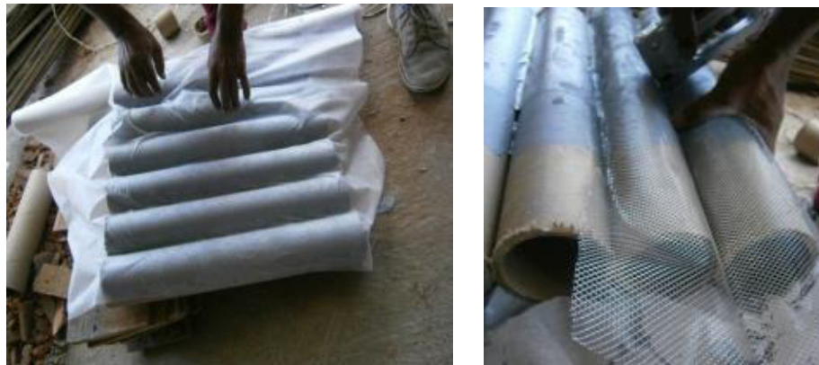
Fotografía 2 Fuente: (Cerón, 2013) Cobertura con tela (paso 3) y reforzamiento con malla (paso 4)
