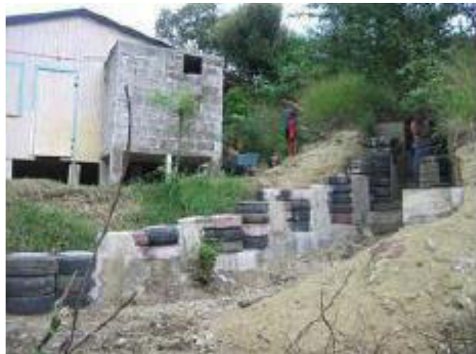
Ilustración 22 Fuente: (Casanova, 2011) Muros hechos con llantas
