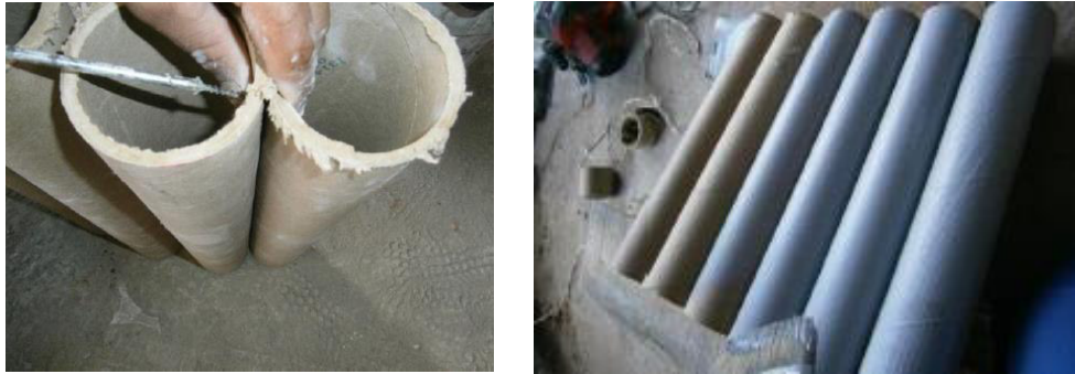
Fotografía 1 Fuente: (Cerón, 2013) Unión de tubos (paso 1) e impermeabilización de estos (paso 2)
