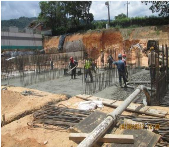
**Figura 49.** Fundida de placa de cimentación
