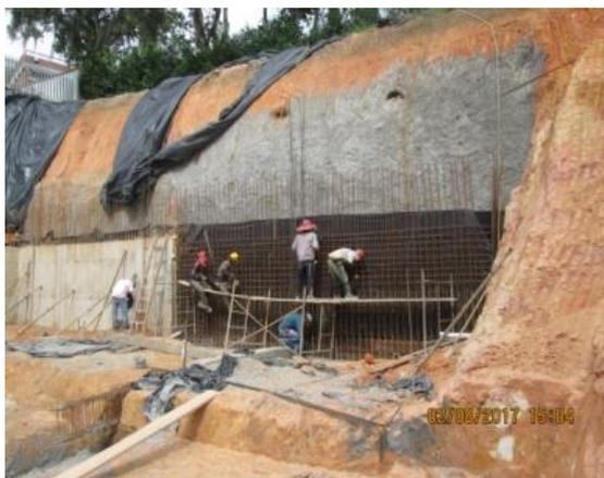
**Figura 60.** Armado de muro
