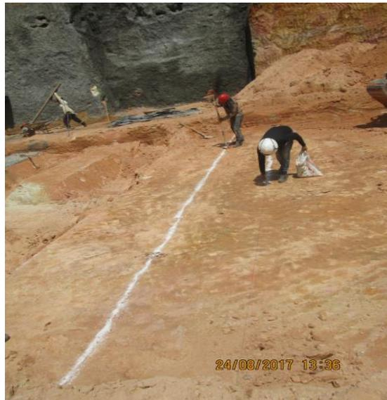
**Figura 41.** Localización de elementos en el terreno
