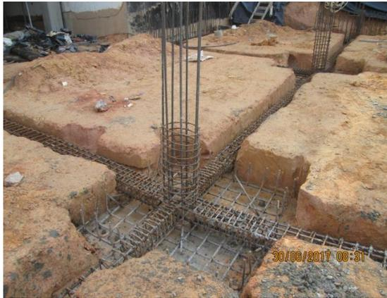
**Figura 46.** Armado de zapata
