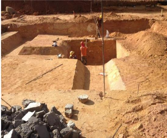
**Figura 42.** Excavación manual
