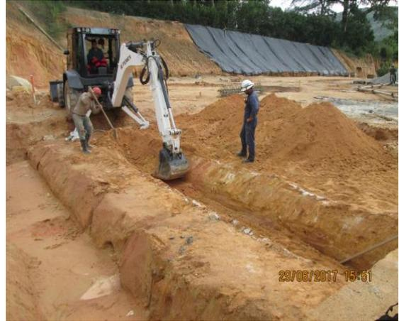
**Figura 43.** Excavación con retroexcavadora
