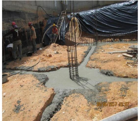
**Figura 50.** Fundida de zapata
