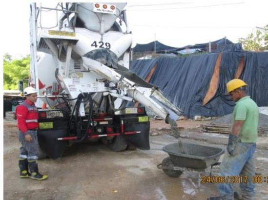
**Figura 5.** Toma de la muestra de concreto
