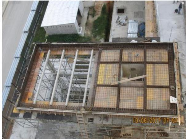
**Figura 69.** Instalación de perlines y malla de refuerzo
