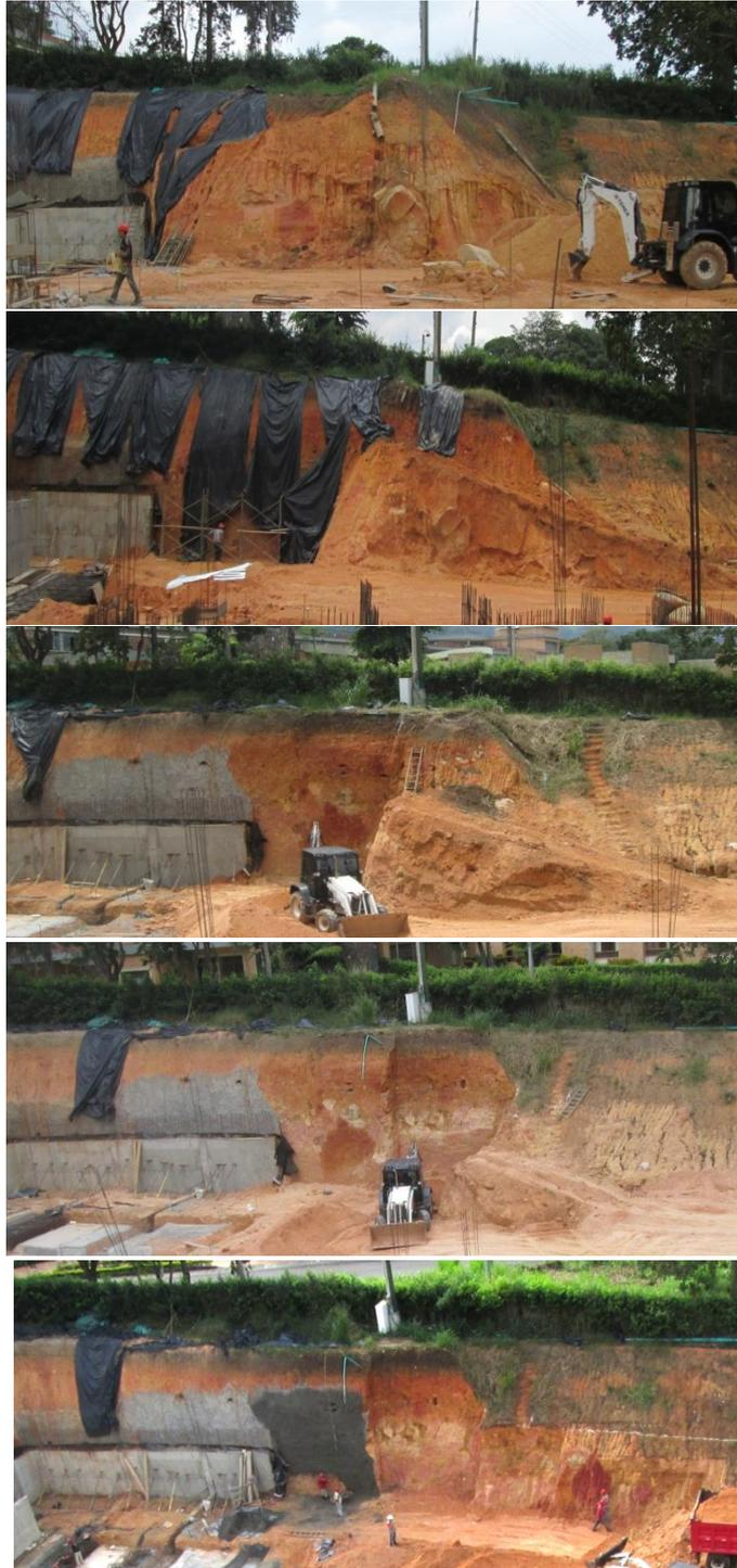
**Figura 52.** Secuencia corte de talud
