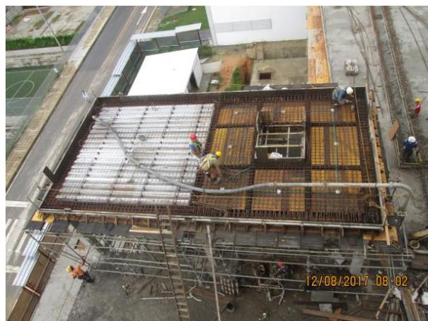
**Figura 70.** Instalación de lámina colaborante y redes eléctricas
