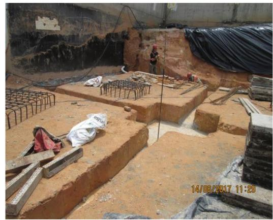
**Figura 45.** Solado sobre zapata
