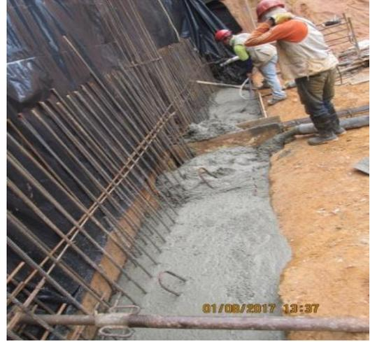
**Figura 59.** Fundida cimentación de muro
