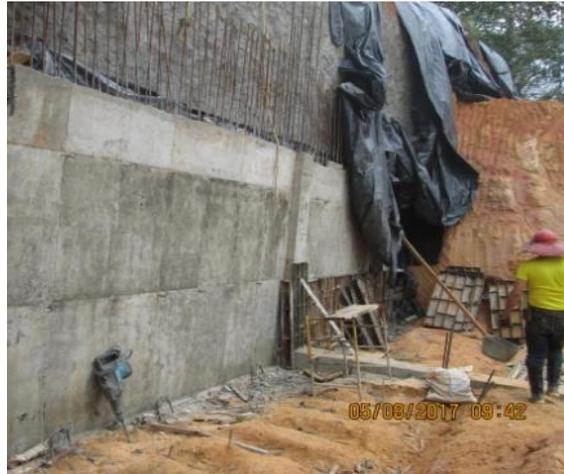
**Figura 62.** Elemento desencofrado
