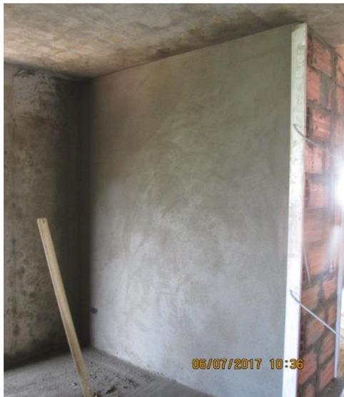
**Figura 79.** Pulida de muro
