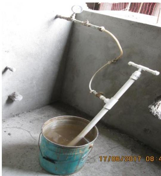
**Figura 13.** Presurización de la red hidráulica
