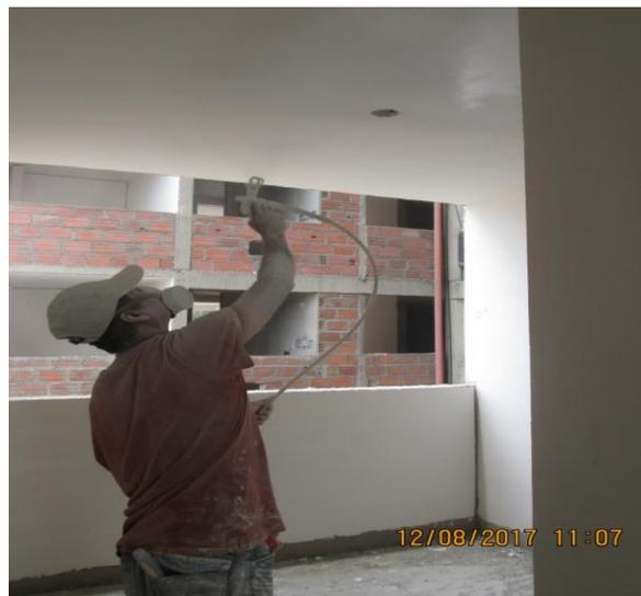
**Figura 82.** Aplicación de pintura con equipo de proyección
