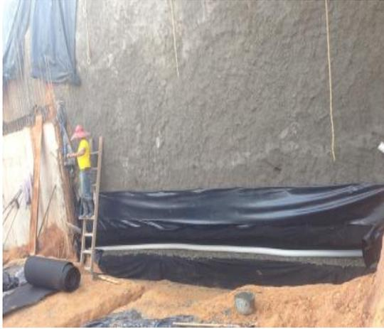
**Figura 54.** Instalación de drenaje
