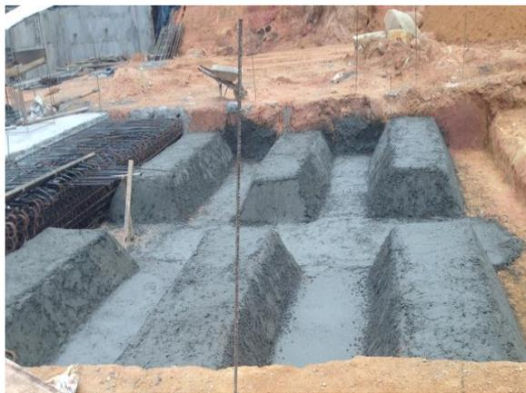
**Figura 44.** Solado sobre placa de cimentación
