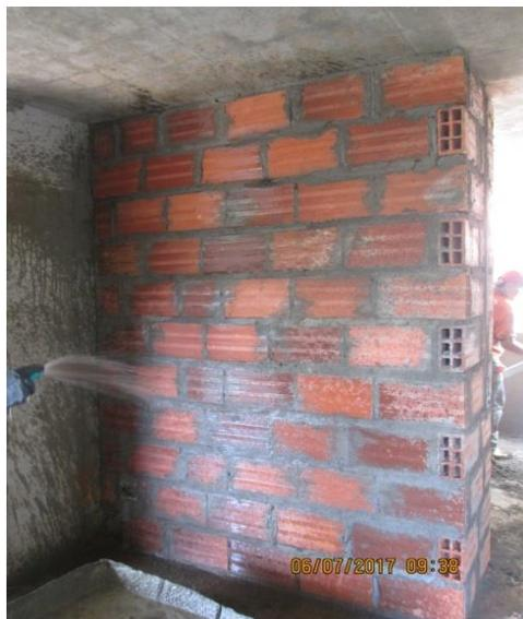
**Figura 75.** Humectación de muro
