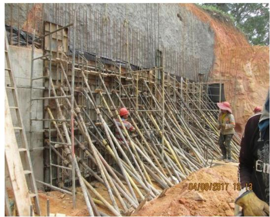
**Figura 61.** Encofrada y fundida de muro
