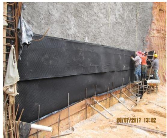
**Figura 57.** Instalación Geodren Planar
