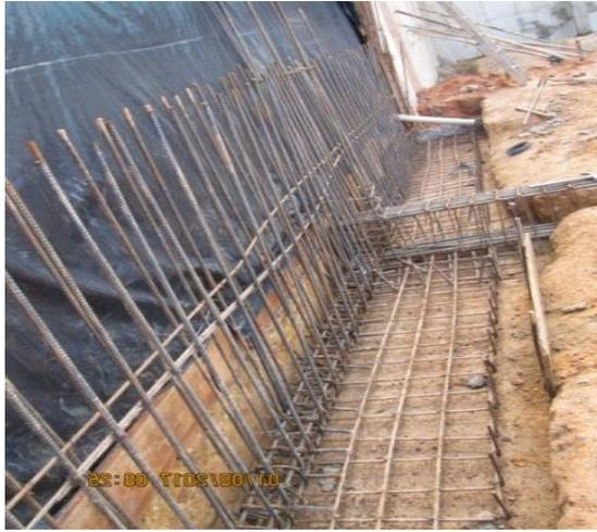
**Figura 58.** Armado cimentación de muro
