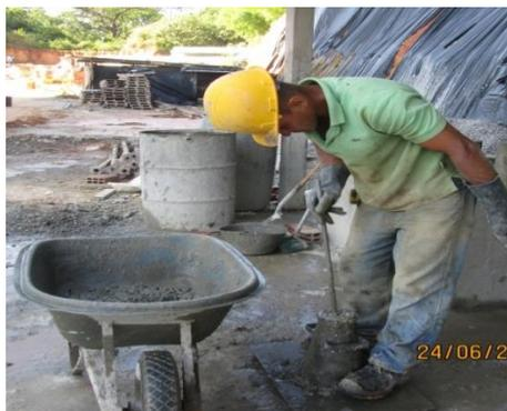
**Figura 6.** Apisonamiento del concreto
