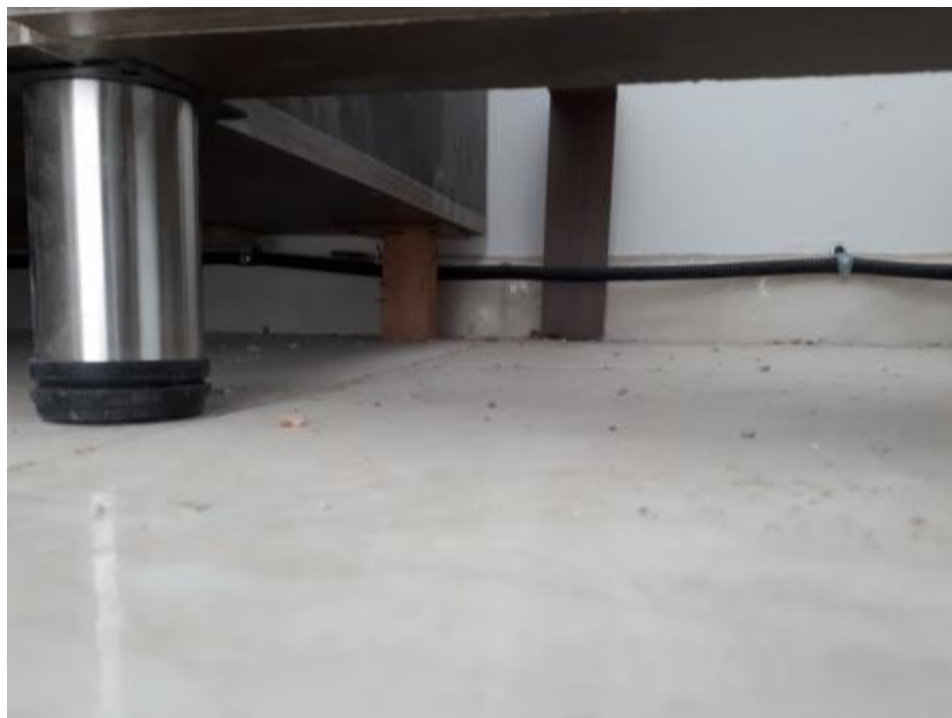
Figura 17. Soporte de Madera en Mueble de Cocina
