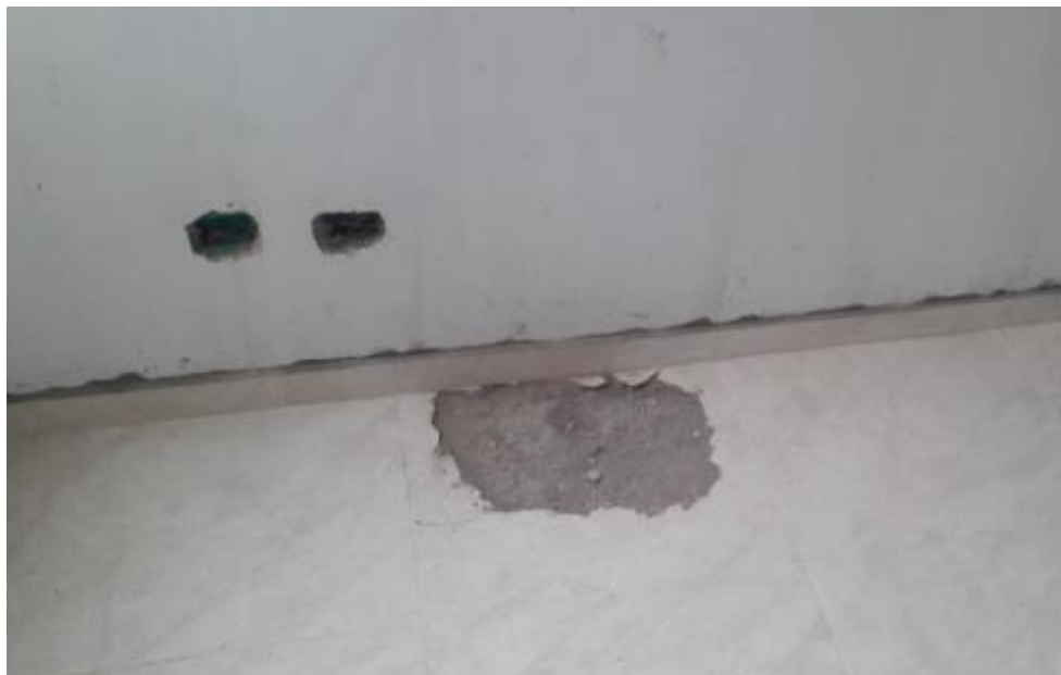
Figura 19. Levantamiento de cerámica suelta.
