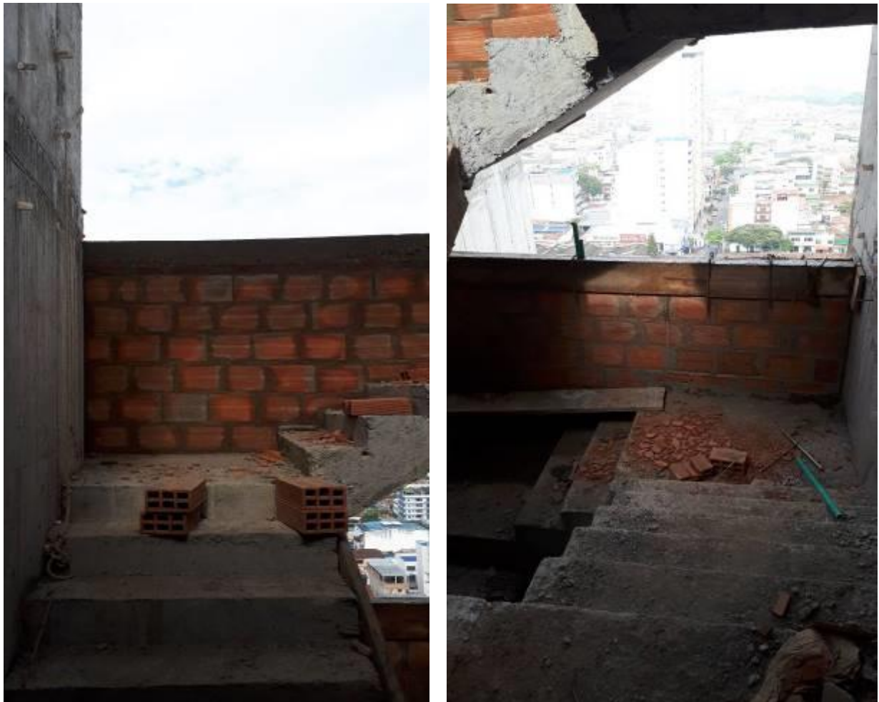
Figura 4. Vigas de confinamiento en Mampostería de escaleras de emergencia
