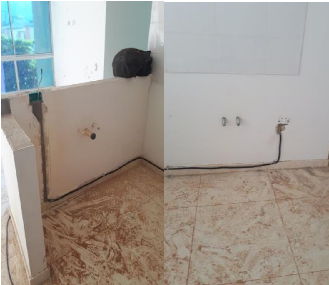
Figura 31. Instalación del nuevo toma eléctrico.
