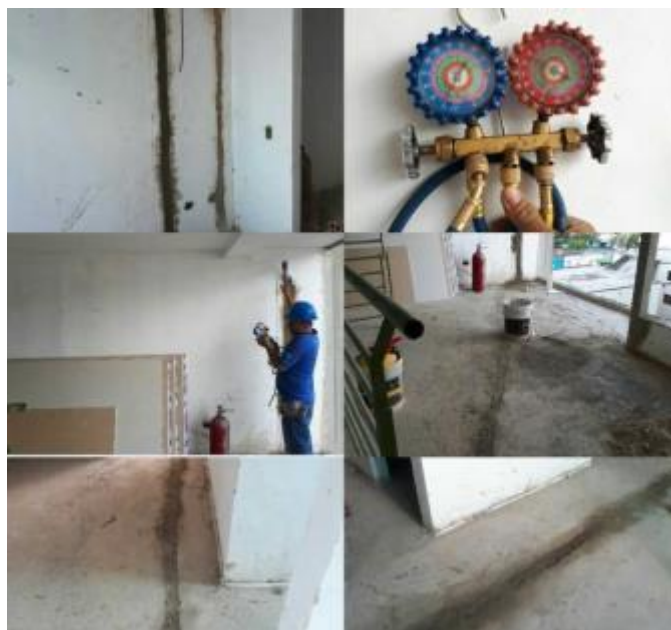
Figura 44. Instalación Aire Acondicionado Apartamento 2003
