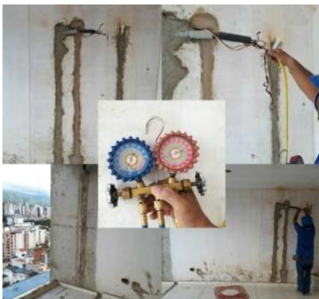
Figura 45. Instalación Aire Acondicionado Apartamento 904
