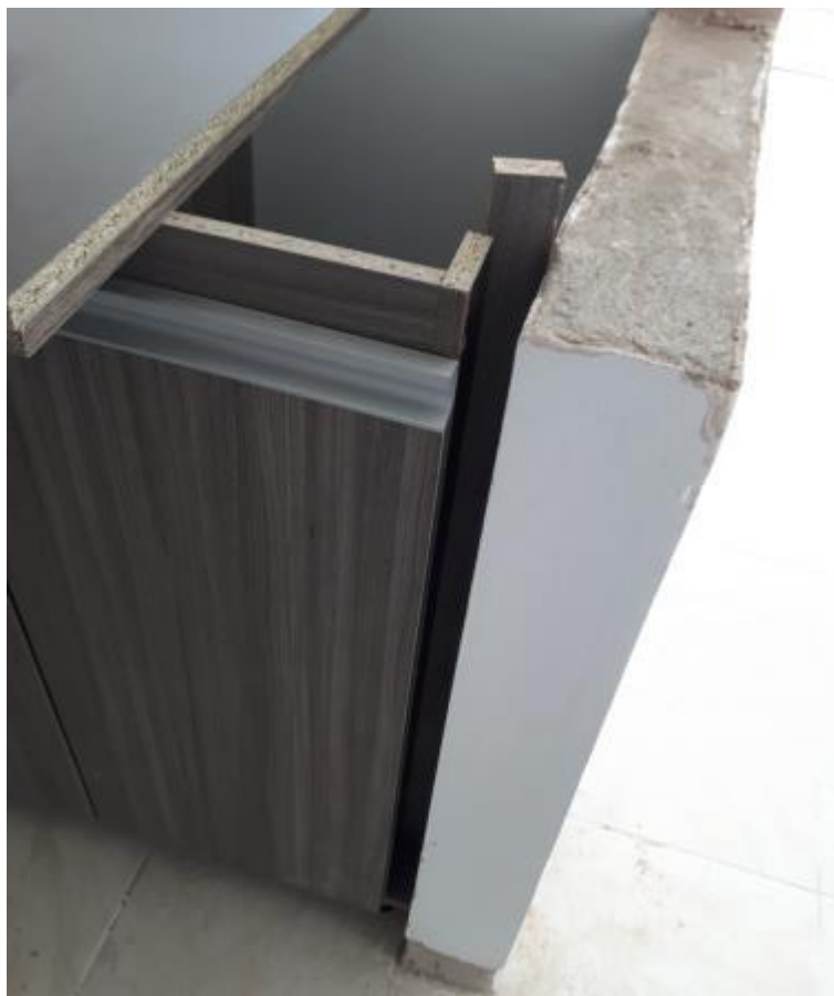
Figura 16. Suplemento en Madera Instalado en Mueble de Cocina
