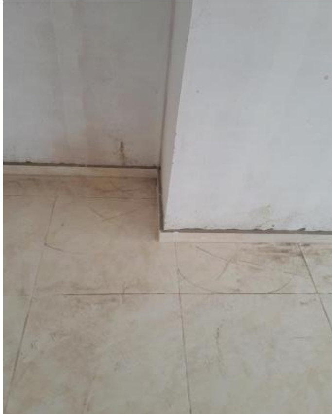
Figura 19. Levantamiento de cerámica suelta.
