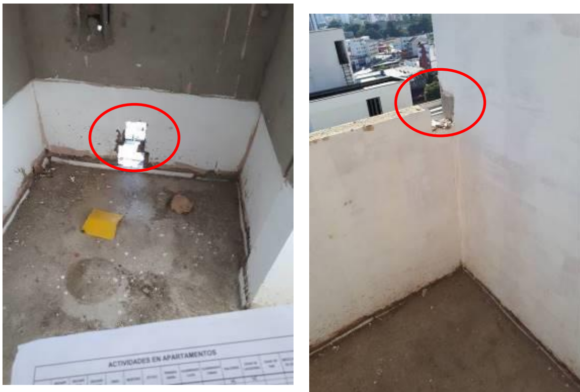
Figura 7. Resanes en los sitios donde se ubican los elementos de Protección
