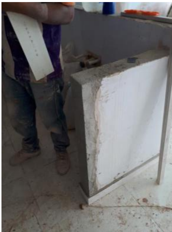
Figura 27. Reproceso Muro Cocina
