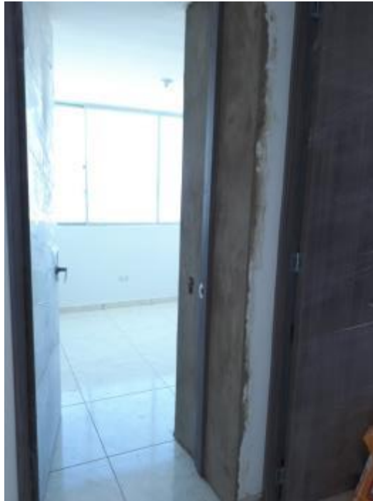
Figura 39. Refriso de Mampostería
