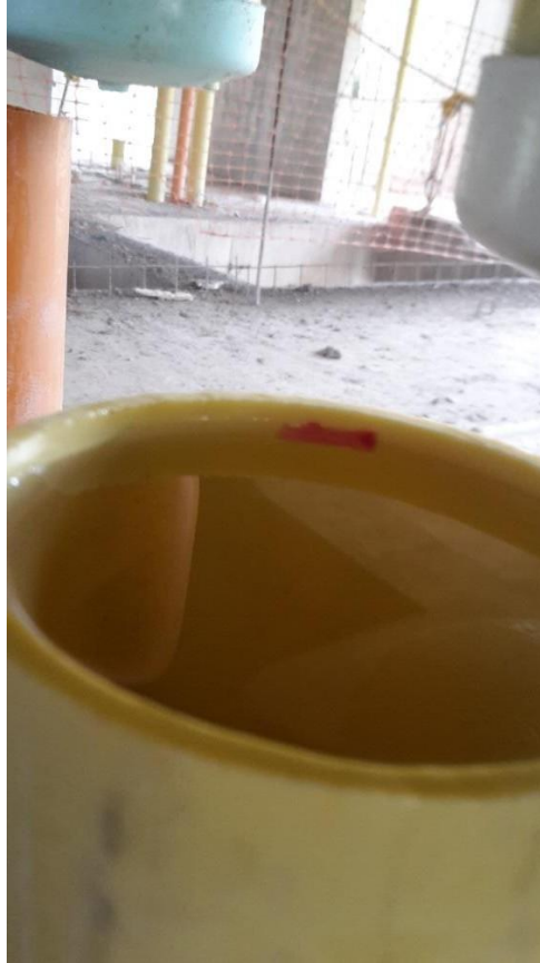
Imagen 10: tubería en proceso de prueba de estanqueidad
