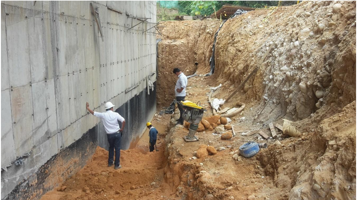
Imagen 11: Inicio de trabajos de rellenos en el costado oriental de la Torre 3.
