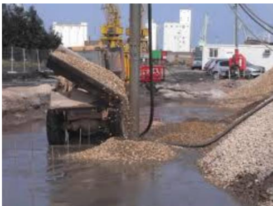
Figura 8: Método constructivo de las columnas de grava.
