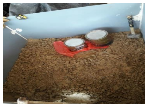
Figura 25: Proceso de compactación del estrato de arcilla y construcción de la columna de grava.
