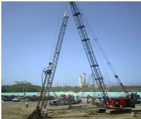
Figura 10: Construcción de las columnas de grava en buenaventur. Figura 11: Columnas de grava construidas en buenaventura.
