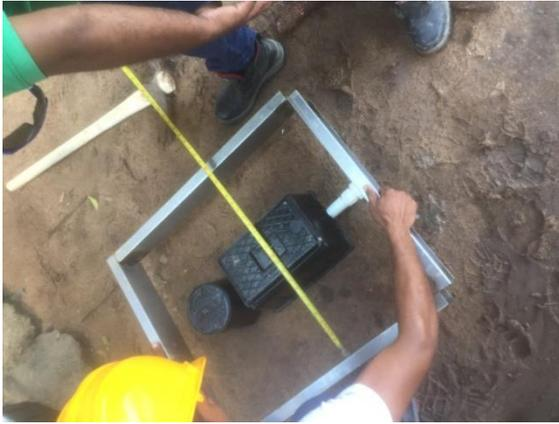
Figura 5. Instalación de formaleta para micro medidor.
