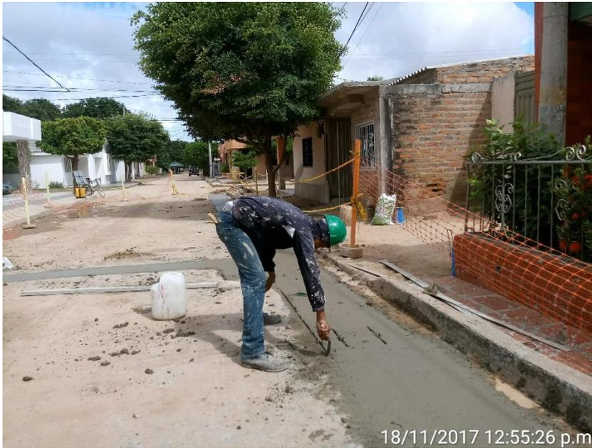
Figura 22. Preparación de dilatación y añadidura de barras de acero para evitar fracturas
