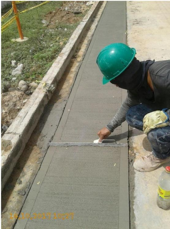
Figura 24. Fraguado, dilatación y detalles luego de fundir.
