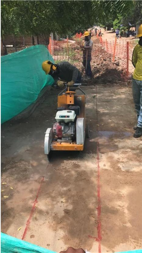
Figura 8. Corte de pavimento
