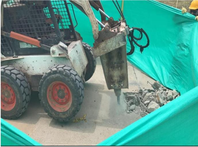
Figura 11. Mini cargador demoliendo.
