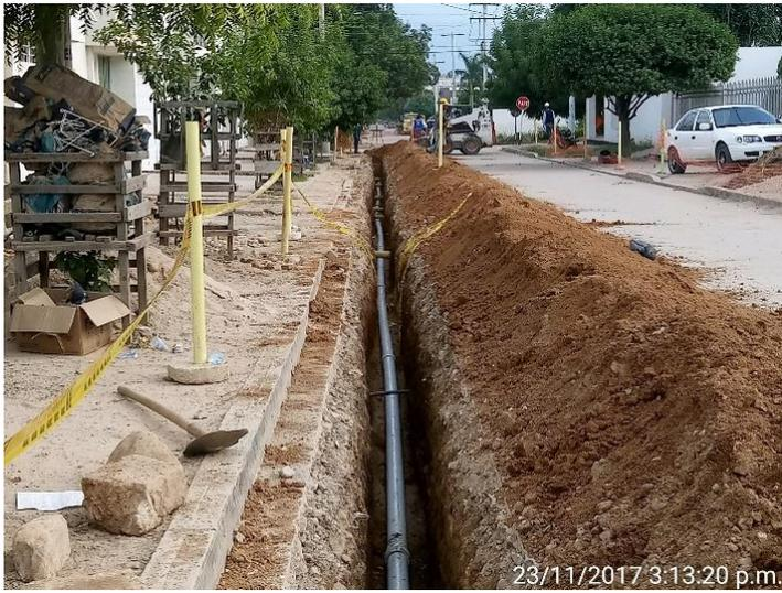
Figura 16. Instalación de tubería de 4"
