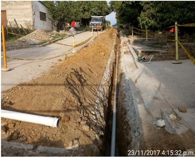
Figura 15. Instalación de tubería de 3"
