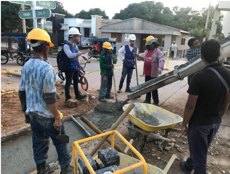
Figura 23. Fundición de concreto.
