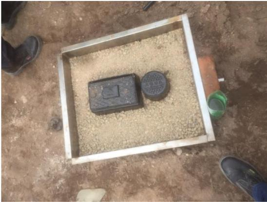
Figura 6. Añadidura de triturado y arena, y compactación manual para fundir.
