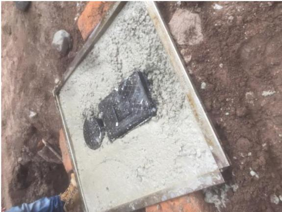
Figuras 7. Fundición de concreto de 3000 PSI en micro medidor.
