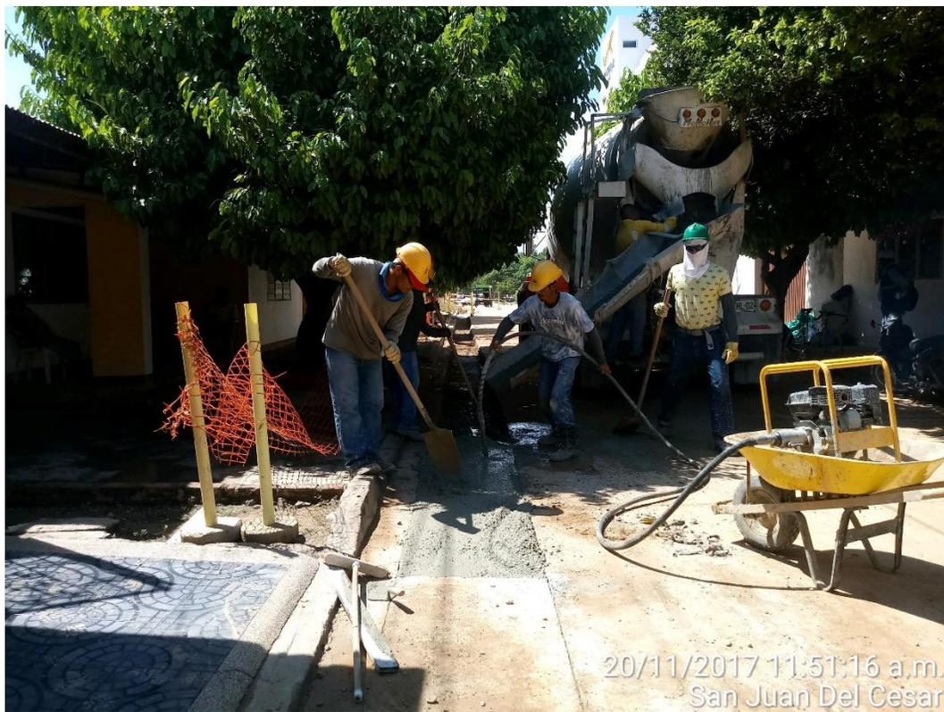
Figura 21. Fundición de concreto y vibración.
