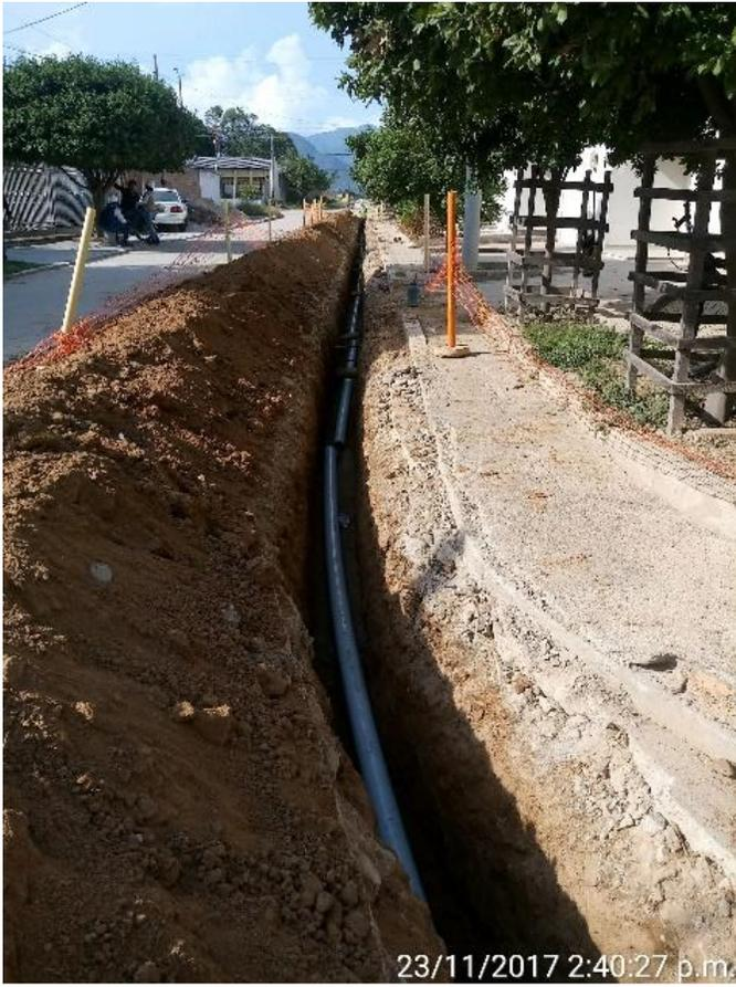
Figura 17. Instalación de tubería de 4"
