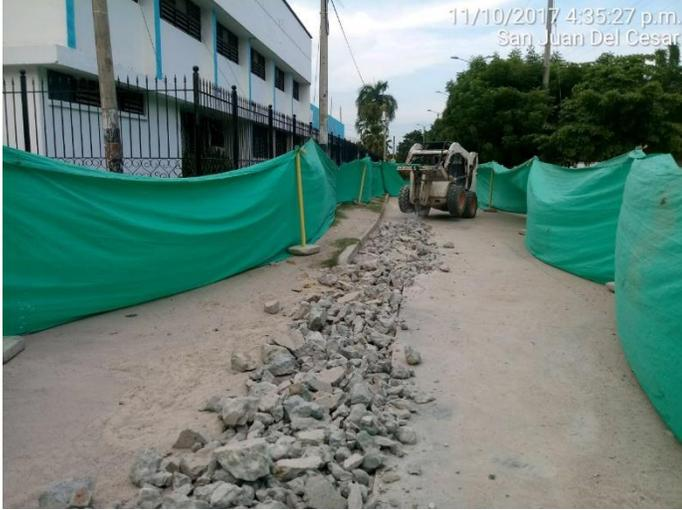
Figuras 9, 10. Demolición de pavimento.
