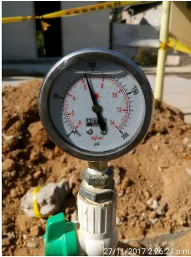
Figura 3. Prueba de presión hidrostática a 90 PSI.
