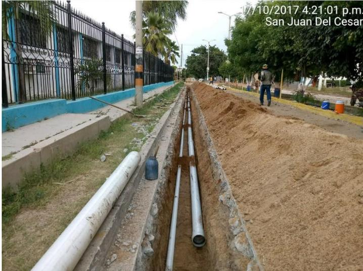
Figuras 13, 14. Instalación de doble tubería (6" y 3")
