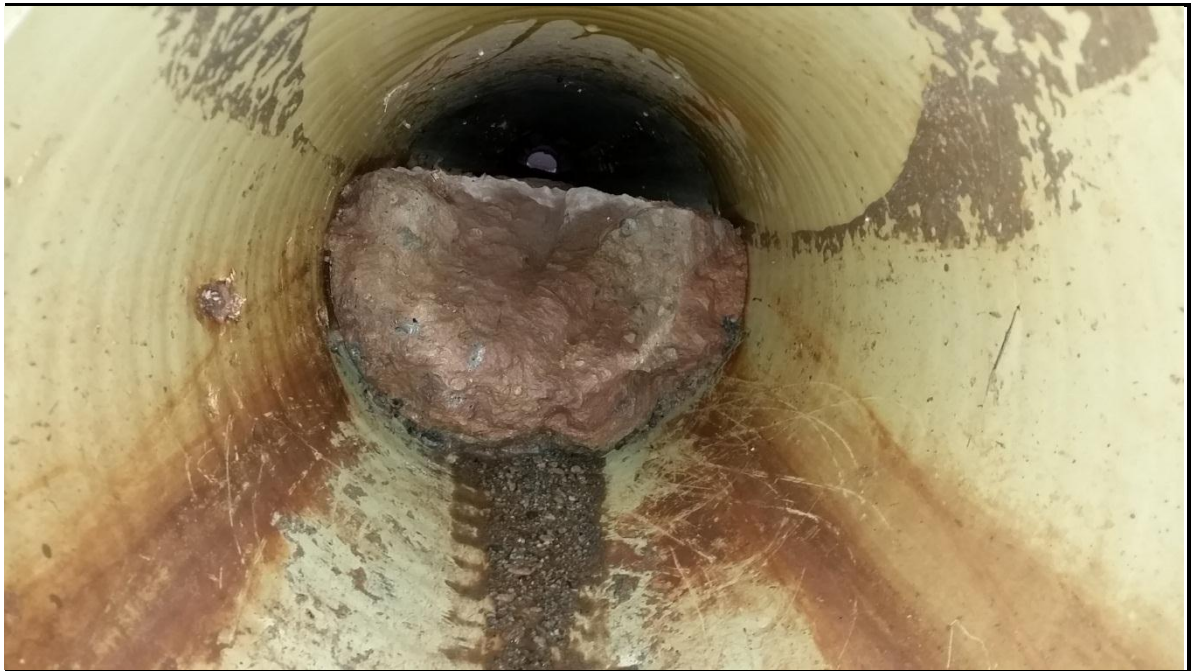
Imagen 28 Taponamiento red de agua residuales.
