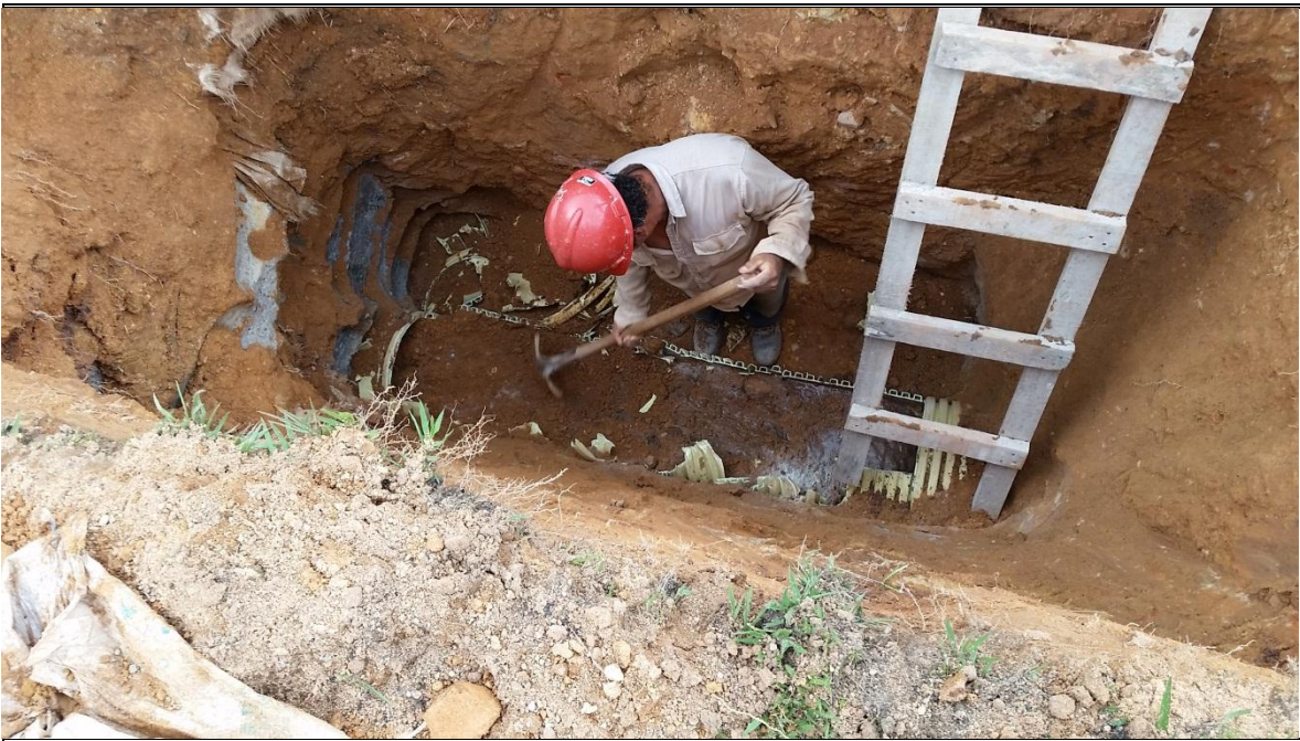
Imagen 30 Demolición de tubería de la red de alcantarillado.
