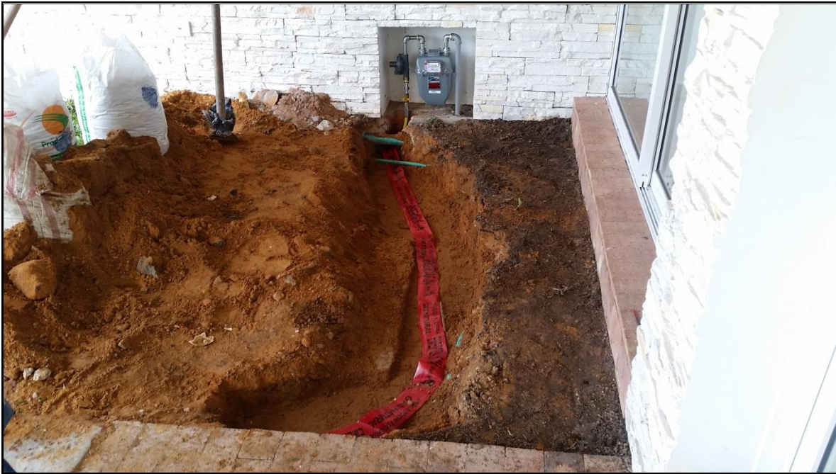
Imagen 38 . Sistema de señalización de tubería de gas a 20 cm de los suelos del jardín
