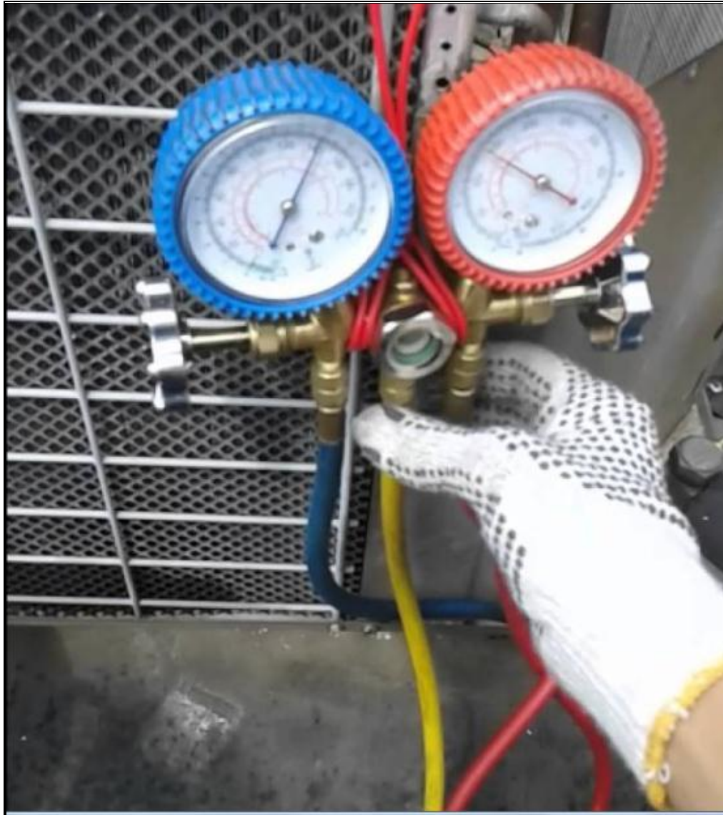
Imagen 15 Inicio de prueba de presión en casa 27.
