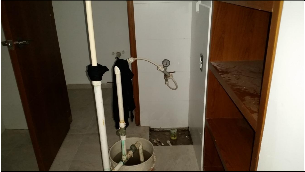
Imagen 11 Montaje de prueba de presión hidrostática
