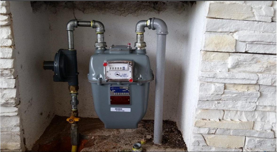
Imagen 39 Instalación de medidor finalizada
