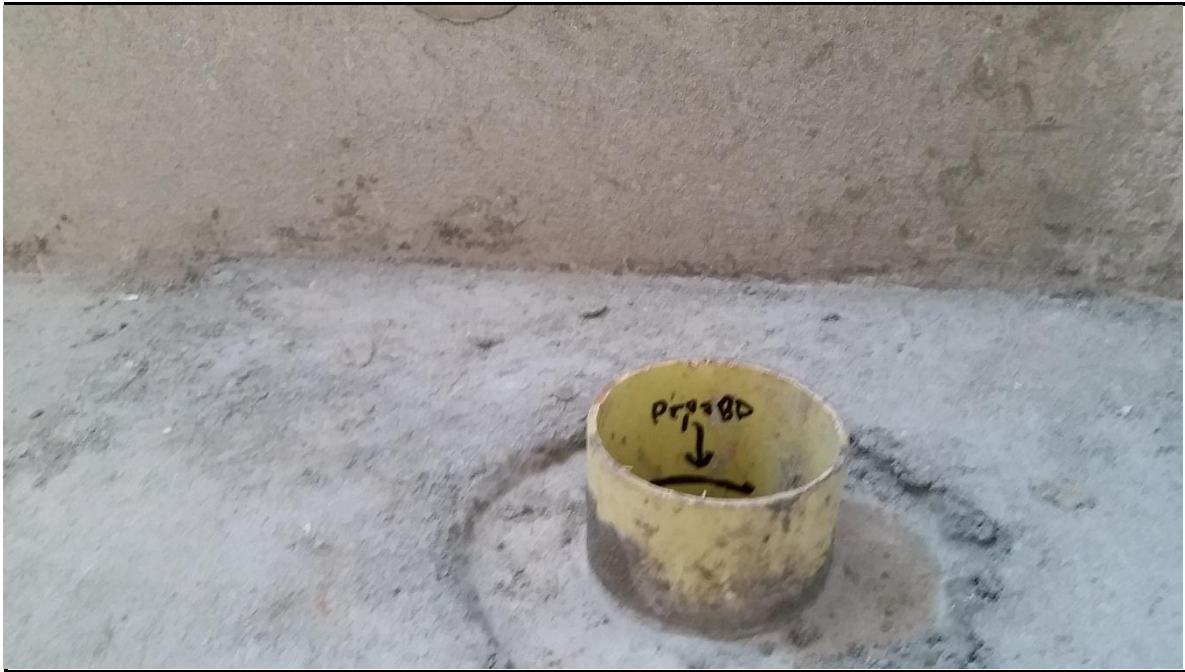
Imagen 7 Prueba de estanqueidad- Nivel de llenado inicial.
