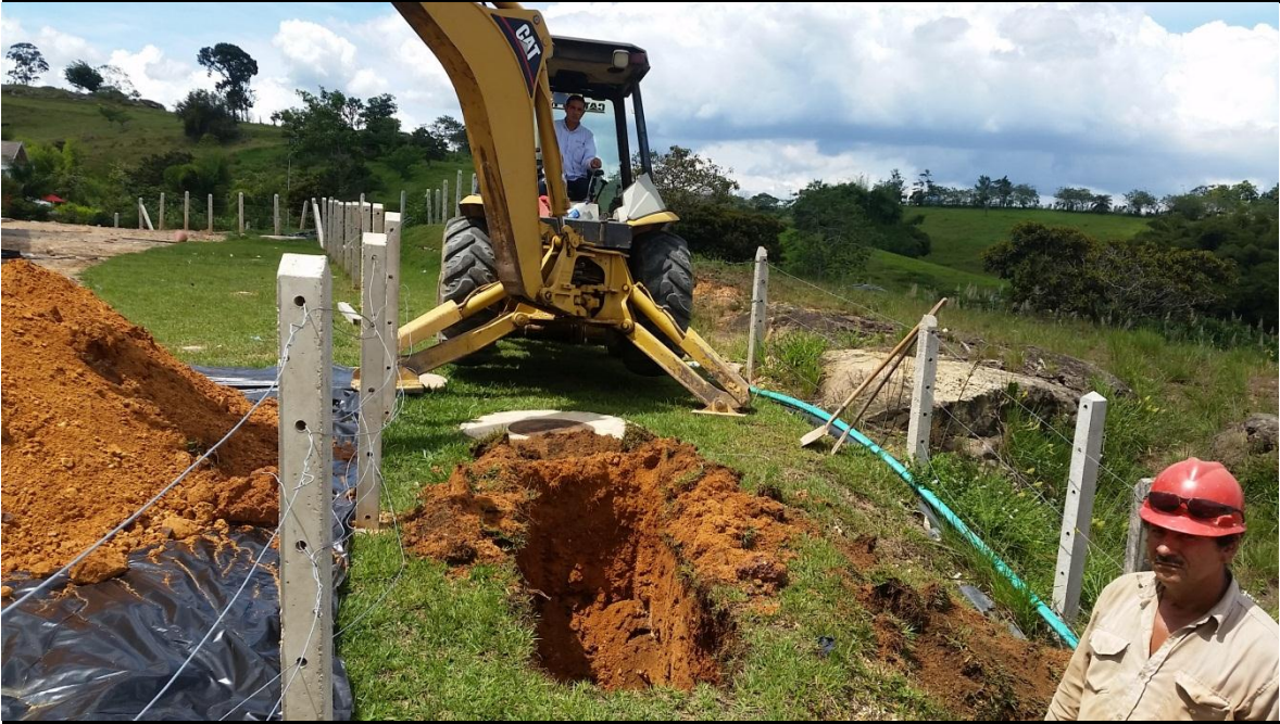
Imagen 29 Excavación red de alcantarillado costado norte.
