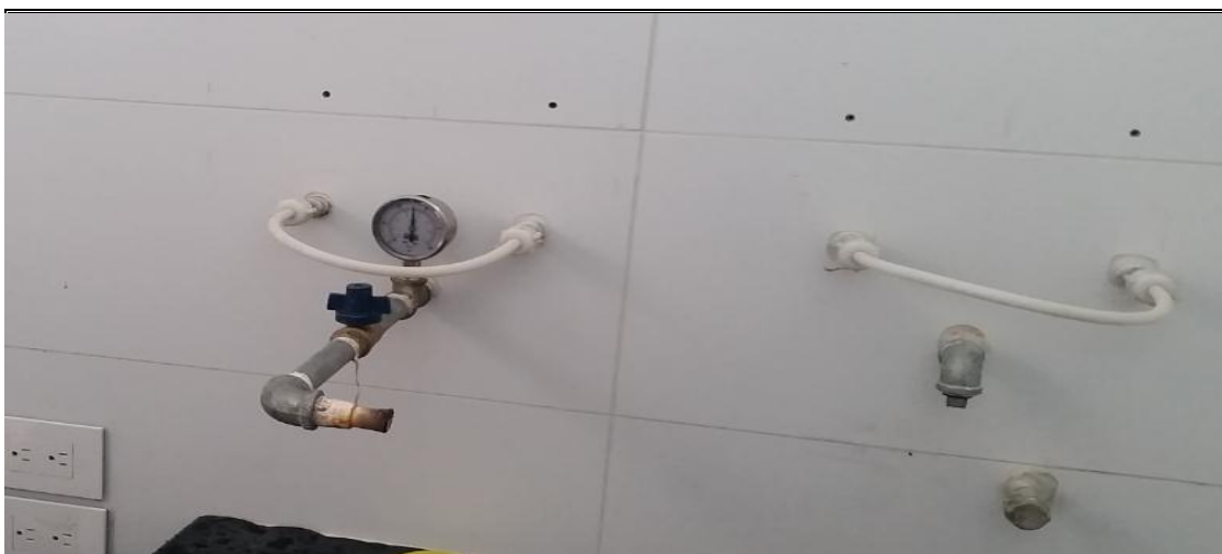
Imagen 10 Conexión y prueba de presión con red de agua fría y caliente.
