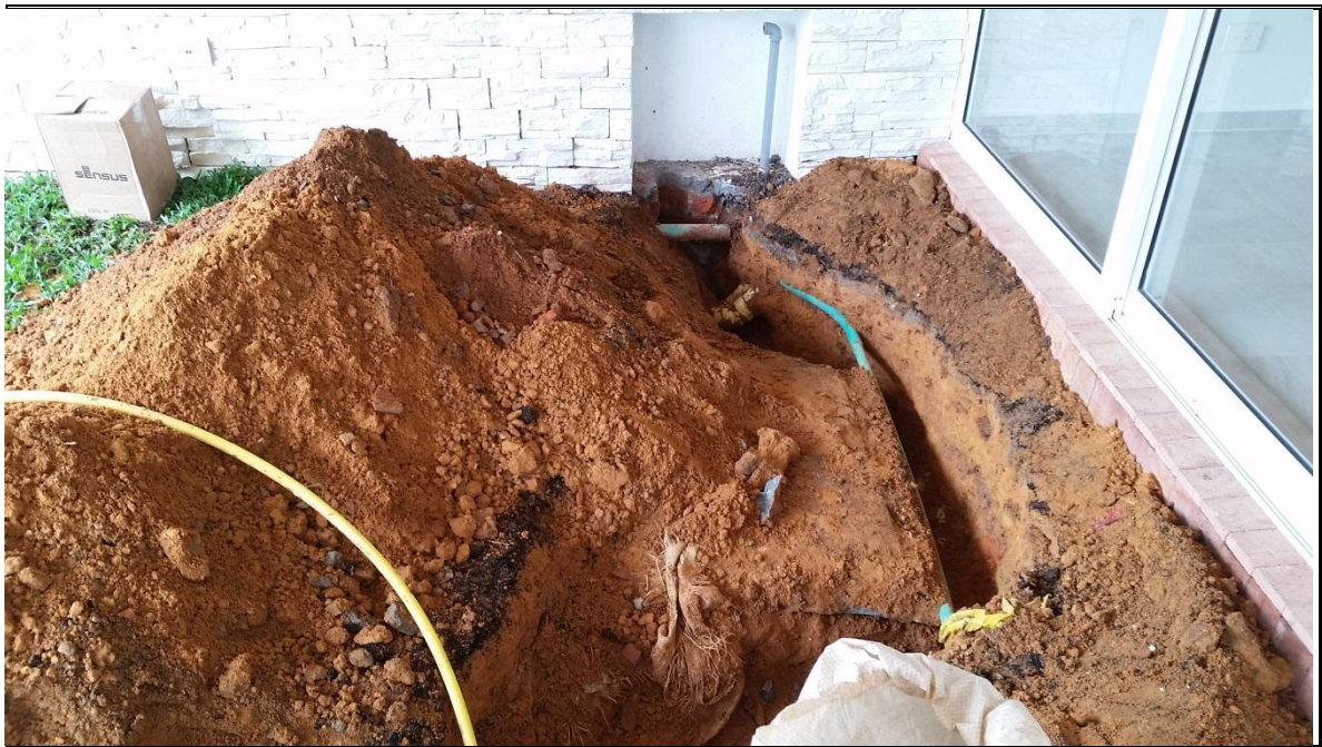
Imagen 37 Excavación para orientación de tubería de polipropileno.
