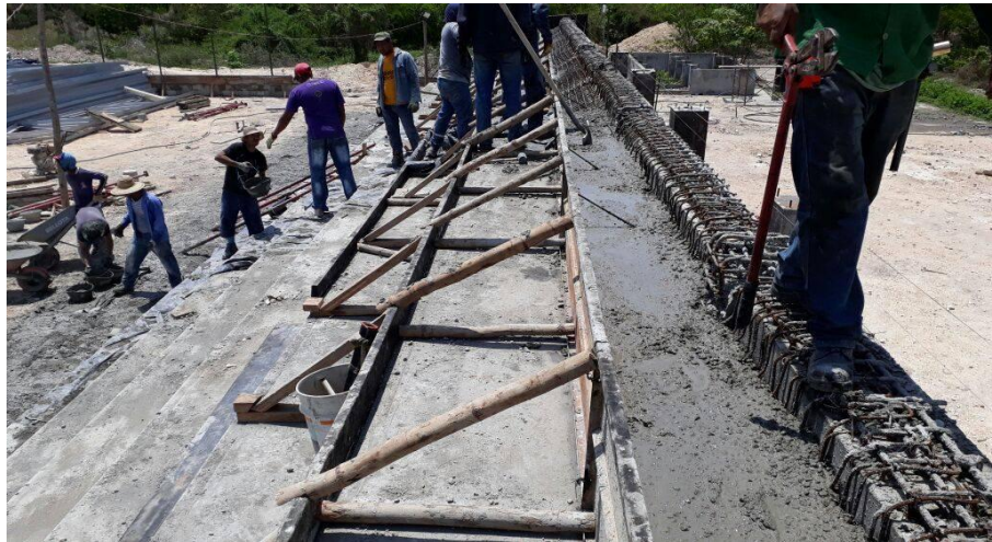
FIGURA 4 VACIADO DE CONCRETO
