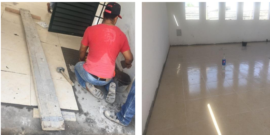
Imagen 32: Instalación Cerámica para piso.
