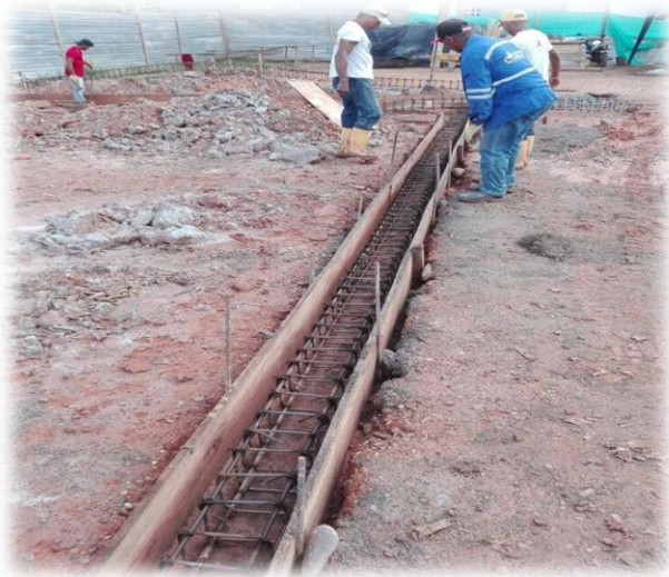
Imagen 14: Acero de refuerzo.
