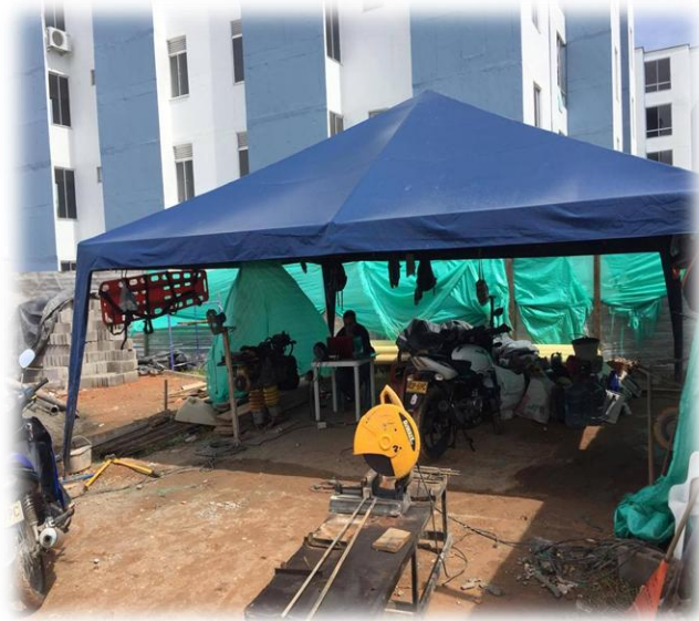
Imagen 12: Campamento E instalaciones Provisionales.
