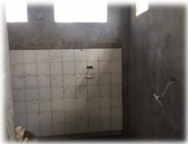
Imagen 29: Instalación Enchape Cerámico.
