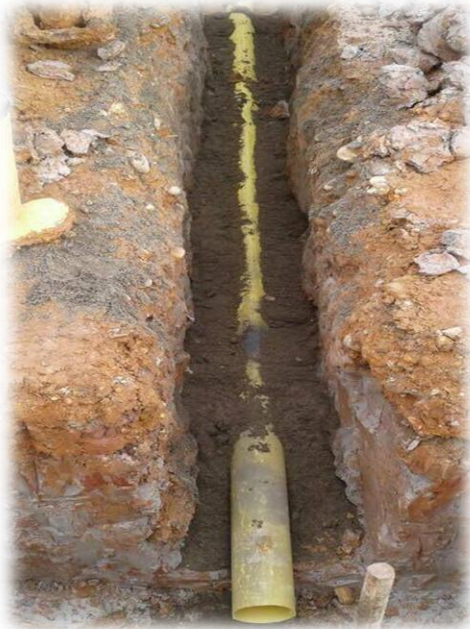
Imagen 16: Instalación Tubería PVC.
