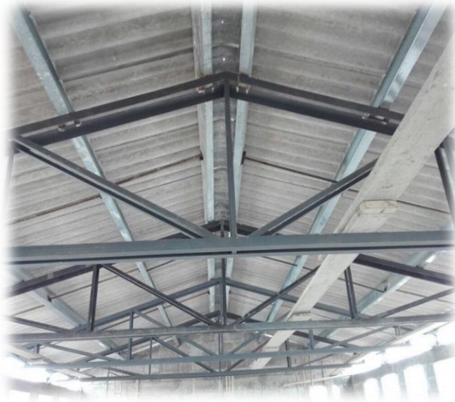
Imagen 23: Tejas en fibrocemento.
