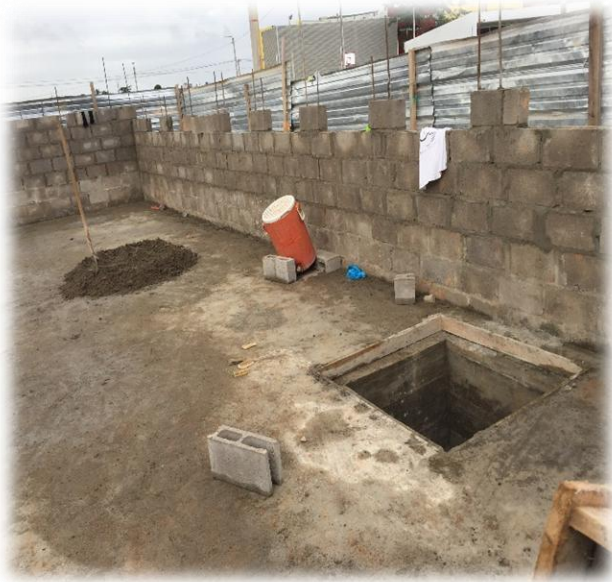
Imagen 19: Muros en mampostería de concreto.
