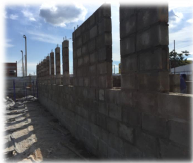
Imagen 8: Registro fotográfico salón comunal.
