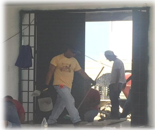
Imagen 31: Instalación Puerta Principal.
