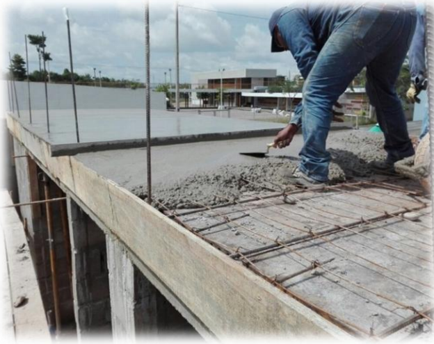
Imagen 21: Losa maciza de cubierta.
