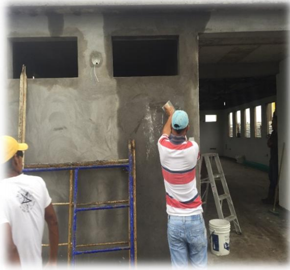
Imagen 25: Pañete Para Muros.
