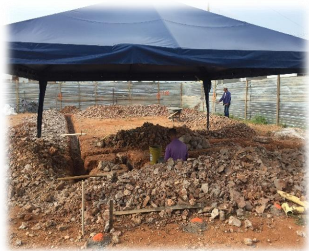
Imagen 13: Excavación Manual de material heterogéneo.
