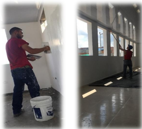
Imagen 28: Estuco y pintura.
