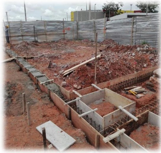
Imagen 15: Viga de fundación.
