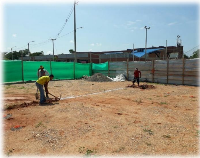
Imagen 10: Localización Y Replanteo del proyecto.
