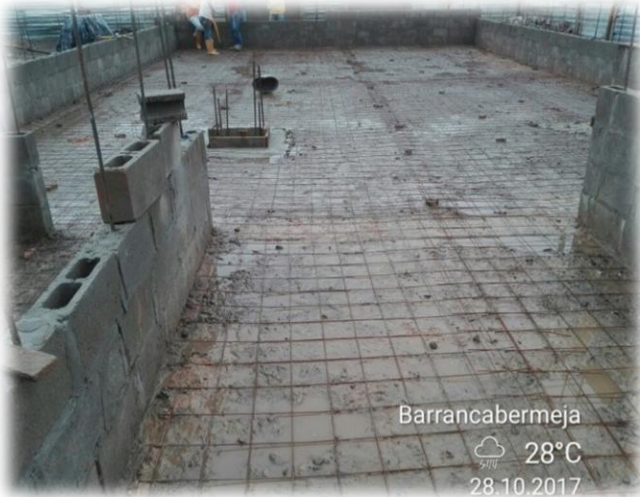
Imagen 17: Malla electrosoldada.
