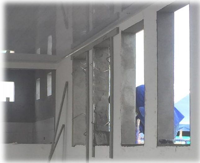
Imagen 30: Relleno para instalar ventanas.
