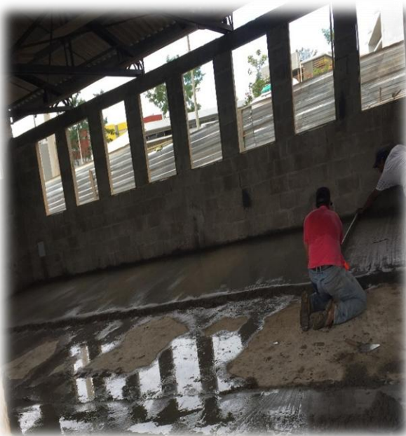
Imagen 24: Mortero nivelación.
