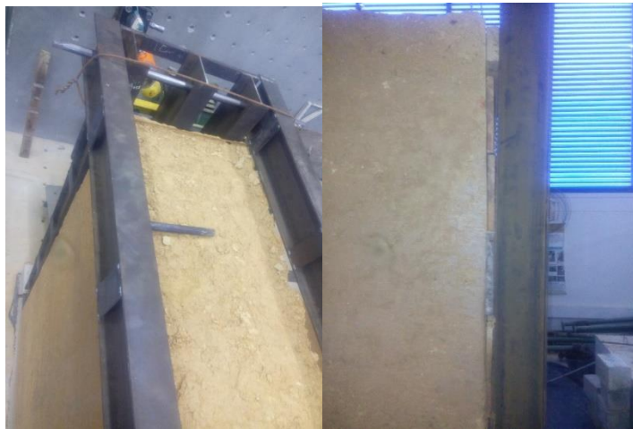
Figura 71. Amarre de vigas superiores y maderas de contacto.
