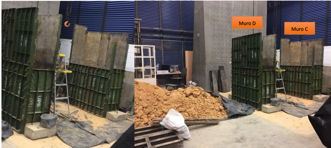
Figura 64. Montaje del encofrado muro C y D.
