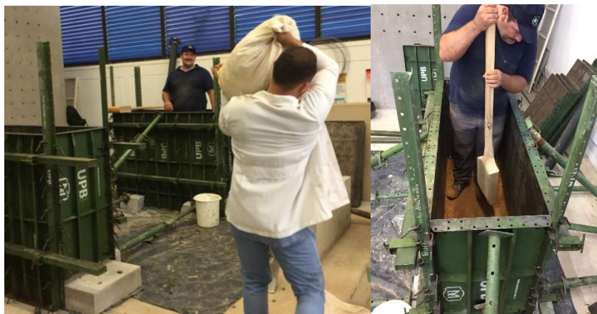
Figura 58 . Construcción del muro A.
