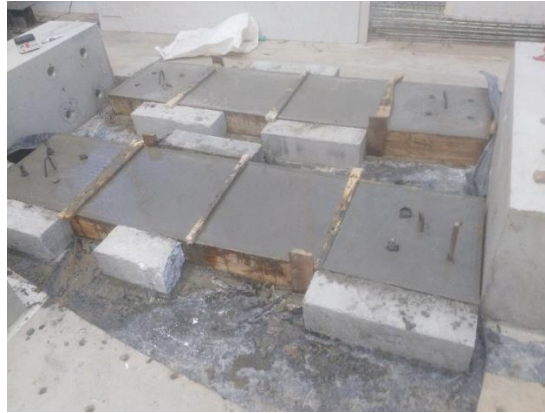
Figura 44. Fundición de vigas de cimentación.
