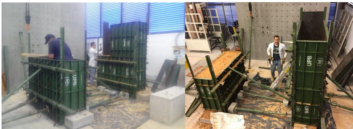
Figura 59. Armado de formaleta y construcción simultanea del Muro A y Muro B.
