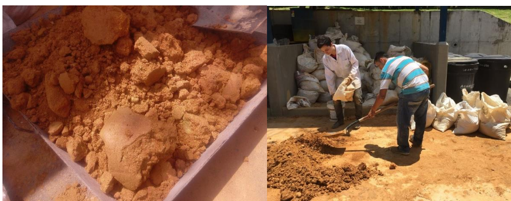
Figura 56 . Preparación del material para la construcción de muros A y B.
