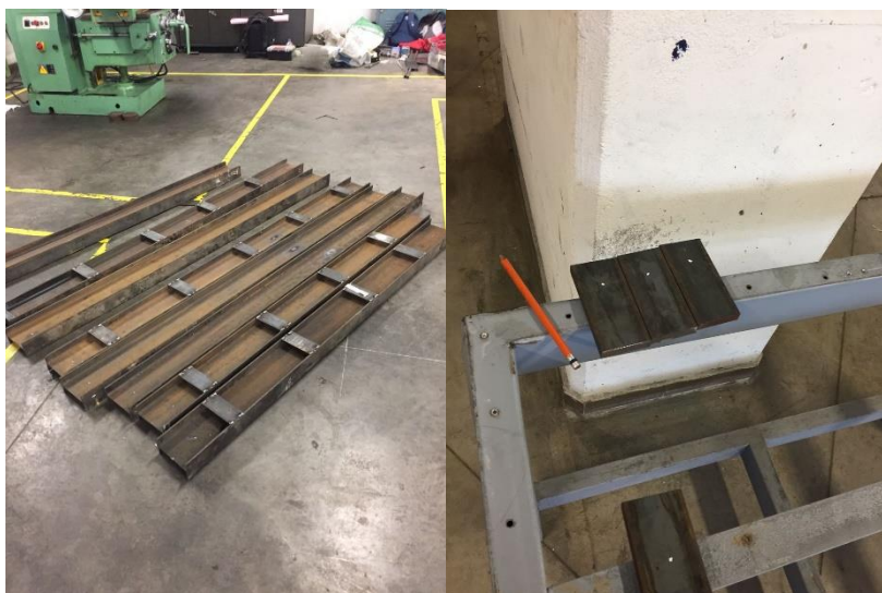
Figura 51. Materiales para la construcción del marco articulado.
