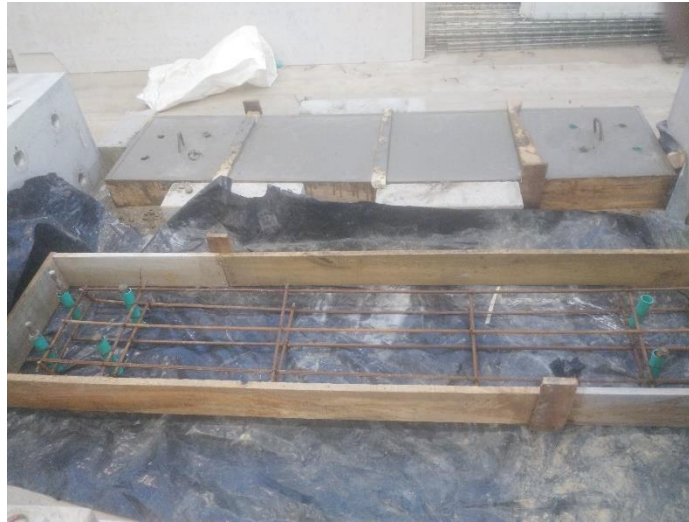
Figura 43. Proceso constructivo de viga de cimentación.
