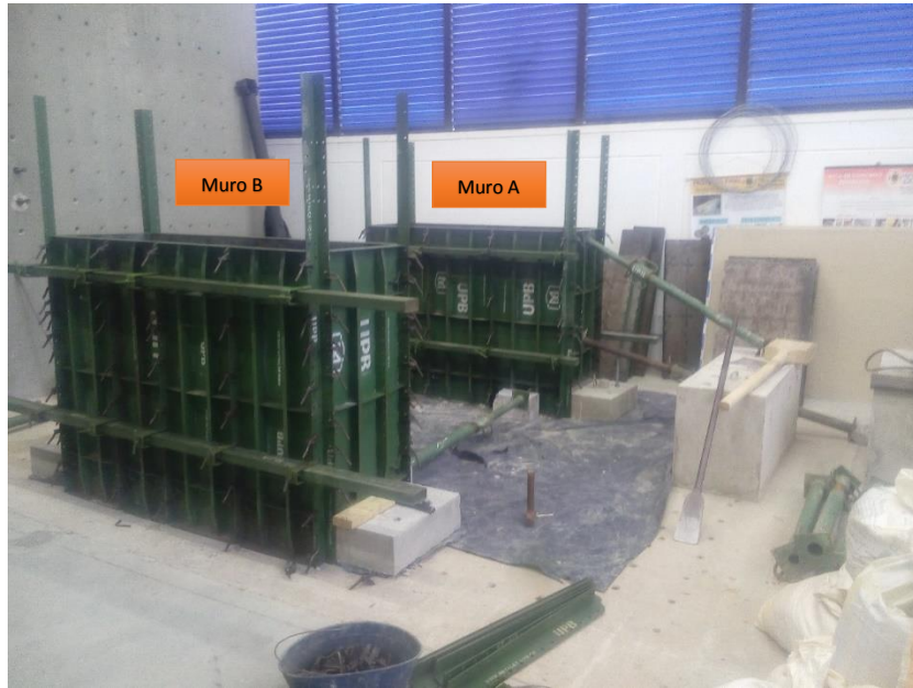
Figura 54. Primer metro de encofrado muro A y B.
