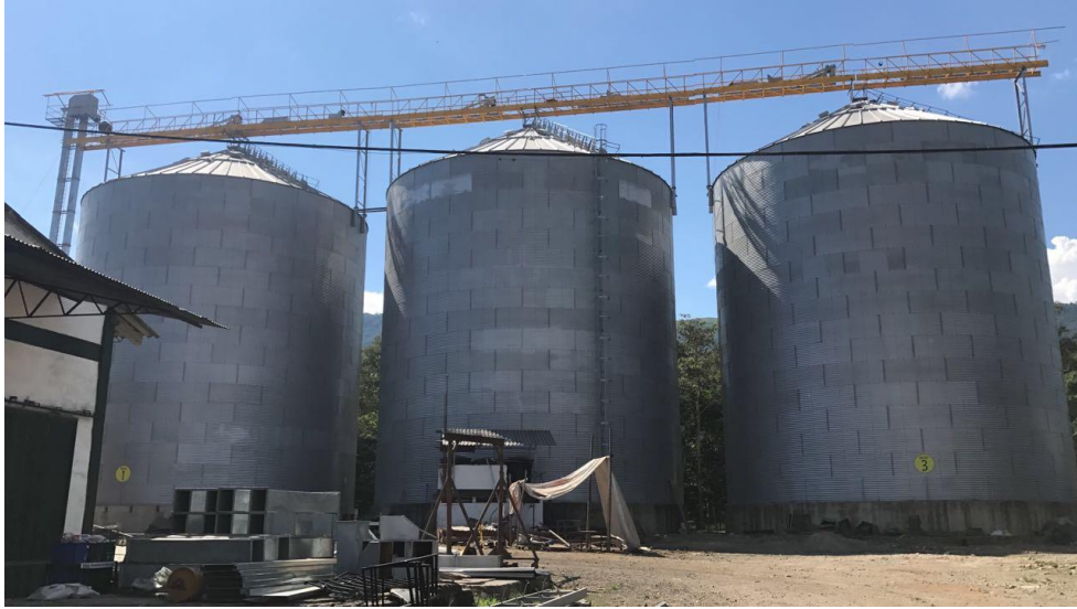
Figura No. 38: Silo 1, 2, 3 terminados.
