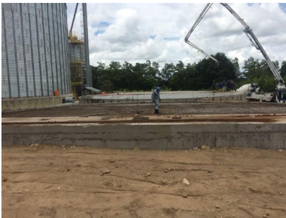
Figura No.48. : Disposición de material
