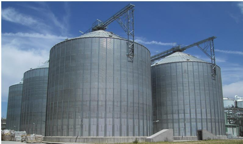
Figura No.10: Silos de fondo plano Fuente: http://pradosilos.com
