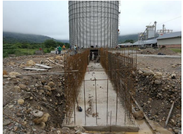
Figura No.47 : Construcción túnel de descarga
