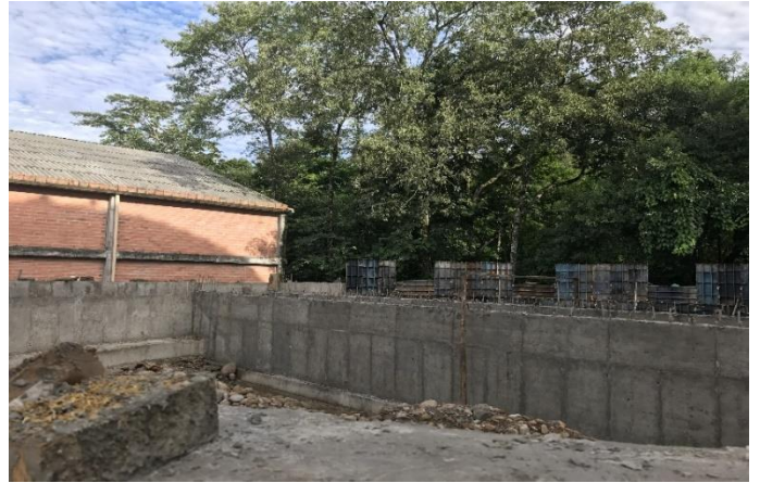
Figura No.26: Vista después del retiro de formaleta
