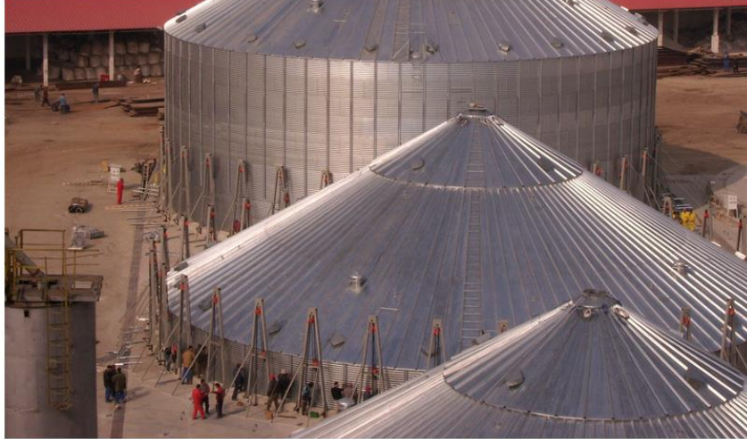
Figura No.9: Silos de fondo plano Fuente: http://pradosilos.com
