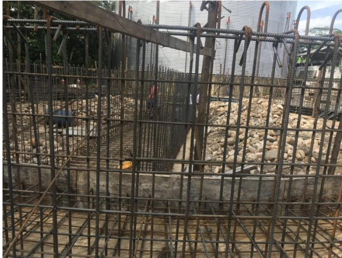
Figura No.20: Instalación de Formaleta y Acero
