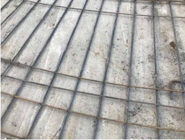
Figura No.14: Acero de 5/8" y 1/2"
