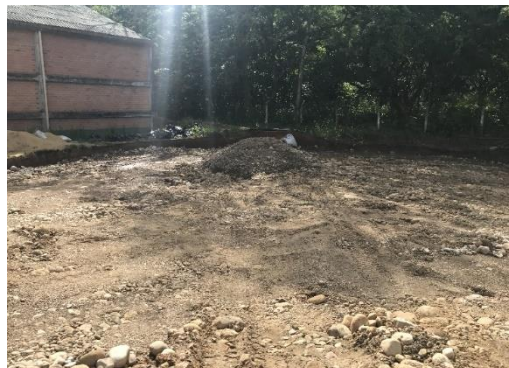
Figura No.13: Terreno con material listo para compactar
