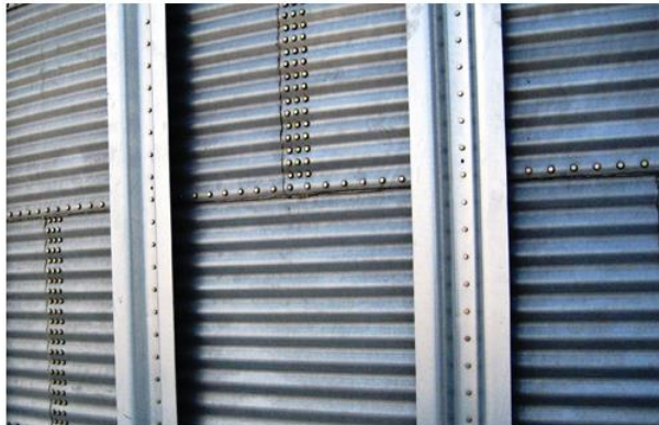
Figura No.5: Refuerzos del Silo Fuente: http://pradosilos.com/
