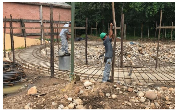
Figura No.17: Instalación de estacas para armado de acero
