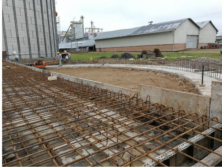
Figura No 42 : Colocación, verificación y nivelación de aceros.
