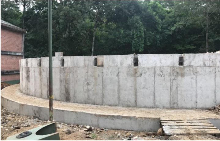
Figura No.25: Retiro de formaleta
