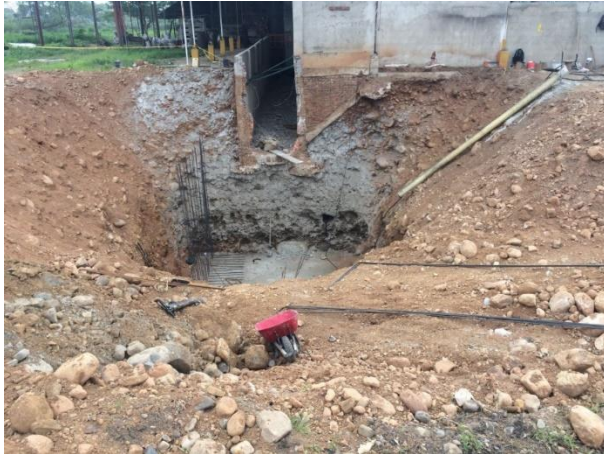
Figura No.43: Construcción foso para elevador # 1.
