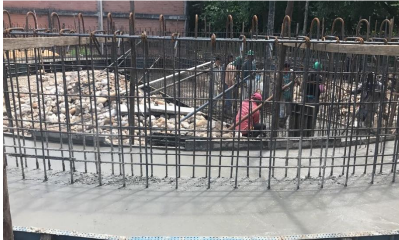
Figura No.22: Vibrado del concreto
