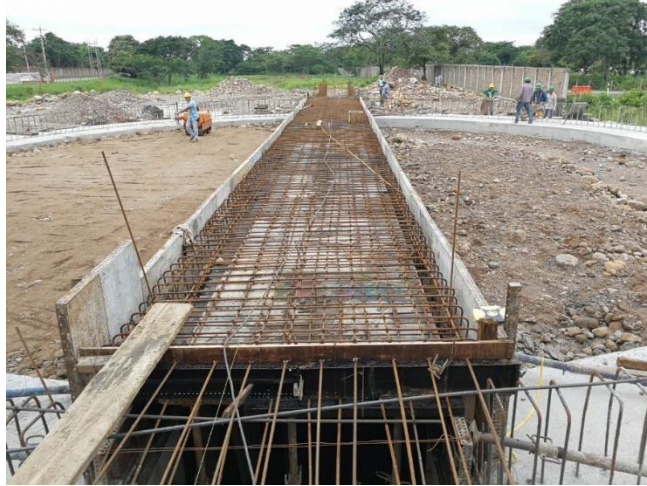
Figura No 40. : Acero de refuerzo para túnel de descarga
