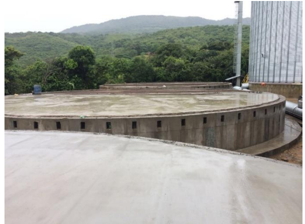
Figura No 49: Construcción total bases.
