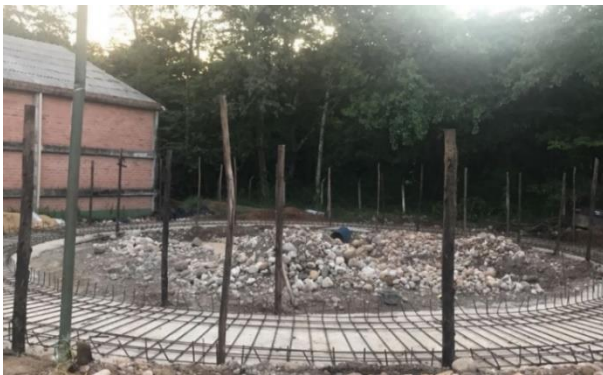
Figura No.16: Estacas de Madera Instaladas
