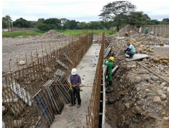
Figura No 41 : Colocación, verificación y nivelación de aceros.
