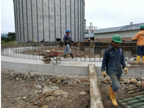
Figura No.46: Construcción base para silo
