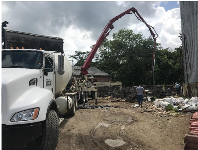
Figura No.21: Mixer lista para fundir zapata.
