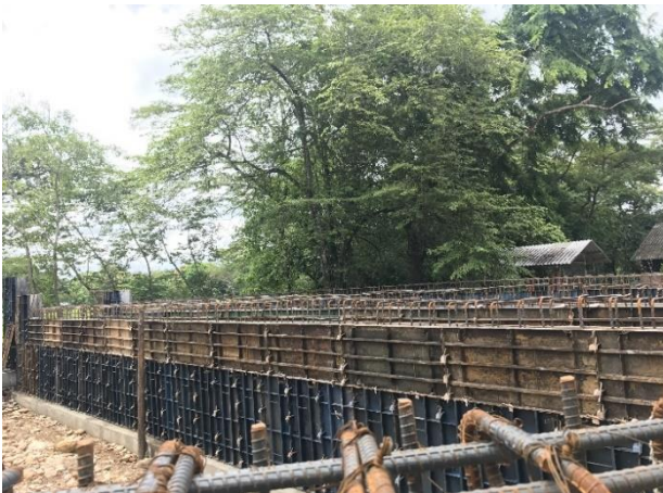
Figura No.23: Retiro de Formaleta de Zapata
