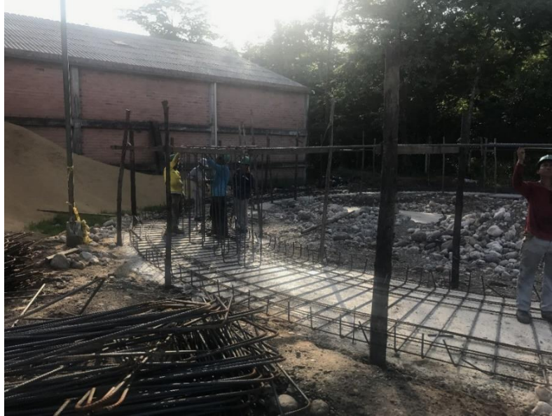
Figura No.18: Armado del acero
