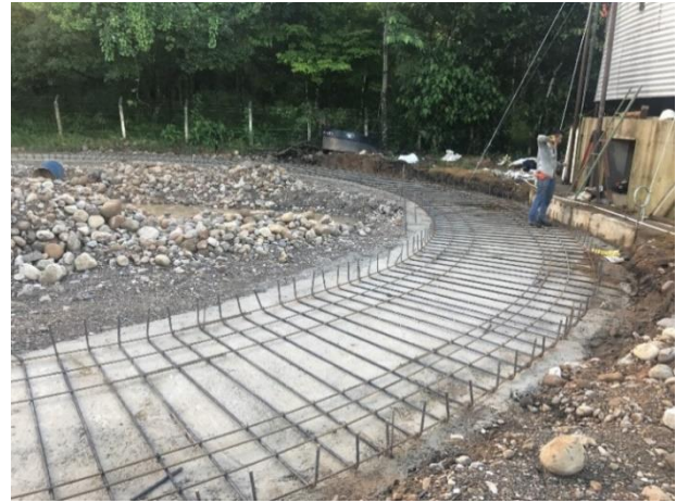
Figura No.15: Estructura de Acero
