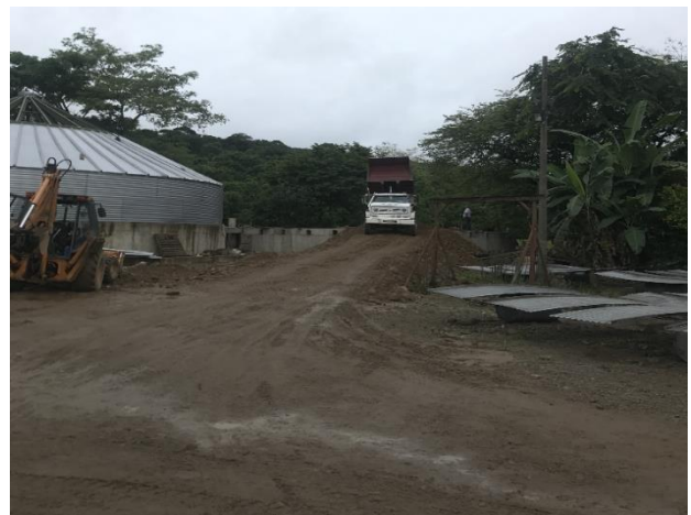
Figura No.28: Vía alterna para entrada y salida de volquetas con material
