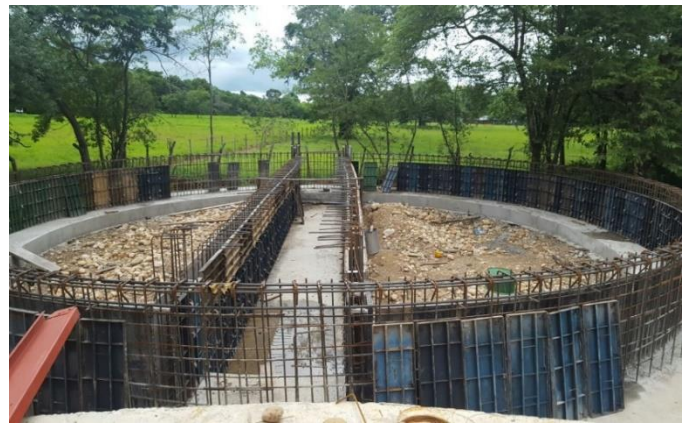
Figura No.24: Instalación de Formaleta del anillo
