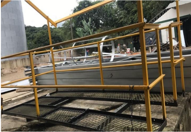
Figura No 32: Pasarela para mantenimiento
