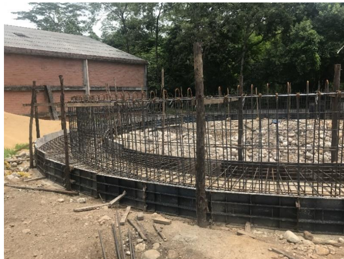
Figura No.19: Instalación de Formaleta
