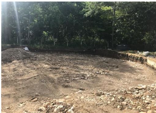
Figura No.12: Terreno con material listo para compactar
