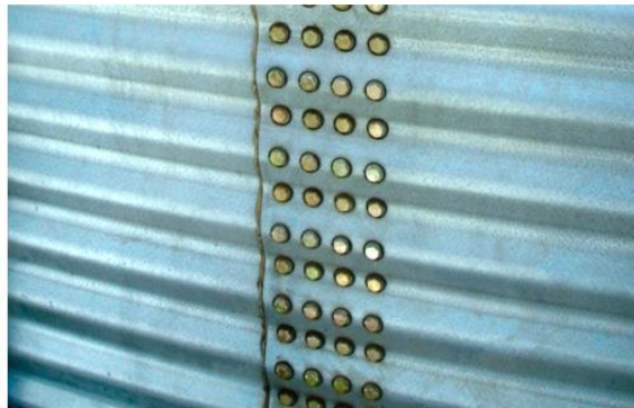
Figura No.8: Espigado del Silo Fuente: http://pradosilos.com
