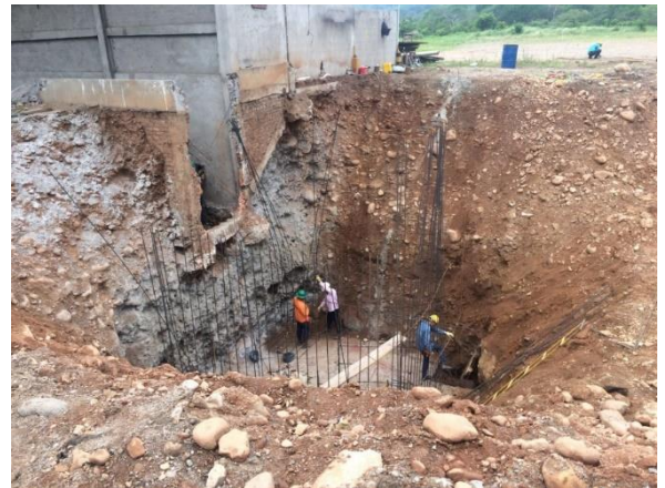
Figura No.44: Construcción foso para elevador # 1.
