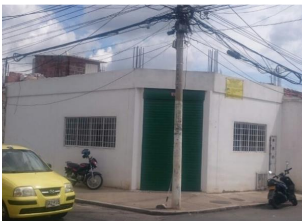
Imagen 6. Estado actual del predio con Licencia Urbanística No. 68001-2-16-0198
