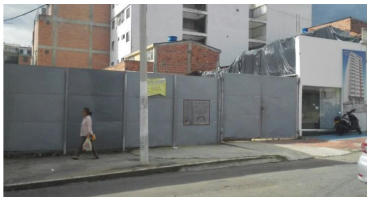
Imagen 10. Estado actual del predio con Licencia Urbanística No. R-0036-16
