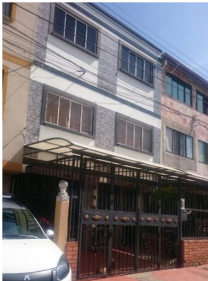
Imagen 4. Estado actual del predio con Licencia Urbanística No. 68001-2-15-0379
