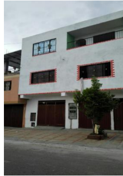
Imagen 11. Estado actual del predio con Licencia Urbanística No. 68001-1-17-0028
