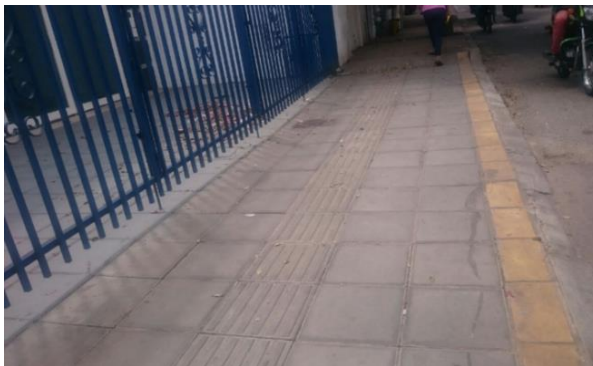
Imagen 5. Estado actual del predio con Licencia Urbanística No. 68001-2-16-0123
