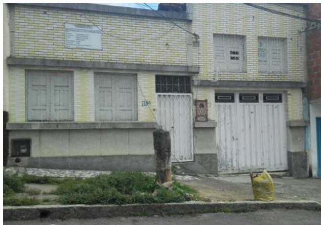
Imagen 8. Estado actual del predio con Licencia Urbanística No. R-0023-16
