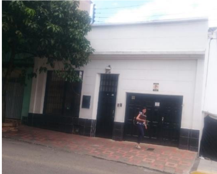
Imagen 2. Estado actual del predio con Licencia Urbanística No. 68001-1-13-0488
