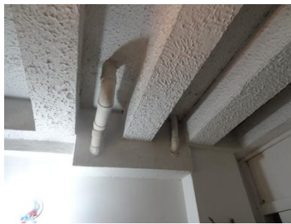
Imagen 26. Estado actual del predio identificado con GDT 4298-2. Aislamiento posterior construido.
