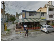
Imagen 48. Estado del predio identificado con GDT 4507-3 en septiembre de 2013
