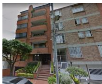
Imagen 46. Estado del predio identificado con GDT 4507-2 en septiembre de 2013
